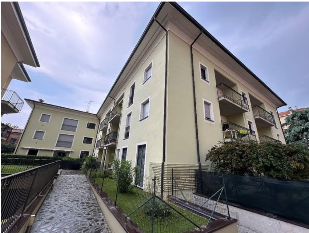
Fabbricato - Vista da parti comuni (foto 1)
