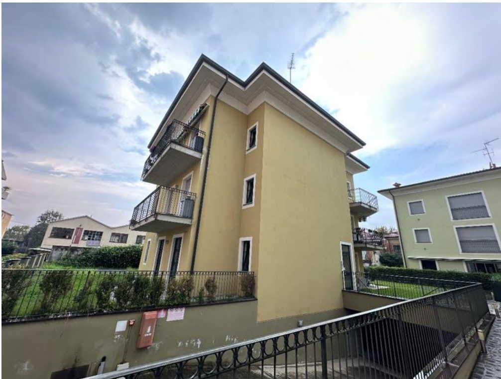
Fabbricato - Vista da parti comuni (foto 3)
