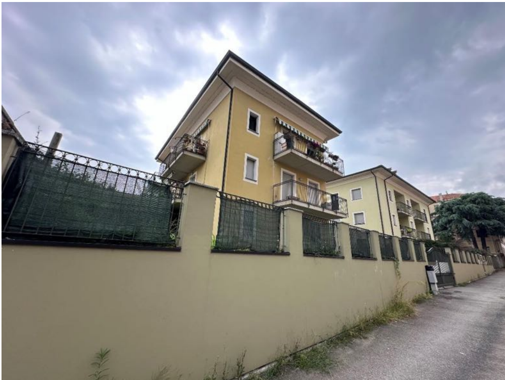
Fabbricato - Vista da strada (foto 1)
