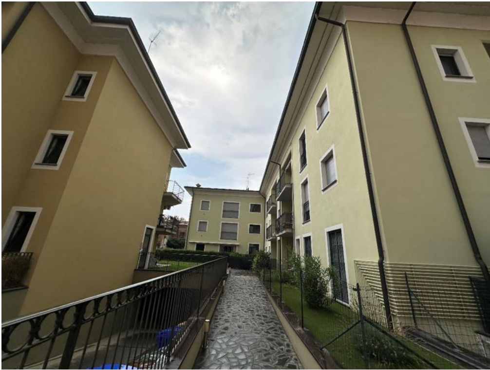
Fabbricato - Vista da parti comuni (foto 2)
