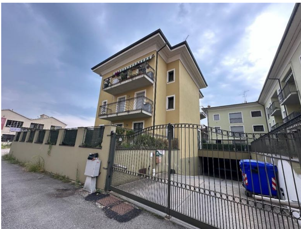
Fabbricato - Vista da strada (foto 3)
