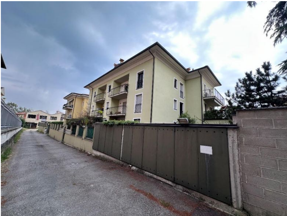
Viale Partigiani - Strada di accesso (foto 2)
