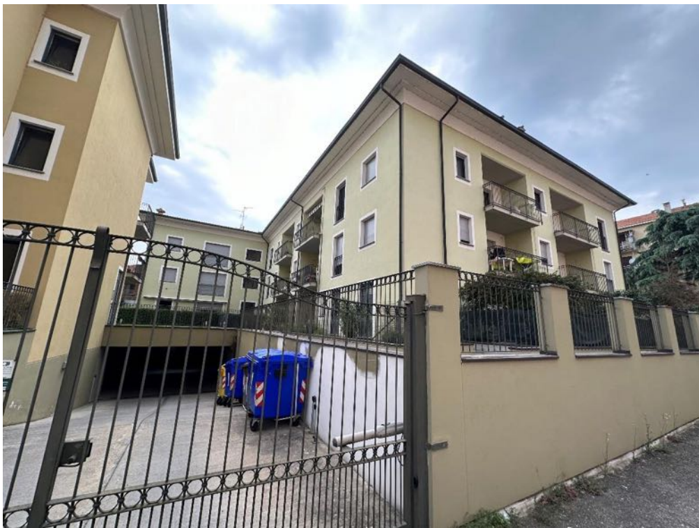
Fabbricato - Vista da strada (foto 2)
