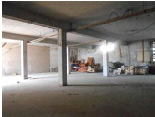
vano principale interno
