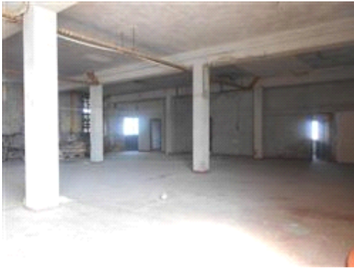
vano principale interno
