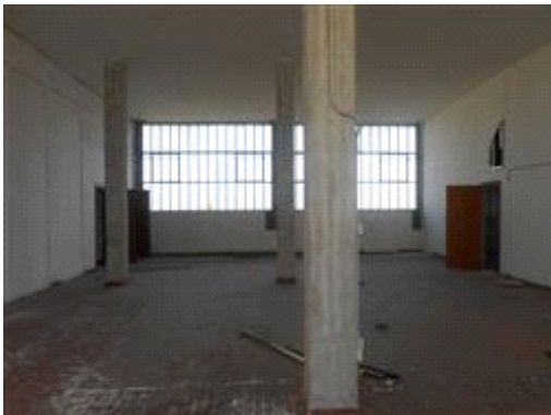
vano principale interno
