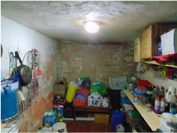
Immagine n°67 Piano Interrato
