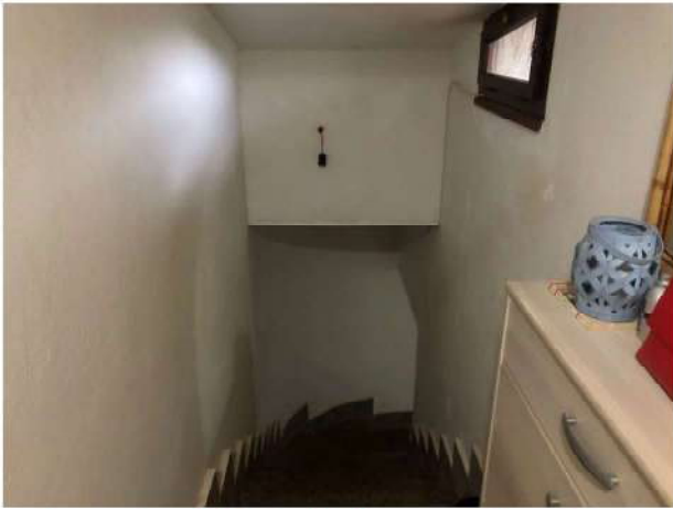
Immagine n°35 Scale Accesso Piano Primo
