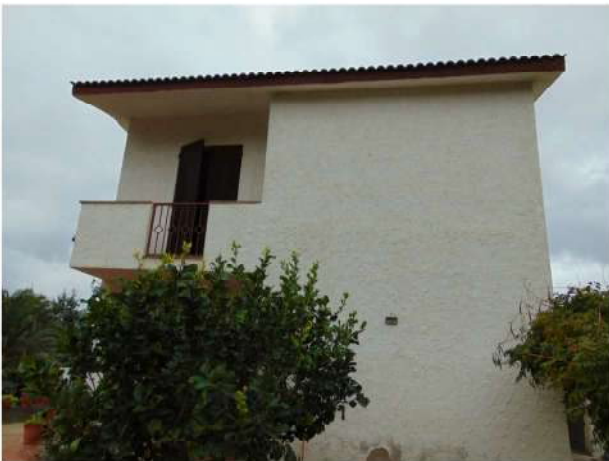
Immagine n°9 Facciata Lat. Destra
