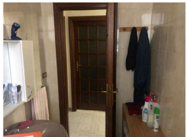
Immagine n°40 Bagno Piano Primo
