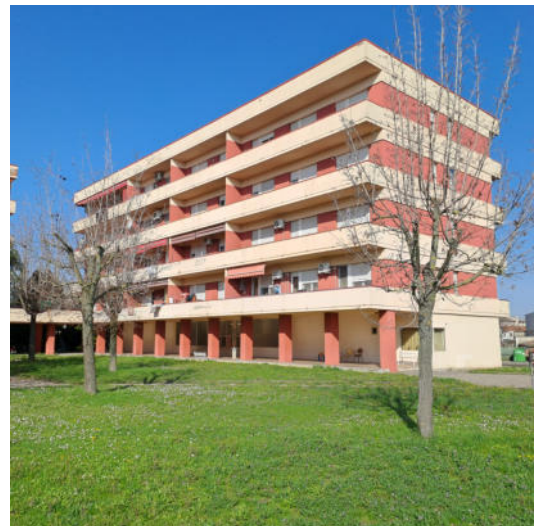
Foto 4 – Immobile in cui si trova l'abitazione al P5.
