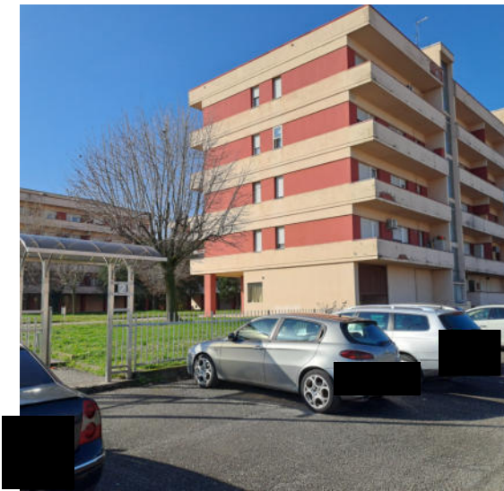
Foto 1 – Ingresso condominiale dalla Via Calabria
