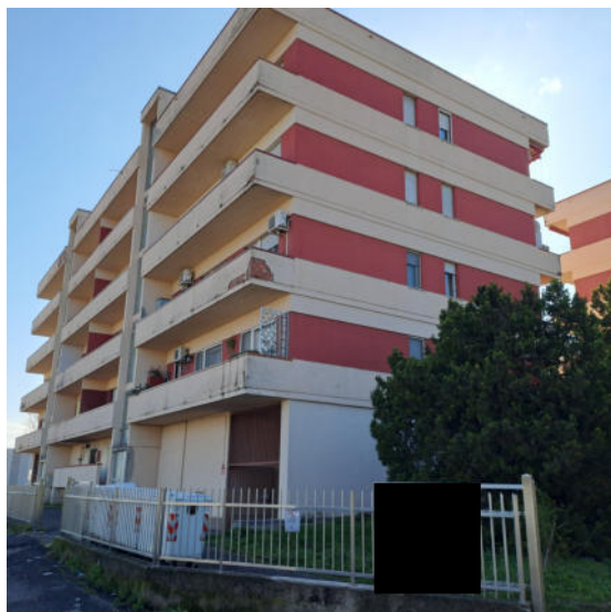
Foto 5 – Fabbricato condominiale dalla Via Calabria.
