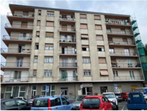
1 prospetto su piazza Carpaneto
