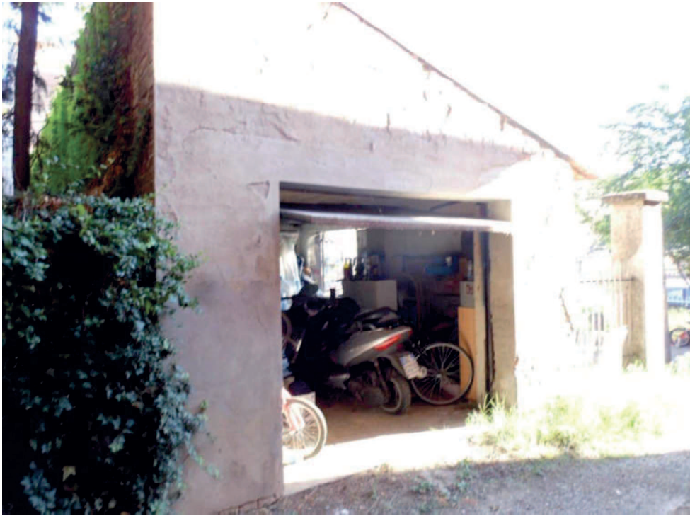
Foto 7 Prospetto laterale da vicolo privato mapp.888 sub.1
