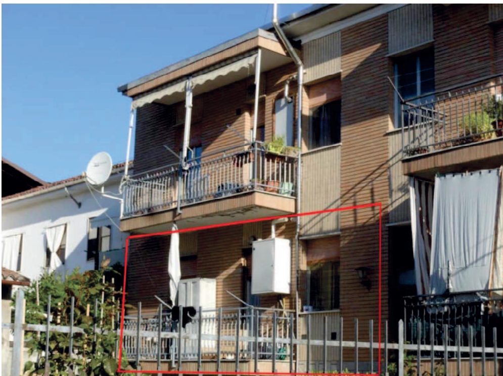
Foto 2 Prospetto alloggio mapp.851 sub.1
