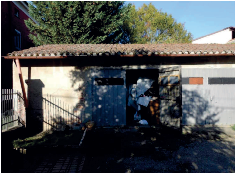
Foto 6 Prospetto frontale da sedime interno mapp.888 sub.1
