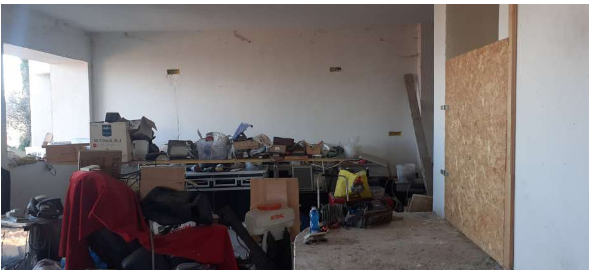
Foto n. 7: piano terreno in ristrutturazione
