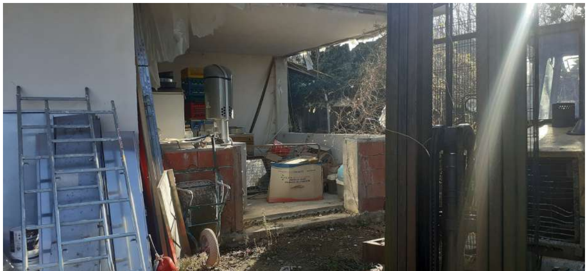
Foto n. 6: piano terreno in ristrutturazione
