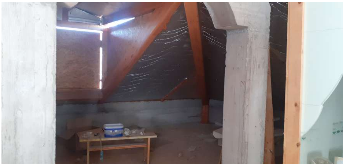
Foto n. 13: piano terreno in ristrutturazione
