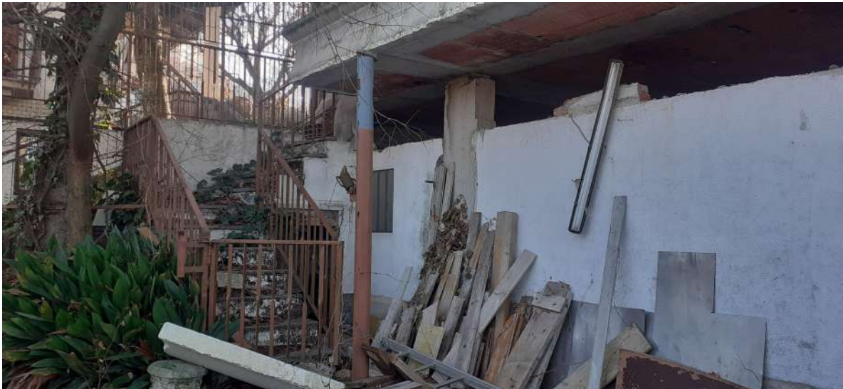
Foto n. 5: scala esterna di accesso al piano primo
