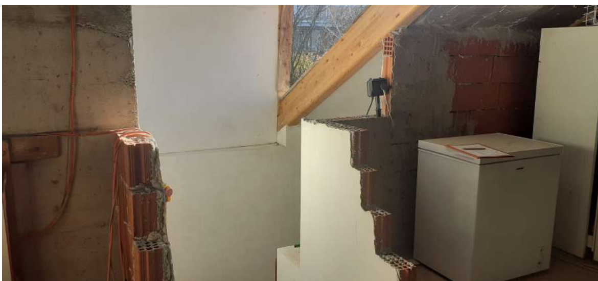
Foto n. 12: piano terreno in ristrutturazione
