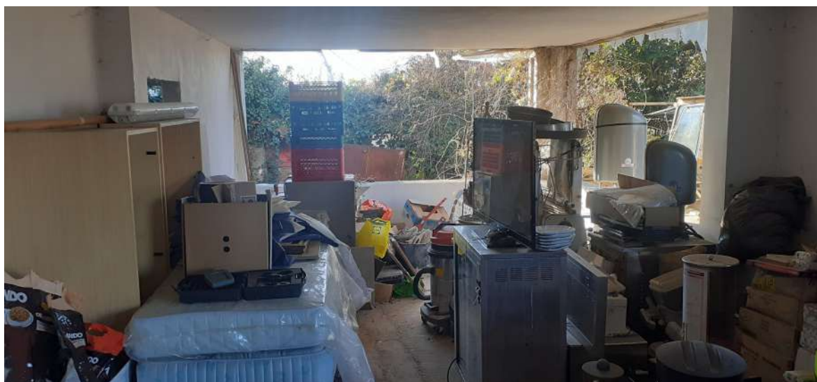
Foto n. 8: piano terreno in ristrutturazione
