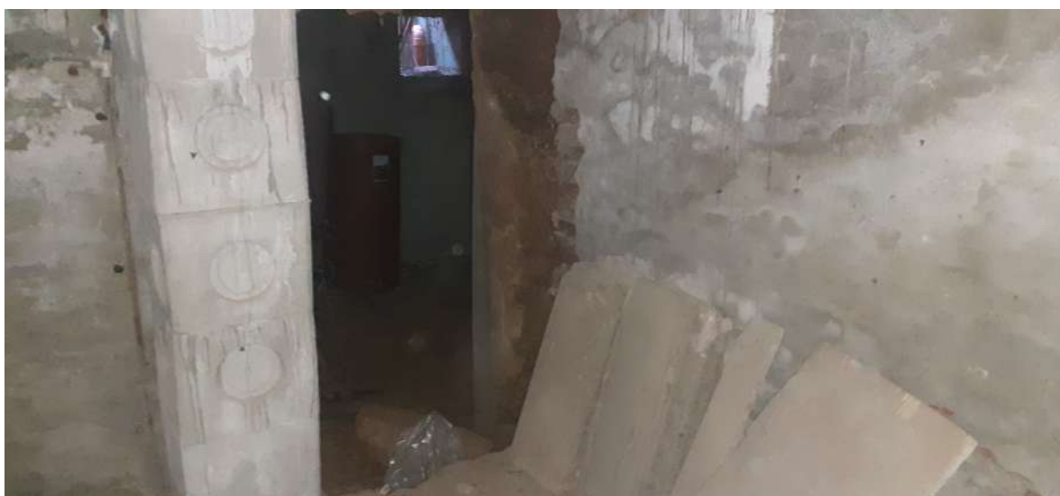
Foto n. 15: accesso al locale cantina
