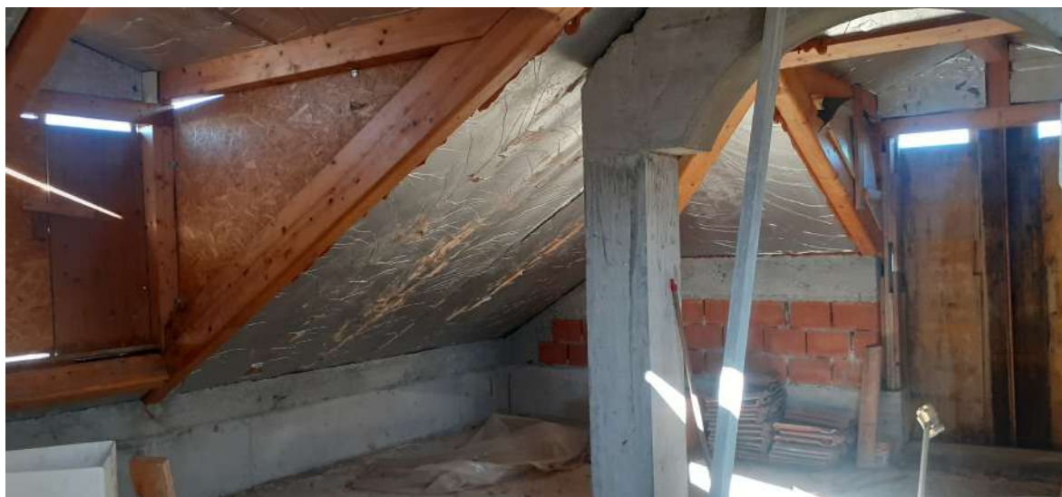
Foto n. 14: piano terreno in ristrutturazione
