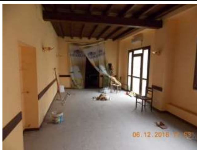
RIPRESA FOTOGRAFICA 11 PORZIONE OGGETTO DI DEMOLIZIONE
