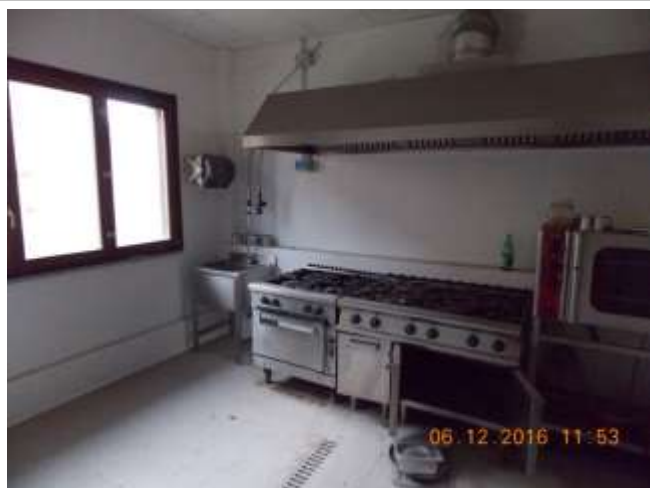
RIPRESA FOTOGRAFICA 12 PORZIONE OGGETTO DI DEMOLIZIONE
