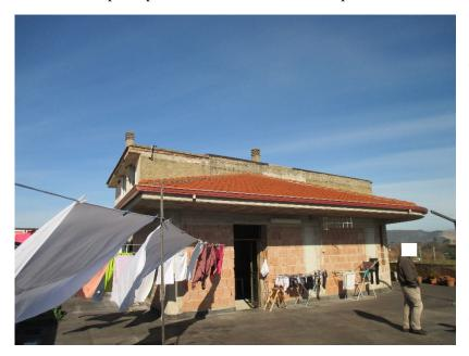
a vista l'intelaiatura in c.a. portante e mattoni laterizio forato per le murature di tompagno; la copertura degli immobili è piana sia (in corrispondenza della superficie terrazzata dell'appartamento al primo piano), sia a falde inclinate con tegole a
