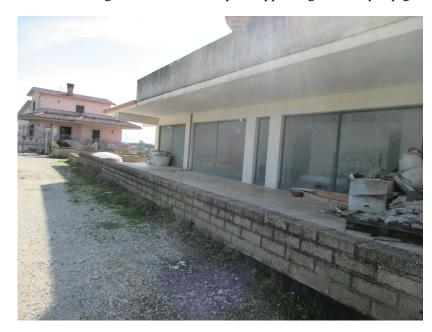
fuori terra (piano terra + un piano in elevazione) ed un livello interrato. Il fabbricato ha complessivamente una pianta a forma quasi trapezia, è in struttura portante intelaiata in c.a. con solai laterocementizi; è edificato in aderenza ad altro piccolo fabbricato
