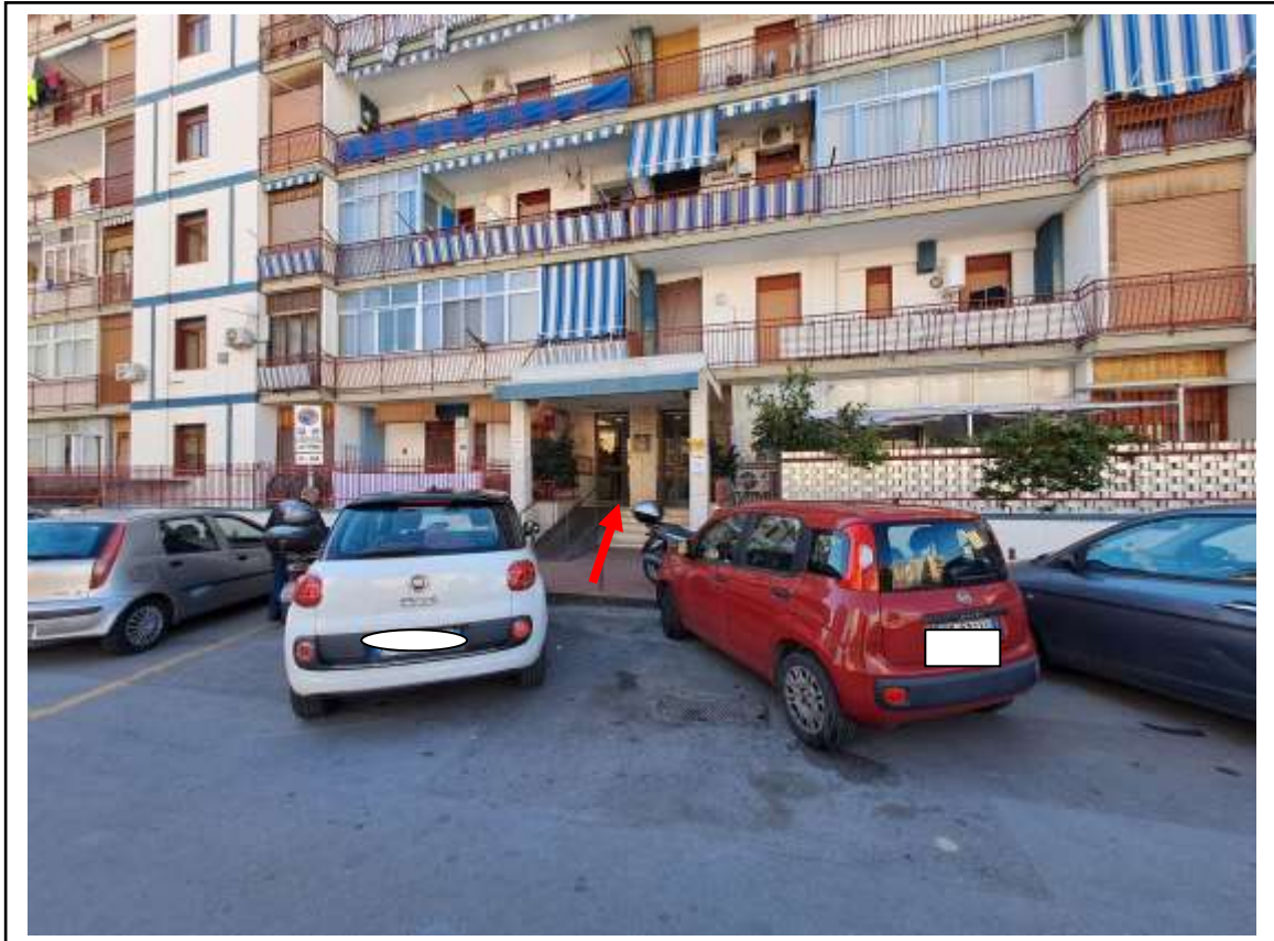
Foto n. 3 – Immobile sito Palermo, Via Sirio n. 9, piano 7°. Vista del portone di accesso
