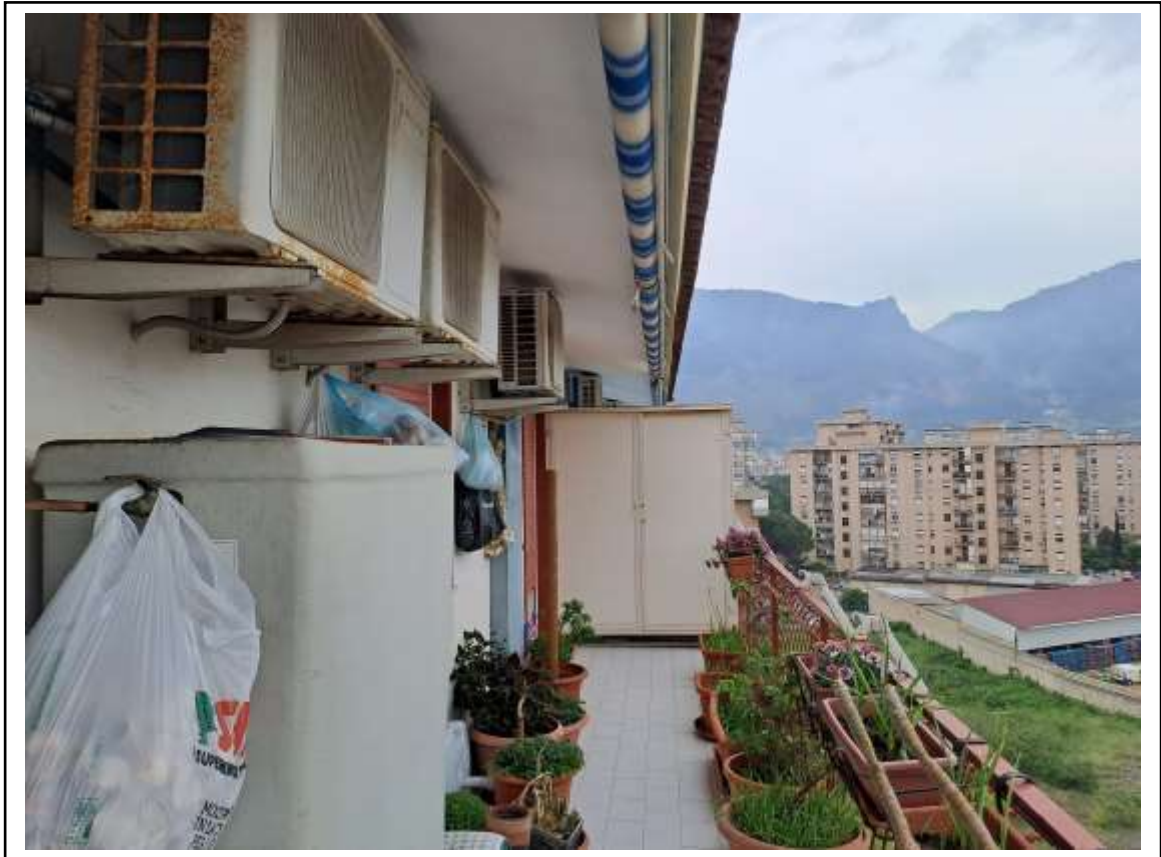
Foto n. 14 – Immobile sito Palermo, Via Sirio n. 9, scala A, piano 7°. Balcone lato slargo compreso tra Via Sirio e Via Sagittario
