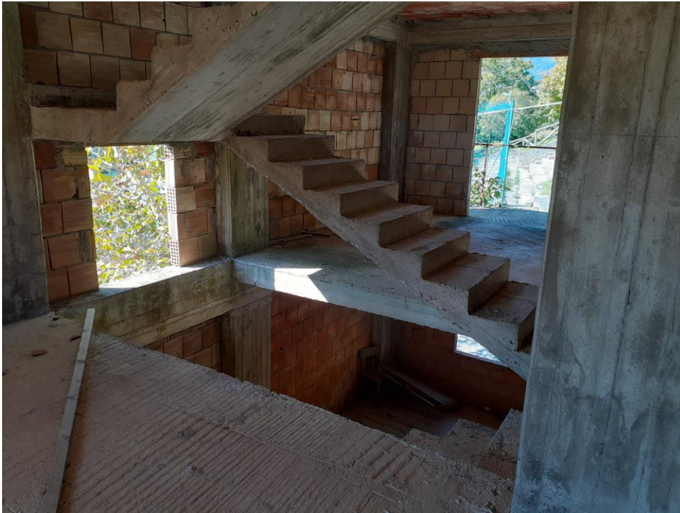
Foto n. 10: Piano primo S 2p del fabbricato sito in via Fosso del comune di Platania, (unità censita in catasto fabbricati del comune di Platania, al foglio di mappa 11, particella 323, sub 2).
