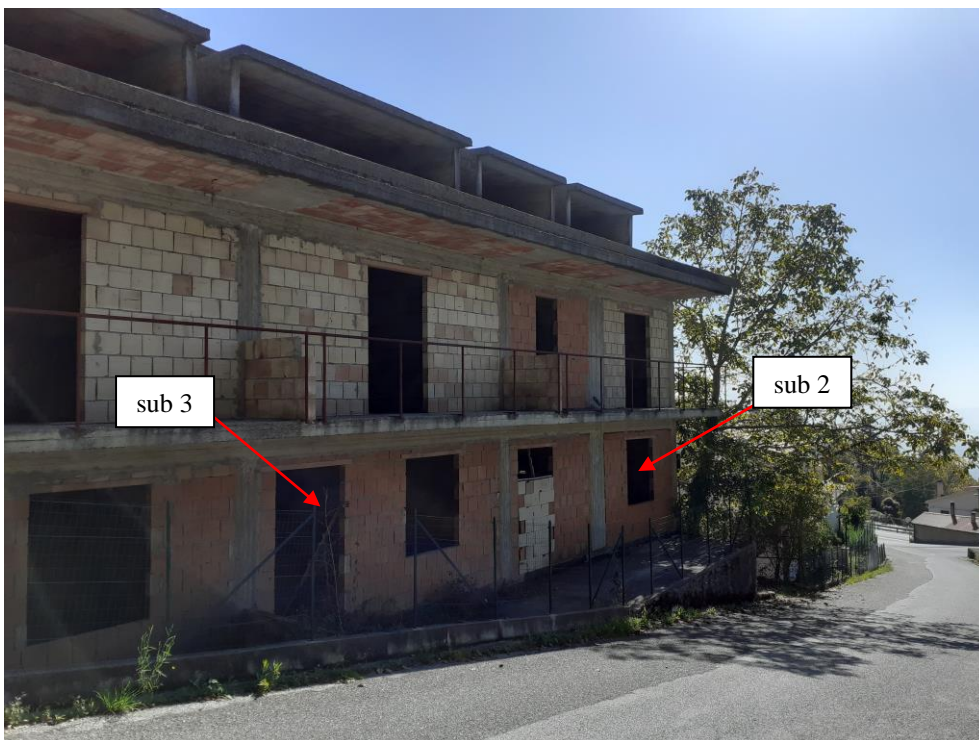
Foto n. 1: Prospetto Ovest del fabbricato sito in via Fosso del comune di Platania, contenente le unità staggite censite in catasto fabbricati del comune di Platania , al foglio di mappa 11, particella 323, sub 2 e 3.
