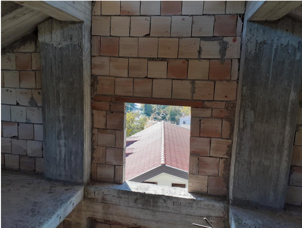
Foto n. 16: Piano secondo S 2c del fabbricato sito in via Fosso del comune di Platania, (unità censita in catasto fabbricati del comune di Platania, al foglio di mappa 11, particella 323, sub 2).
