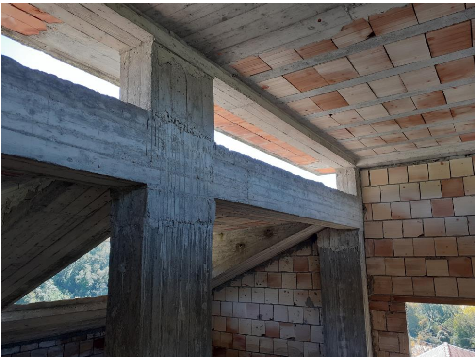
Foto n. 17: Piano secondo S 2c del fabbricato sito in via Fosso del comune di Platania, (unità censita in catasto fabbricati del comune di Platania, al foglio di mappa 11, particella 323, sub 2).
