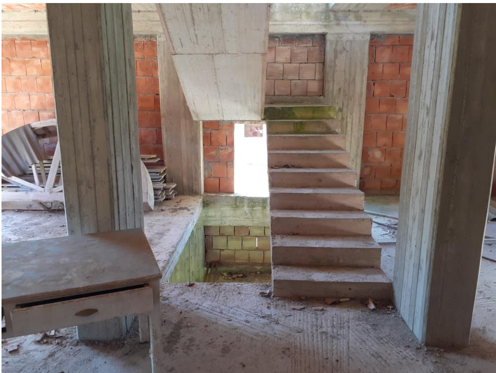
Foto n. 9: Piano terra S 2t del fabbricato sito in via Fosso del comune di Platania, (unità censita in catasto fabbricati del comune di Platania , al foglio di mappa 11, particella 323, sub 2).
