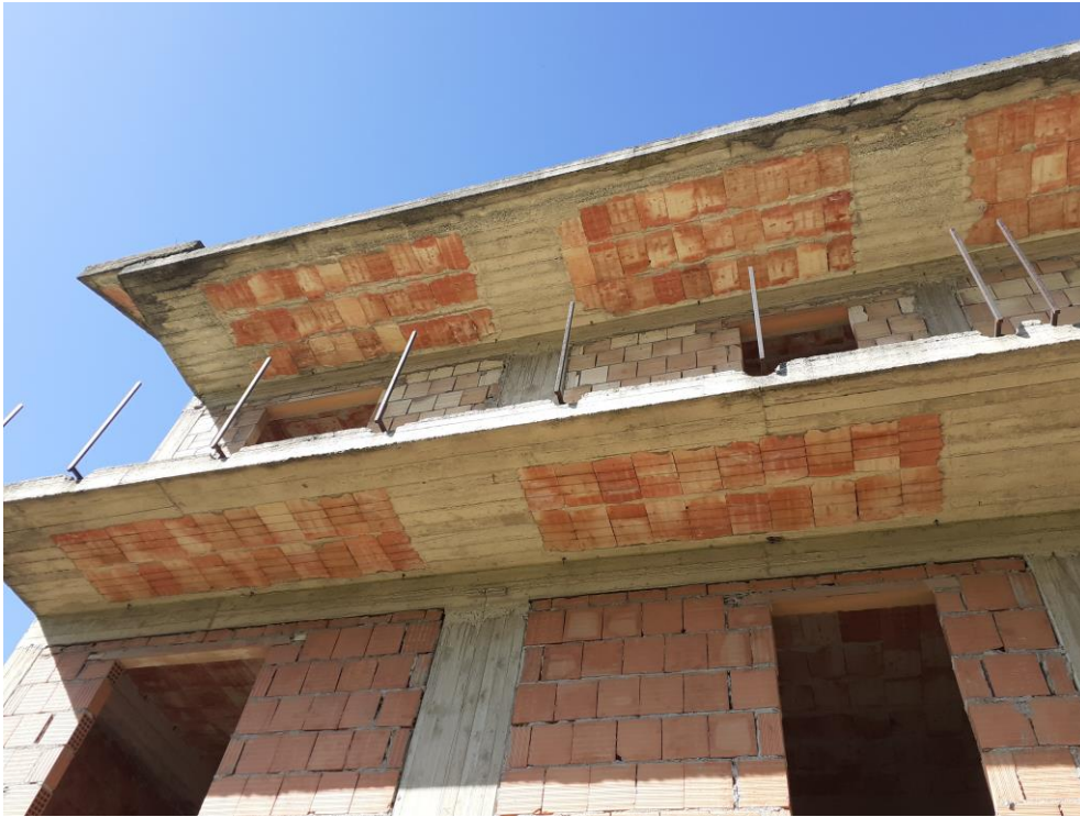
Foto n. 2 Prospetto Est del fabbricato sito in via Fosso del comune di Platania, (unità censita in catasto fabbricati del comune di Platania , al foglio di mappa 11, particella 323, sub 2).
