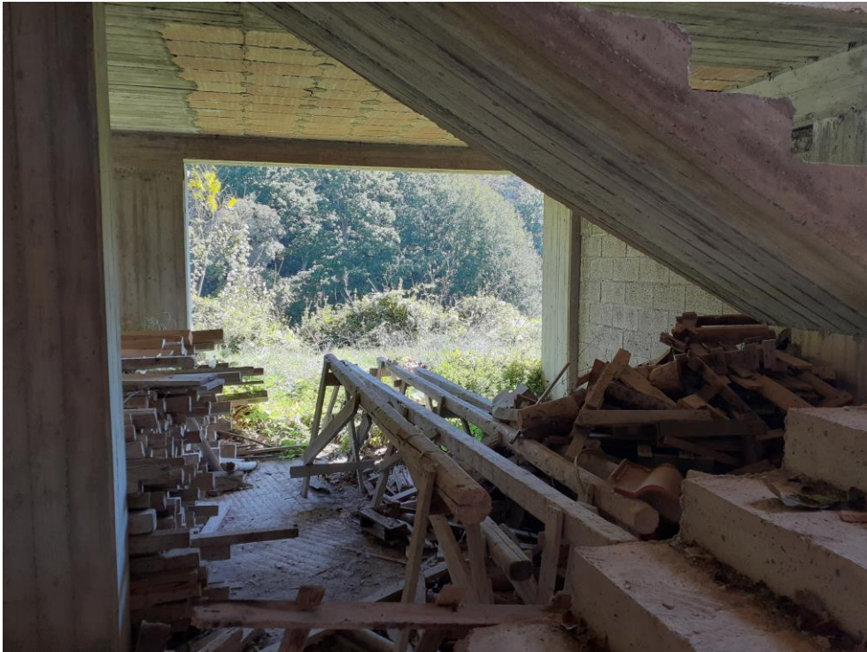
Foto n. 4: Piano seminterrato S 2s del fabbricato sito in via Fosso del comune di Platania, (unità censita in catasto fabbricati del comune di Platania, al foglio di mappa 11, particella 323, sub 2).
