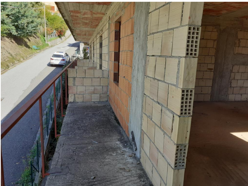
Foto n. 13: Balcone del piano primo S 2b del fabbricato sito in via Fosso del comune di Platania, (unità censita in catasto fabbricati del comune di Platania, al foglio di mappa 11, particella 323, sub 2).
