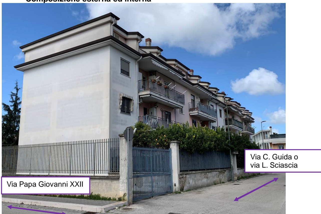
Foto 01 – Il fabbricato dall'incrocio tra via Guida e via Papa Giovanni XXIII
