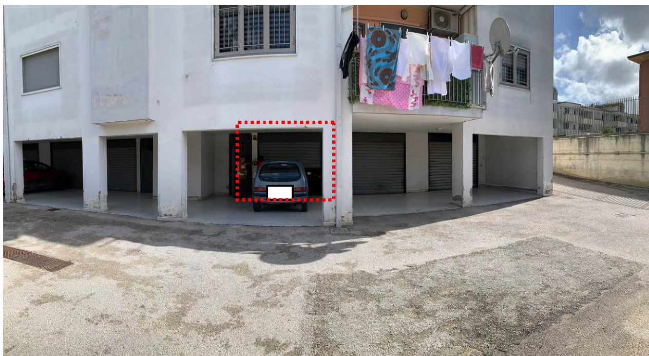
Foto 17 – Il box auto sub 18 dalla corte comune
