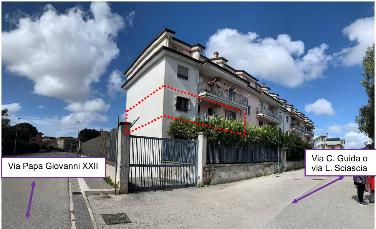
Foto 02 – Il fabbricato dall'incrocio tra via Guida e via Papa Giovanni XXIII
