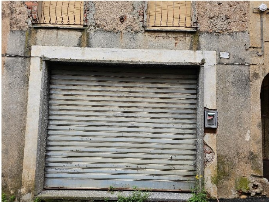
Foto 10 – Facciata su Via Cesare Cobiانchi
