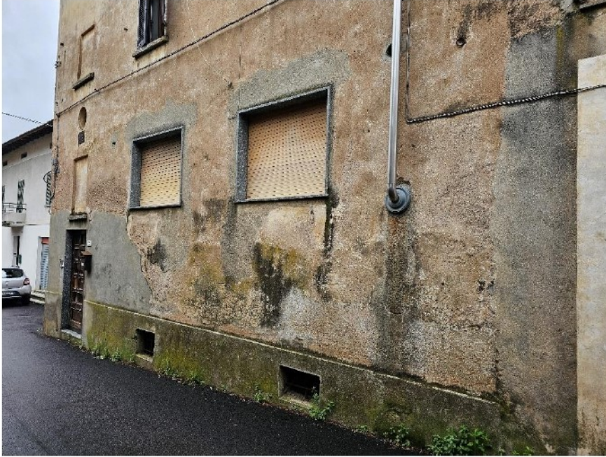
Foto 1 – Facciata su Via Cesare Cobiانchi
