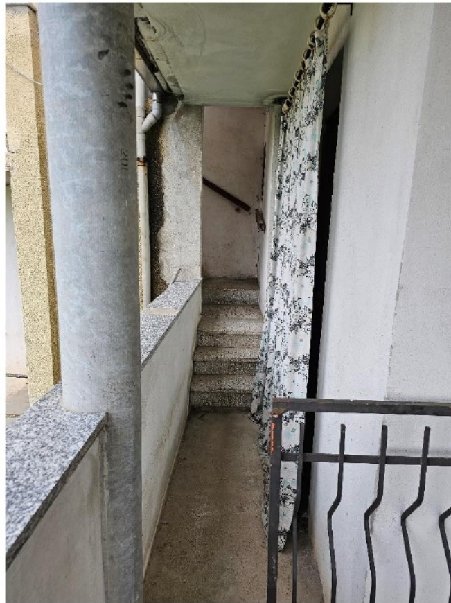
Foto 8 – Scala di collegamento tra sub. 4 e sub.7
