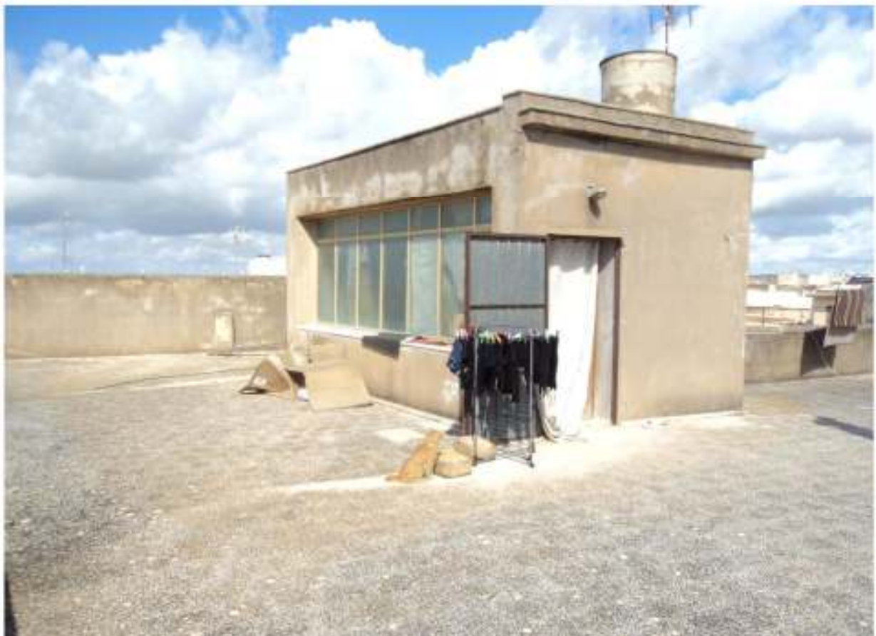
FOTO n° 20: Torrino scala e lastrico solare
