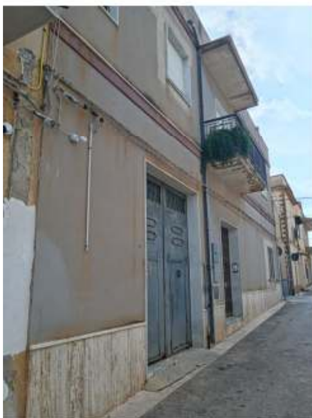
FOTO n° 4 Vista prospetto su Via dei Mille
