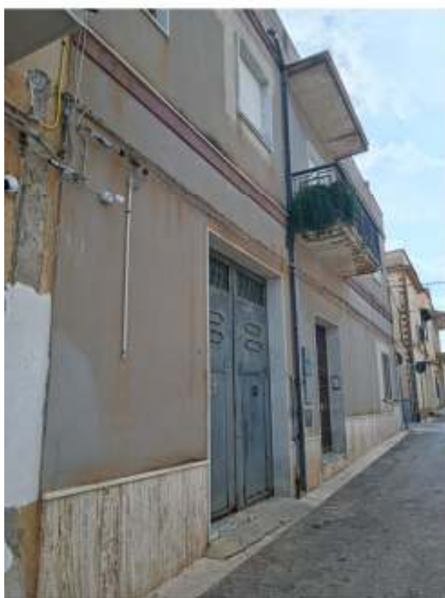
FOTO n° 4 Vista prospetto su Via dei Mille
