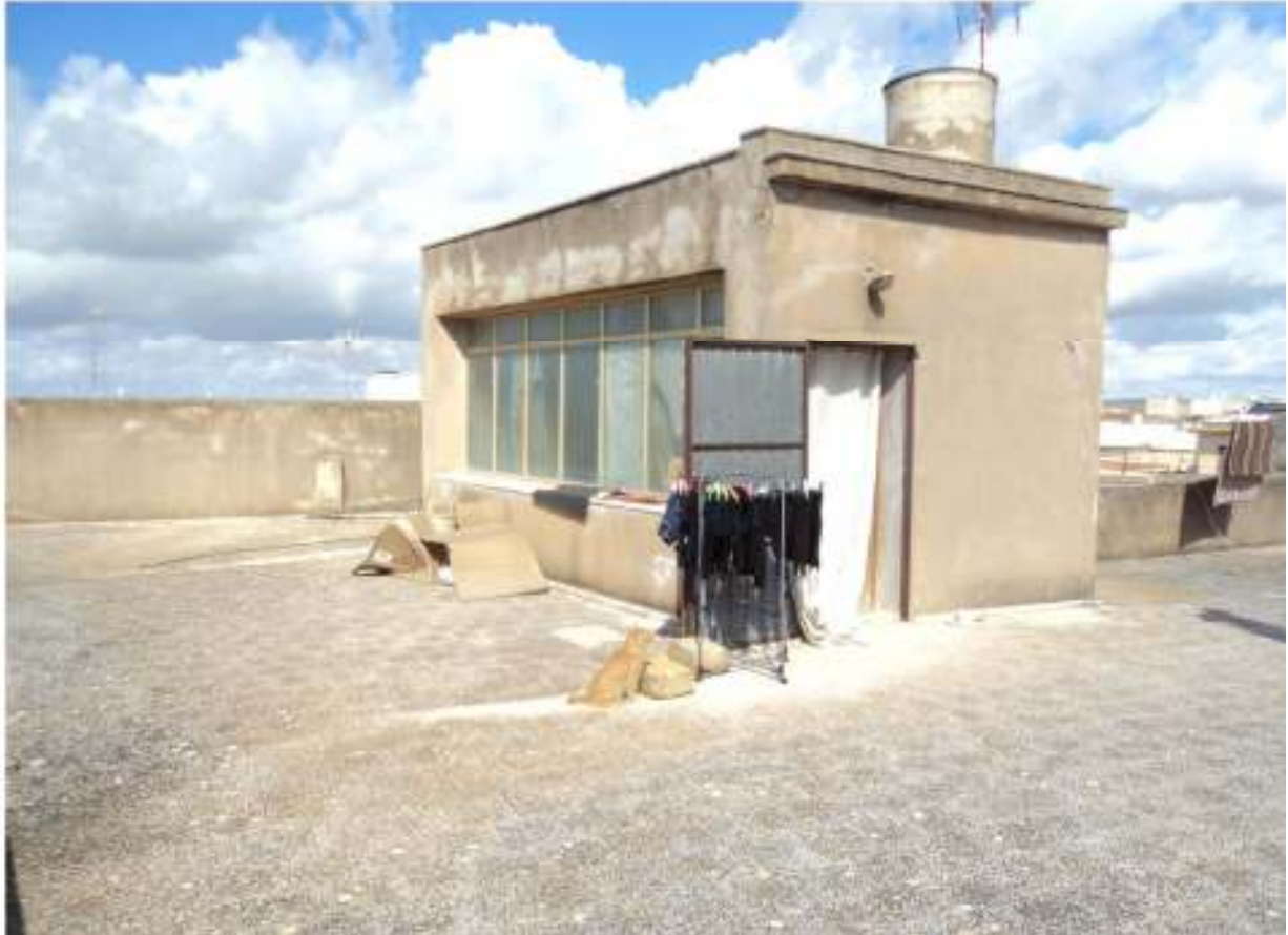
FOTO n° 19: Torrino scala e lastrico solare
