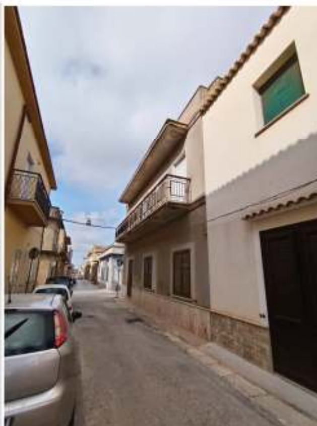
FOTO n° 5 Vista prospetto su Via Regina Margherita
