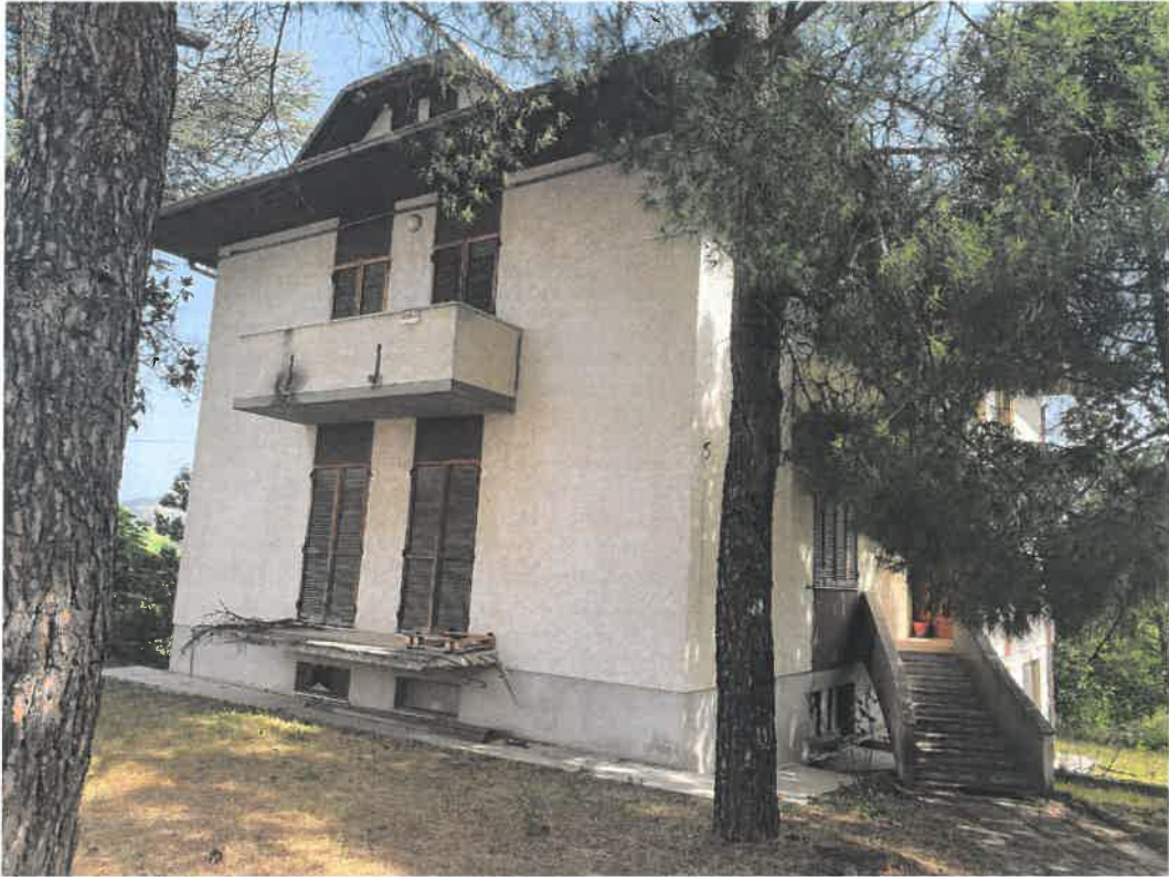
Foto 01 – prospetto fronte e fianco sinistro
