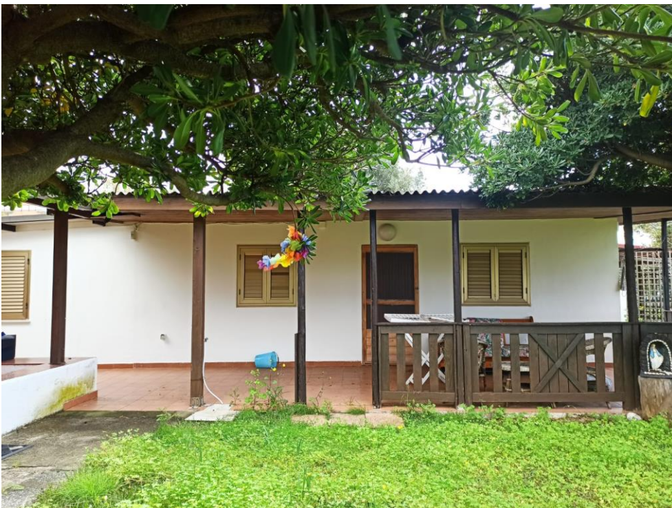
Foto n. 26: Volumi tecnici V T dell'immobile sito in località Cartolano del comune di Falerna, contenente l'unità staggita censita in catasto fabbricati del comune di Falerna , al foglio di mappa 9, particella 1224, sub 2.
