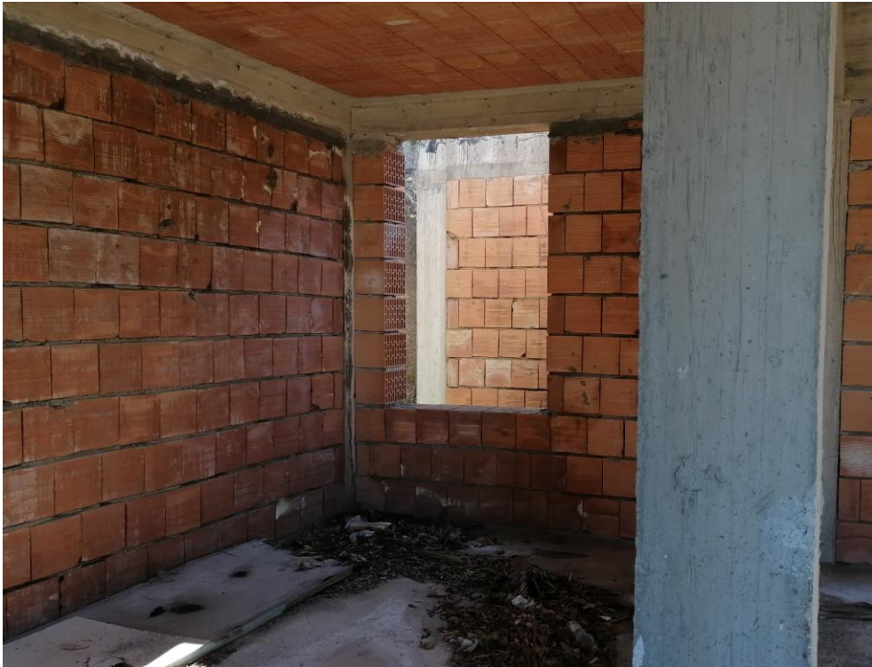
Foto n. 10: Rustico R 2 sito in località Cartolano del comune di Falerna, contenente l'unità staggita censita in catasto fabbricati del comune di Falerna, al foglio di mappa 9, particella 622.
