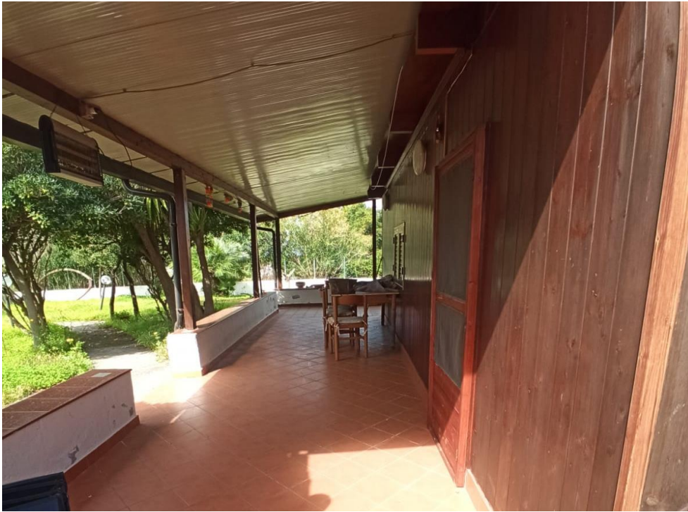
Foto n. 23: Portico P L dell'immobile sito in località Cartolano del comune di Falerna, contenente l'unità staggita censita in catasto fabbricati del comune di Falerna, al foglio di mappa 9, particella 1224, sub 2.
