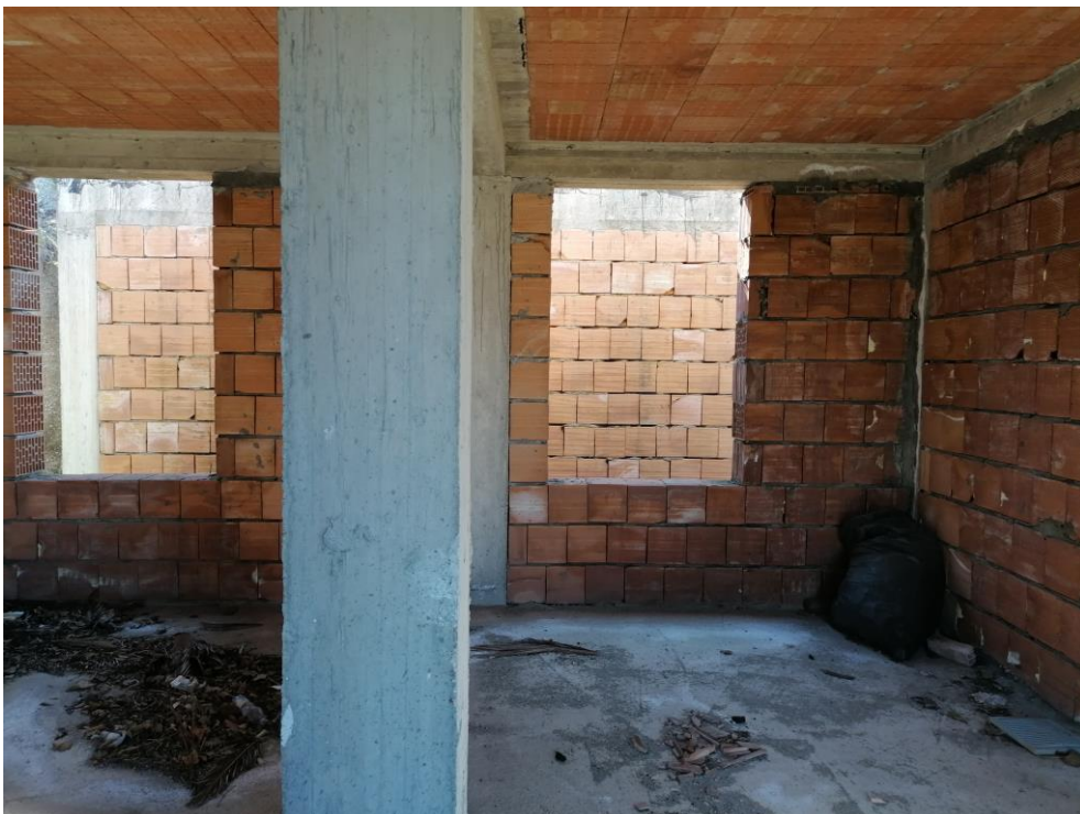
Foto n. 11: Rustico R 2 sito in località Cartolano del comune di Falerna, contenente l'unità staggita censita in catasto fabbricati del comune di Falerna, al foglio di mappa 9, particella 622.
