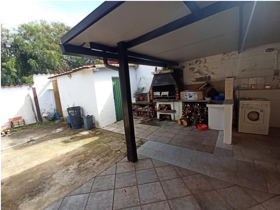
Foto n. 24: Volumi tecnici V T dell'immobile sito in località Cartolano del comune di Falerna, contenente l'unità staggita censita in catasto fabbricati del comune di Falerna, al foglio di mappa 9, particella 1224, sub 2.
