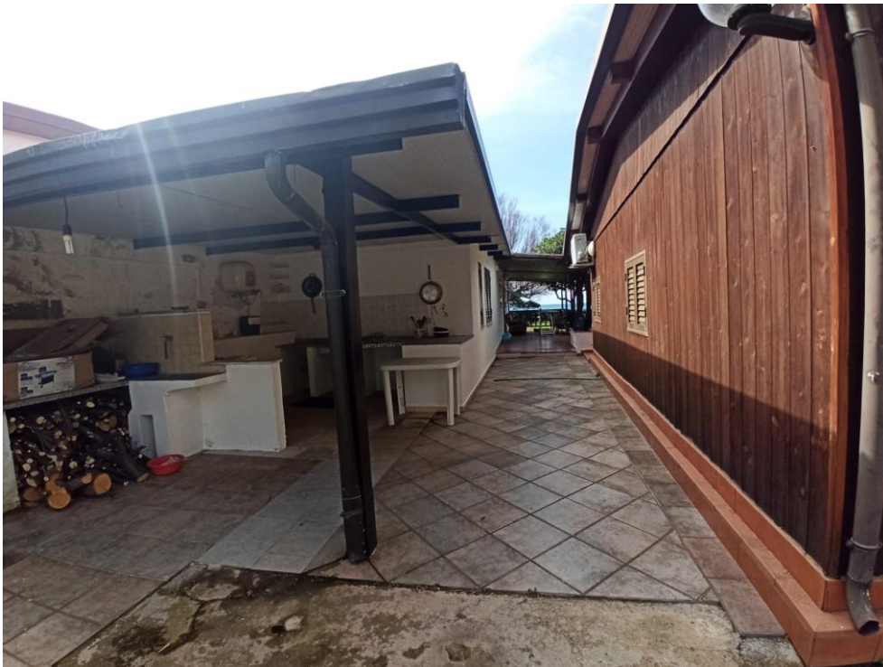
Foto n. 25: Volumi tecnici V T dell'immobile sito in località Cartolano del comune di Falerna, contenente l'unità staggita censita in catasto fabbricati del comune di Falerna , al foglio di mappa 9, particella 1224, sub 2.
