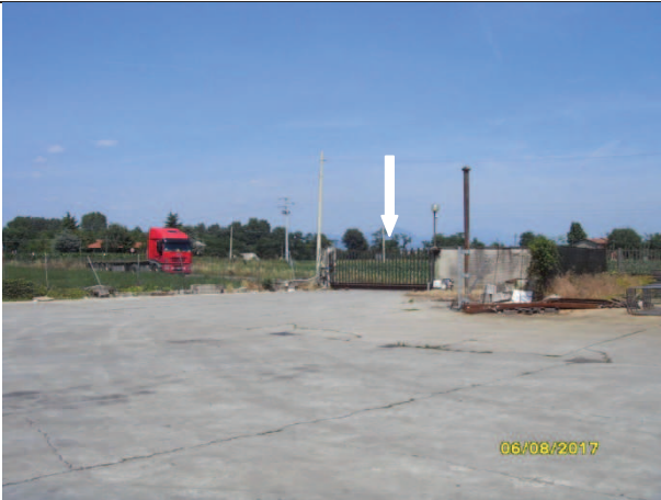
Unico accesso al compendio immobiliare
