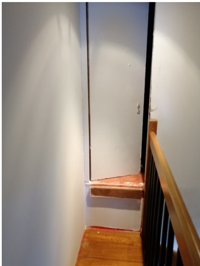
PORTA CHE CONSENTE IL POSSESSO DEL SOTTOTETTO CONFINANTE
