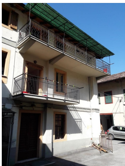
Part. 588 sub. 4 lato nord-est con ingresso dalla corte part. 587
