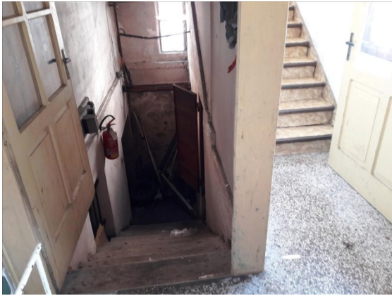
Part. 588 sub. 4 – PT - Ingresso e scale via Nuova 100
