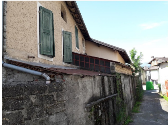
Part. 587 lato nord - PT sub. 1 e P2-P3 sub. 2
