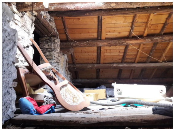
Part. 588 sub. 4 – P3 - Soffitta via Nuova 100
