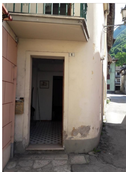
Part. 588 sub. 4 - Ingresso da via Molini 1
