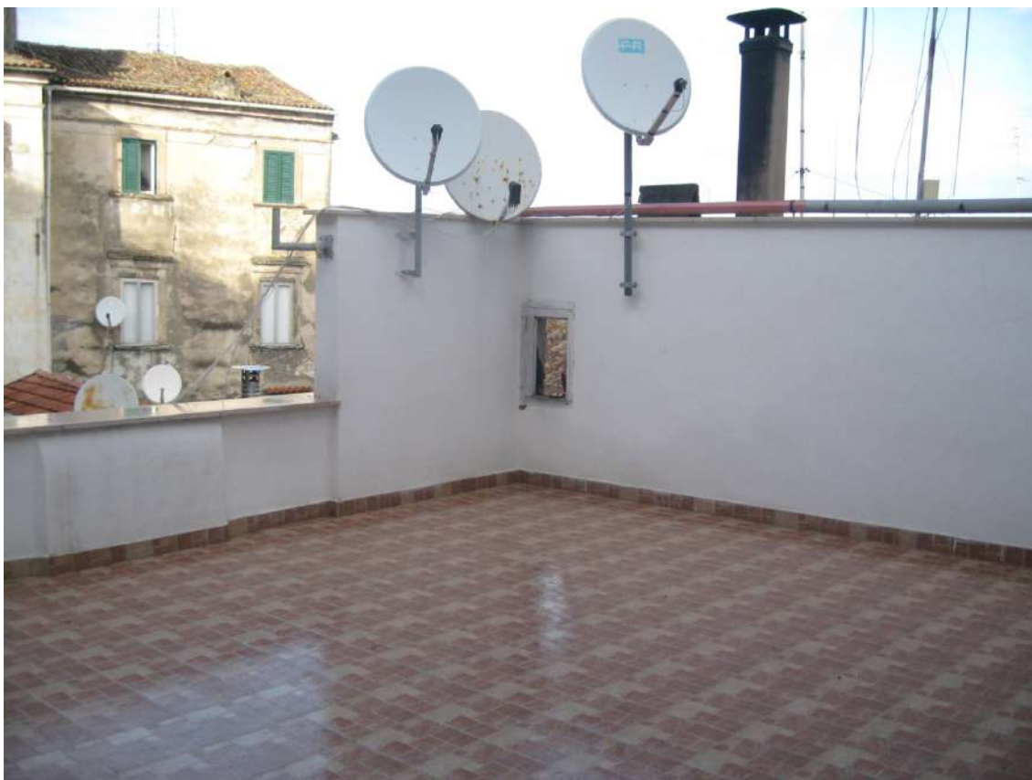
Foto n.6: terrazzo del lotto 12, vista lato Nord
