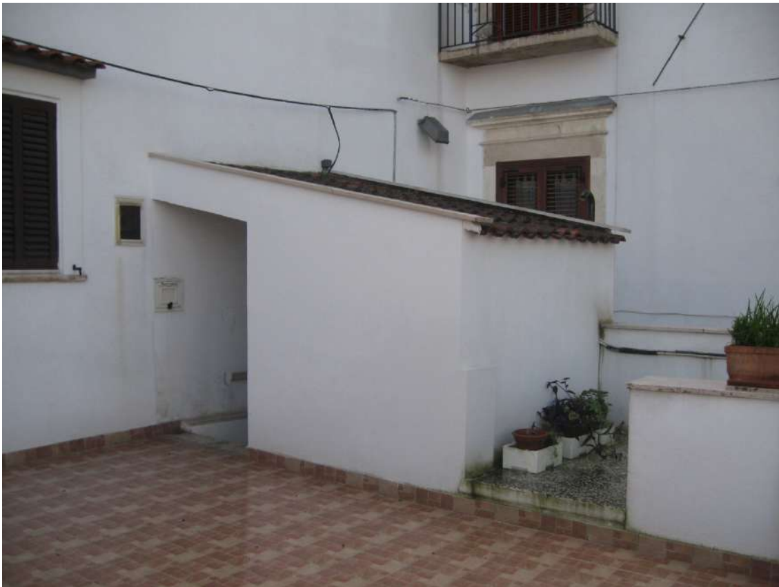
Foto n.3: vista del terrazzo e del vano scale di accesso
