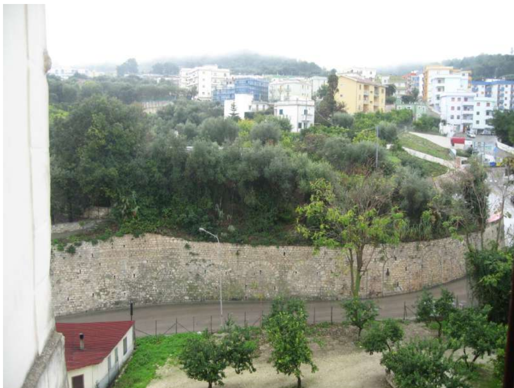
Foto n.20: vista panoramica da sul lato prospiciente Via Fontanella
