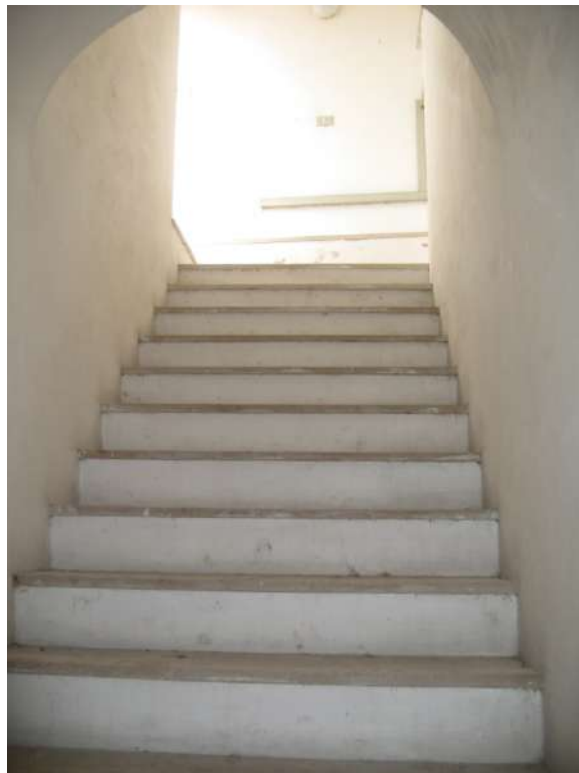
Foto n.34: vano scale che consente l'accesso al lotto in vendita tramite passaggio attraverso il terrazzo di proprietà altrui.
