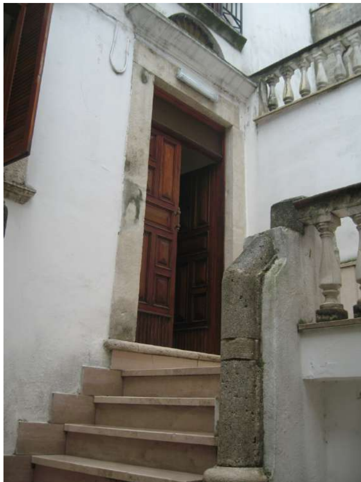
Foto n.5: ingresso al lotto 11, comune con altra proprietà ubicata al livello superiore
