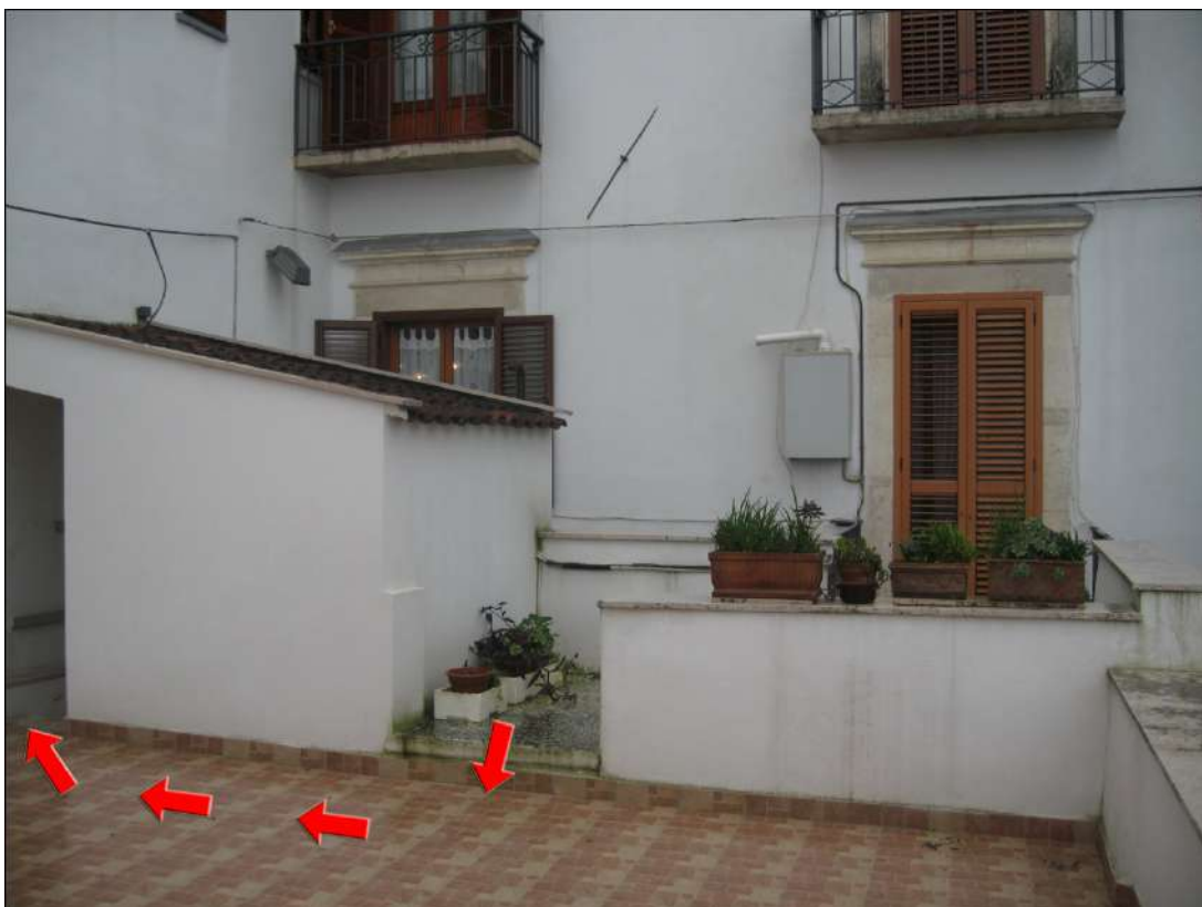
Foto n.31: le frecce indicano la servitù di passaggio che consente dal terrazzino, attraverso il passaggio sul terrazzo di proprietà altrui, di raggiungere il vano scale che conduce a Vico Galileo Galilei
