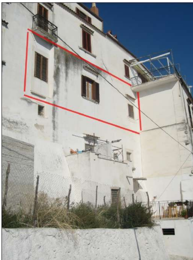
Foto n.19: il contorno rosso identifica il lotto 11, all'interno dello stabile, sul lato prospiciente Via Fontanella
