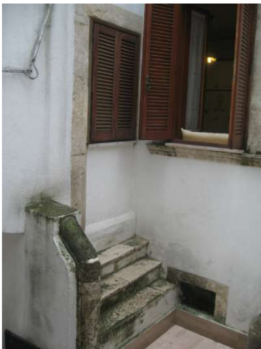
Foto n.8: prospetto esterno del lotto 11
