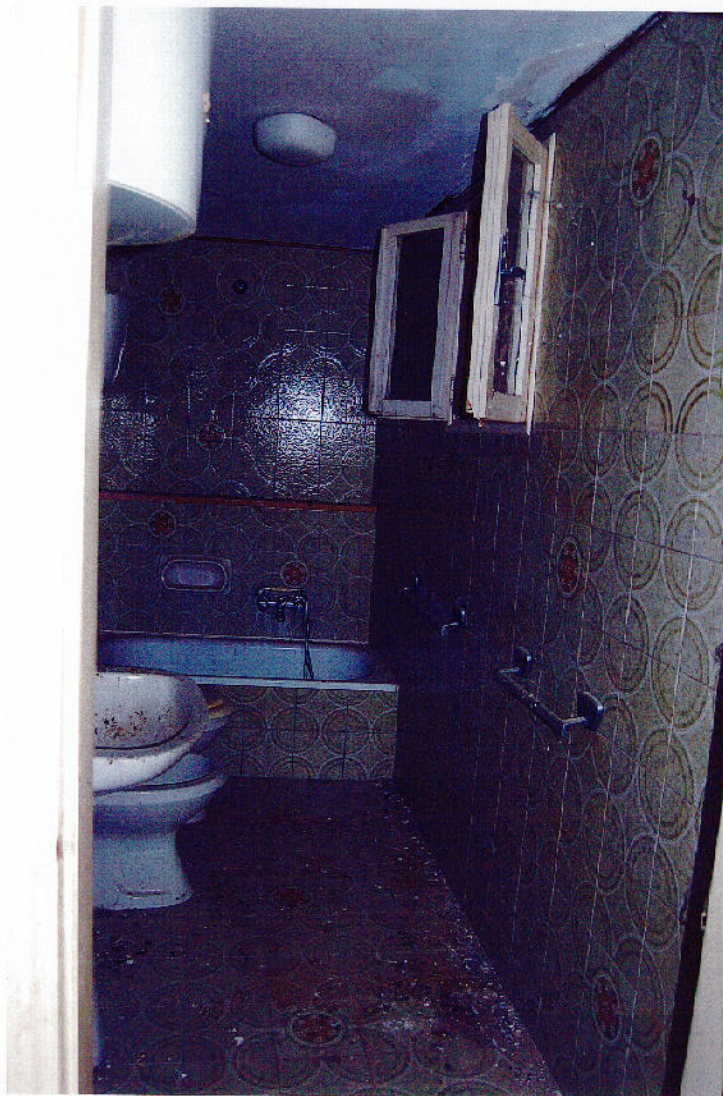
Foto n. 8 Part. 42 sub. 1 bagno al piano primo
