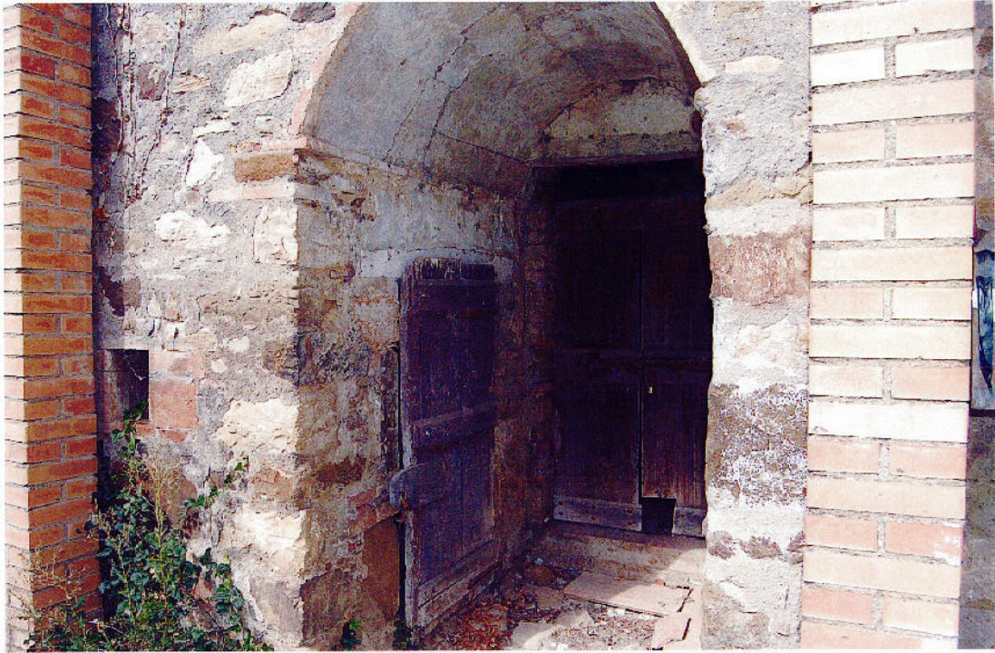
Foto n. 3 Part. 42 sub. 1 - fondo e ripostiglio al PT
