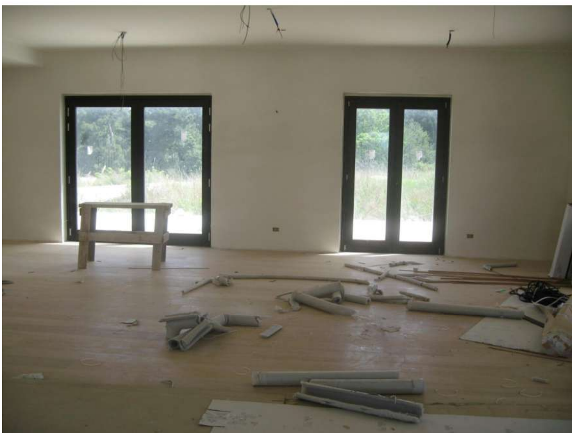
Foto n.25: immobile C. Area hall, living, salotto, bar , esposta a sud, dotata di porticato antistante il lato Sud-Ovest ed area a terrazzo sul lato Sud-Est.
