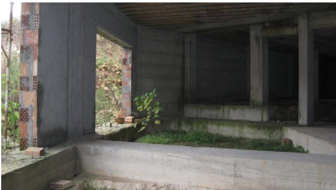
Foto n.47: vista dell'immobile D al livello più basso. Sono visibili le aree ove trovano collocazione le piscine basse del centro benessere.
