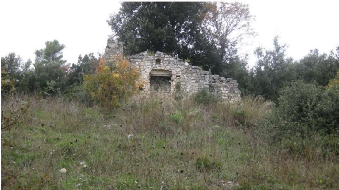
Foto n.59: terzo fabbricato rurale all'interno dell'immobile E. Il fabbricato non è accatastato, neanche sotto la dicitura di fabbricato diruito; risulta ad ogni modo ubicato nell'area centrale della particella n.905 del foglio n.25.
