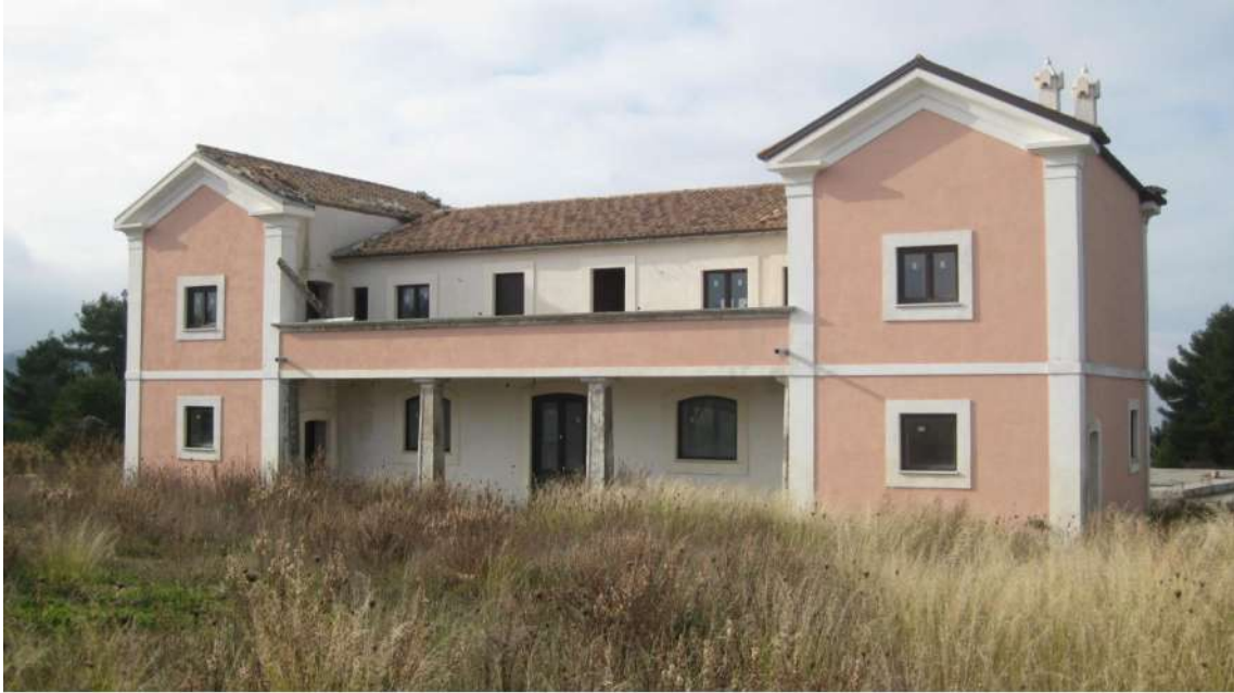
Foto n.13: immobile A, prospetto lato Sud-Est. Le facciate Sud-Est e Nord-Est sono al finito, mentre quelle a Nord-Ovest e a Sud-Ovest sono attualmente al rustico.
