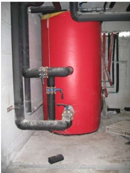
Foto n.33: vano tecnico immobile C.
