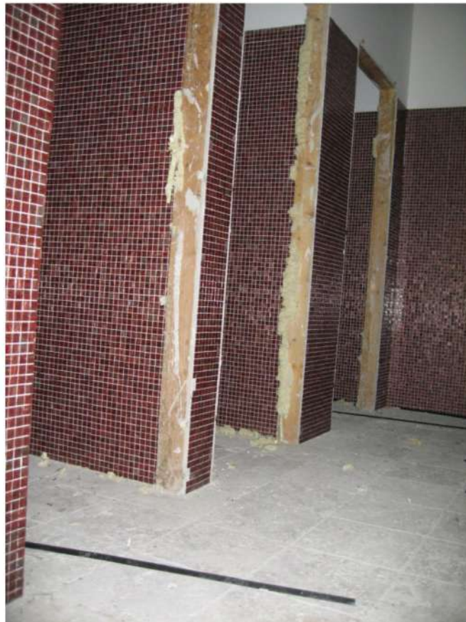
Foto n.30: immobile C, bagni asserviti all'area ristorante.
