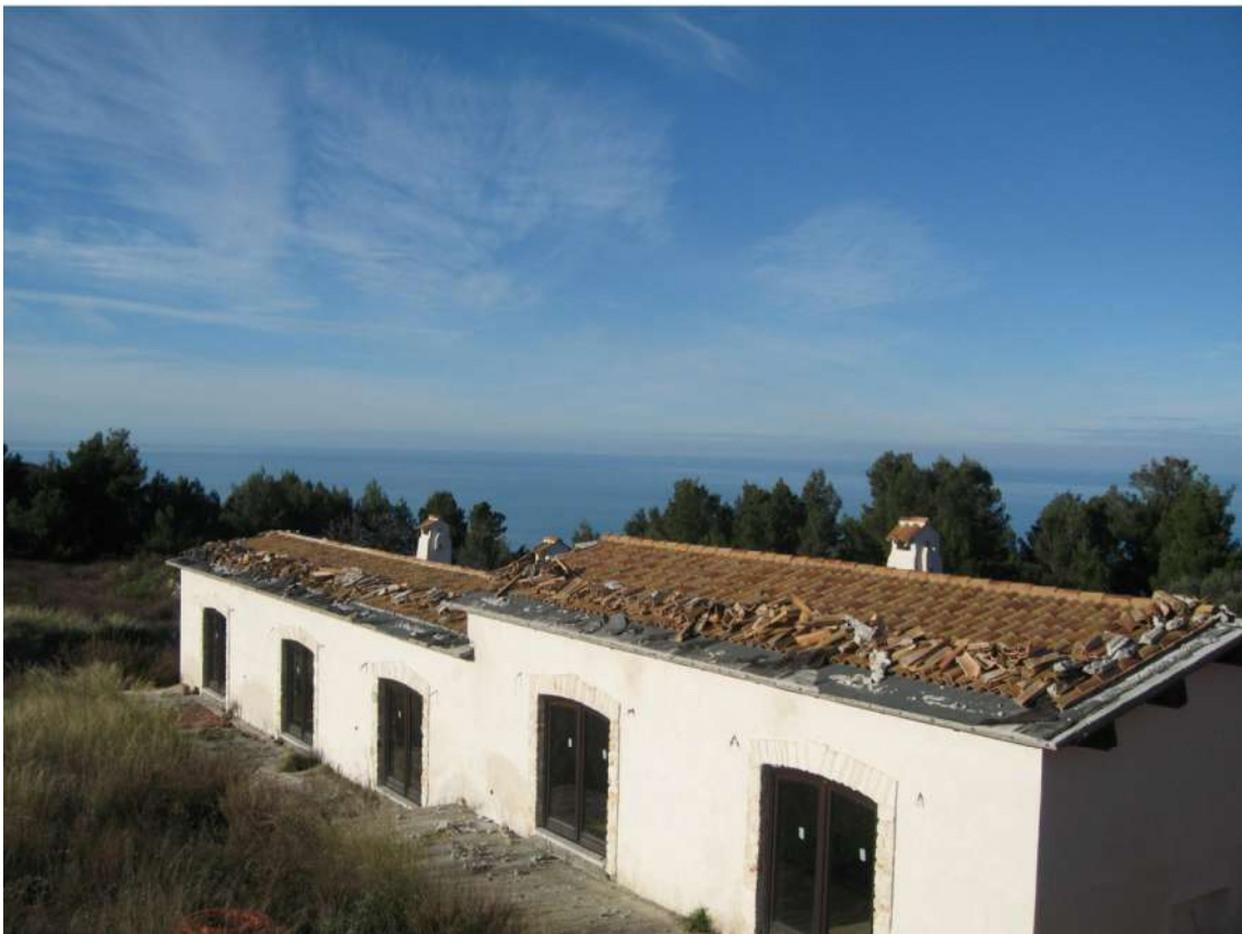
Foto n.18: vista d'insieme dell'immobile B. La foto scattata da una delle camere dell'immobile C, permette di cogliere la grande panoramicità di cui gode l'area, con la vista della macchia mediterranea, di aree a bosco e del mare sullo sfondo. Anche la copertura dell'immobile B è stata oggetto di furto delle scossaline e delle gronde in rame.
