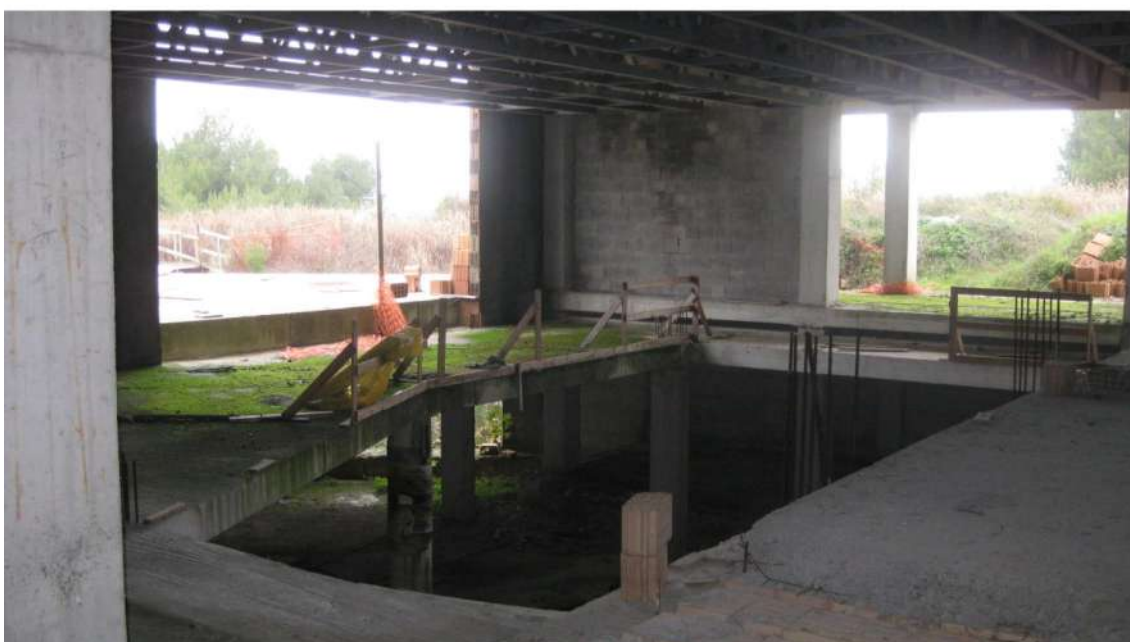
Foto n.43: vista interna dell'immobile D al livello superiore
