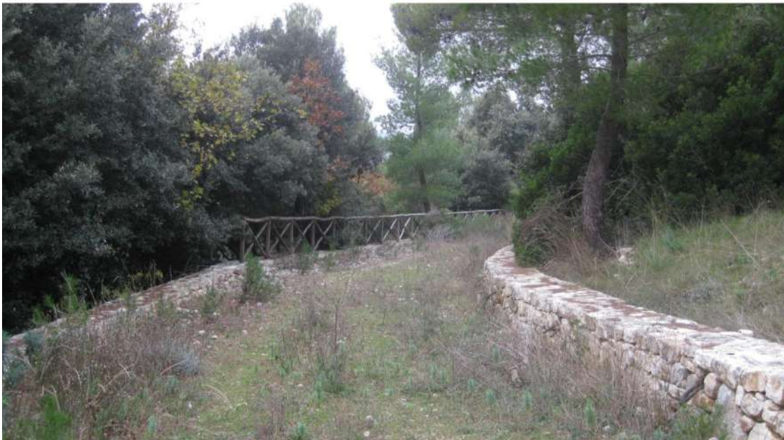
Foto n.53: sentiero, dotato di muretto a secco e staccionata in legno, ricadente all'interno dell'immobile E del lotto 1. Il sentiero conduce dall'ingresso secondario (Foto n.52) sino all'area centrale del lotto. I muretti a secco sono dotati di canaline per l'installazione dell'impianto elettrico d'illuminazione.
