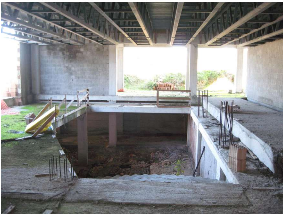
Foto n.45: vista del livello interno più alto dell'Immobile D, centro benessere, area a doppia altezza.
