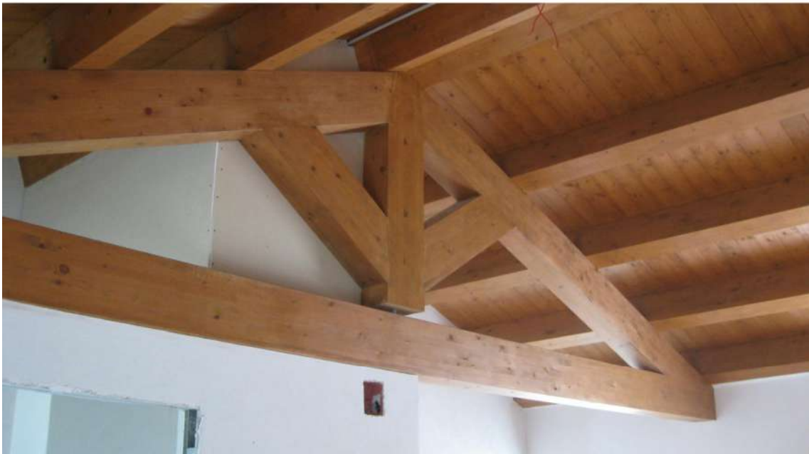
Foto n.16: copertura al piano primo delle suite, immobile A. La capriata in legno lamellare, lasciata a vista negli spazi interni, conferisce particolare fascino agli ambienti.
