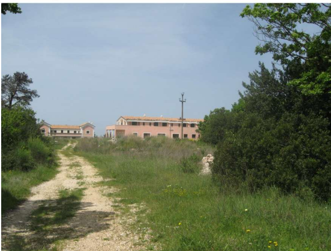
Foto n.4: ingresso al lotto e vista area centrale, immobili A (a sinistra nella foto) e C (a destra)
