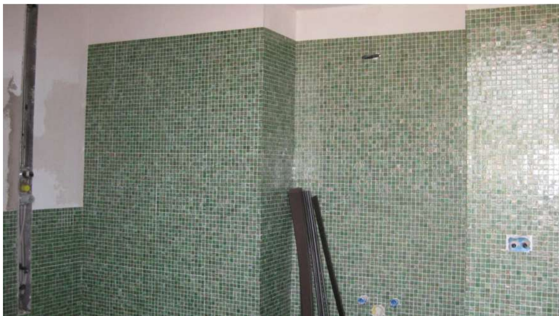
Foto n.21: bagno immobile B. Rivestimento in tasselli di mosaico pregiato. Sono utilizzate differenti colorazioni nei diversi bagni asserviti alle singole suite.
