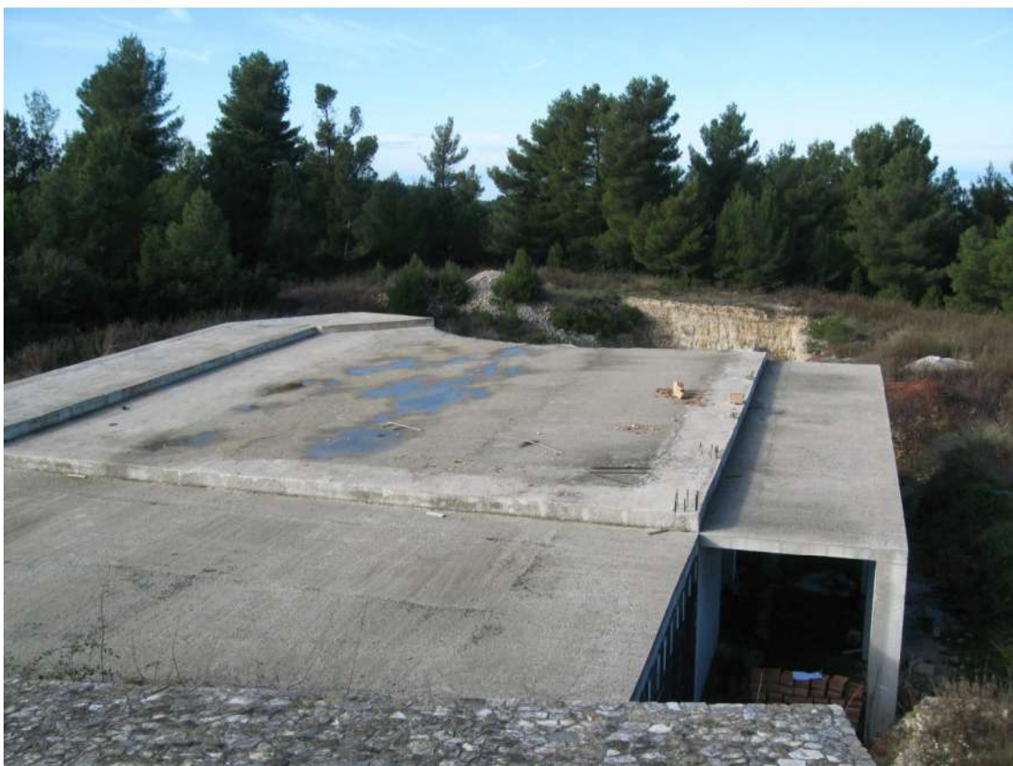
Foto n.39: immobile D al rustico. Vista della copertura e del panorama circostante il centro benessere.
