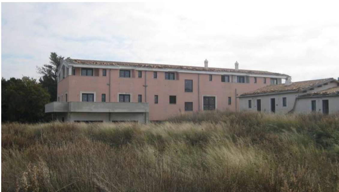
Foto n.24: immobile C, prospetto lato Nord-Ovest.
