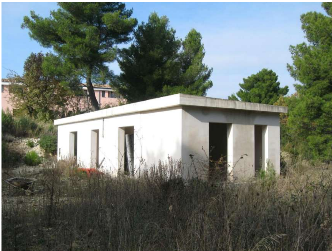
Foto n.50: edificio adibito a vano tecnico del complesso alberghiero, ubicato all'interno della particella n.475 al foglio n.25.
