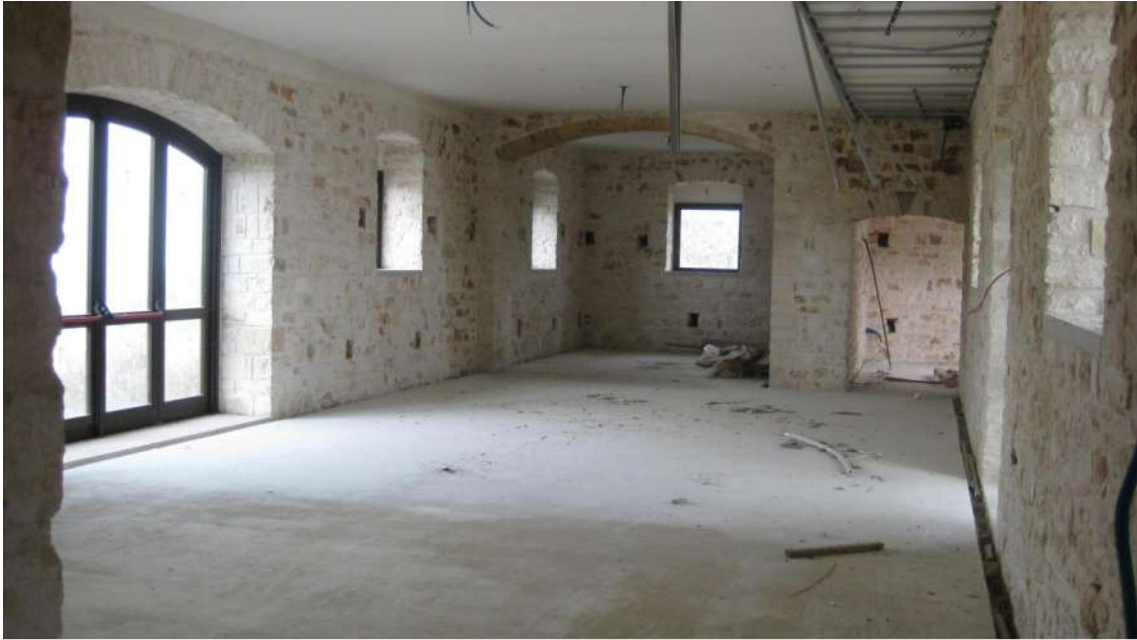
Foto n.15: interno al piano terra, immobile A. Si nota la lavorazione delle pareti interne, con pietra irregolare della muratura portante, lavorata, rifinita e lasciata a vista. La pavimentazione interna è al rustico, sono presenti tutte le predisposizioni impiantistiche e le apposite canaline dell'impianto elettrico. Causa furti, reiterati nel tempo, i fili elettrici in rame sono da ricollocare.
