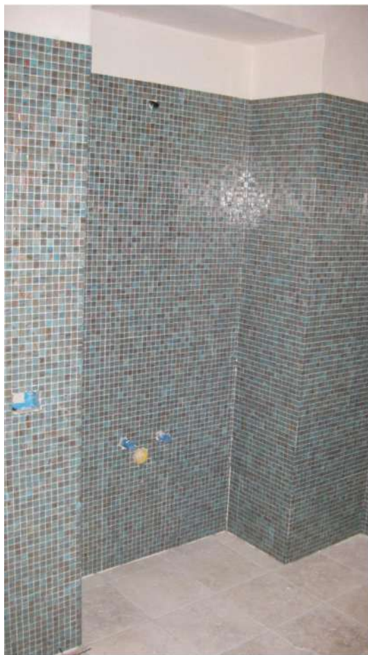
Foto n.19: bagno immobile B
