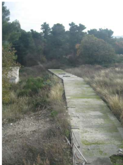
Foto n.34: tunnel di collegamento all'imm. C.
