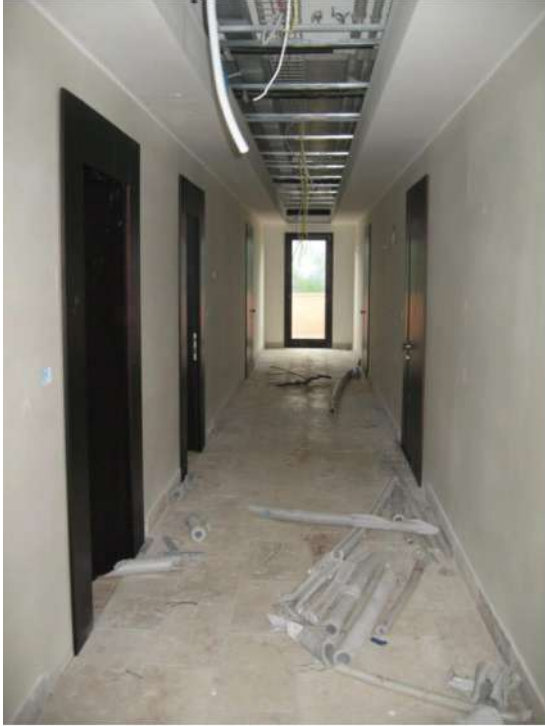
Foto n.28: immobile C, corridoio camere al piano terra.
