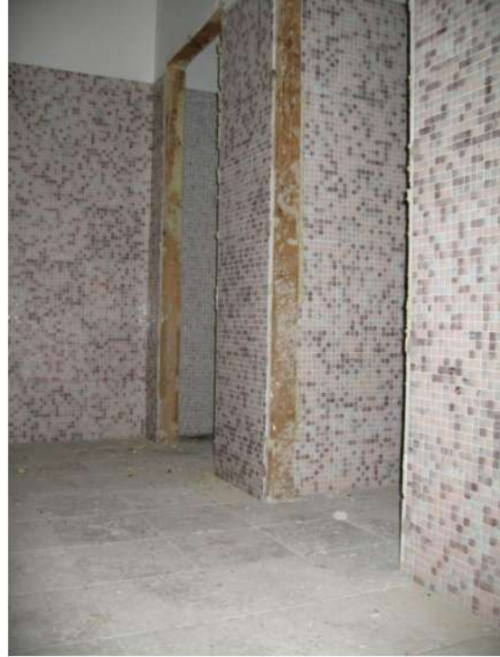
Foto n.29: immobile C, bagni asserviti all'area ristorante.
