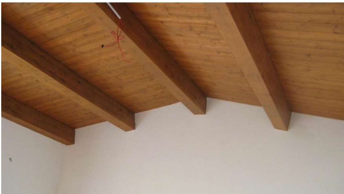
Foto n.23: copertura in legno lamellare, immobile B. Tutte le suite dell'immobile B sono dotate di copertura in legno a vista. Tre delle cinque suite sono dotate di canna fumaria e predisposizione camino.
