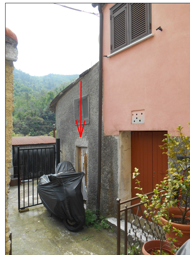
Accesso del ripostiglio esterno
