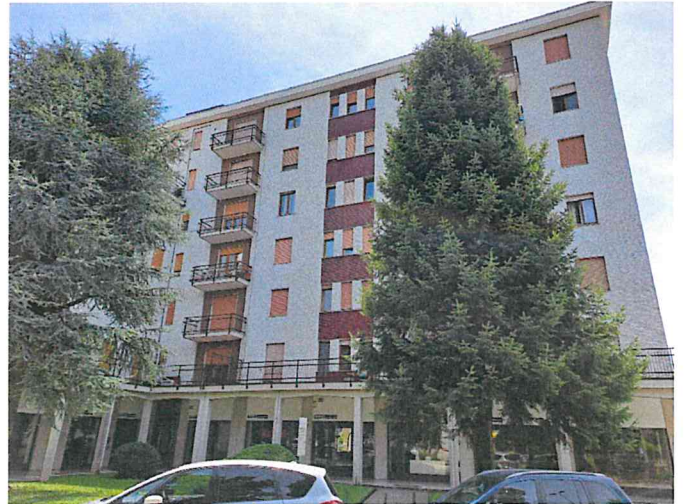
Foto 02 - Vista d'insieme fabbricato - prospetto N
