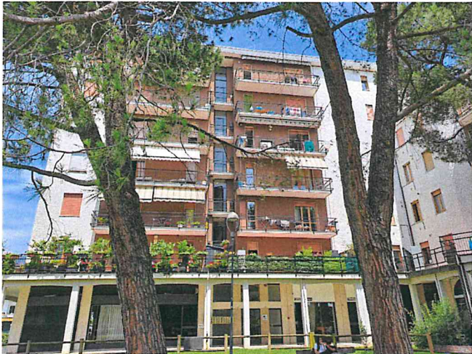
Foto 01 - Vista d'insieme fabbricato - prospetto S
