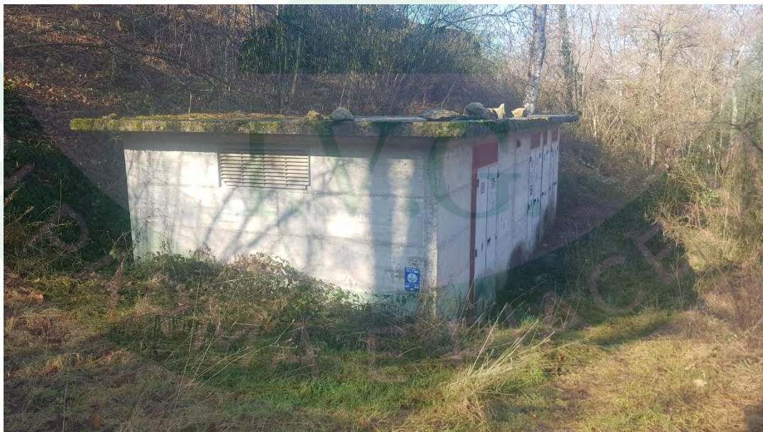
Figura 7 – Edificio di centrale
