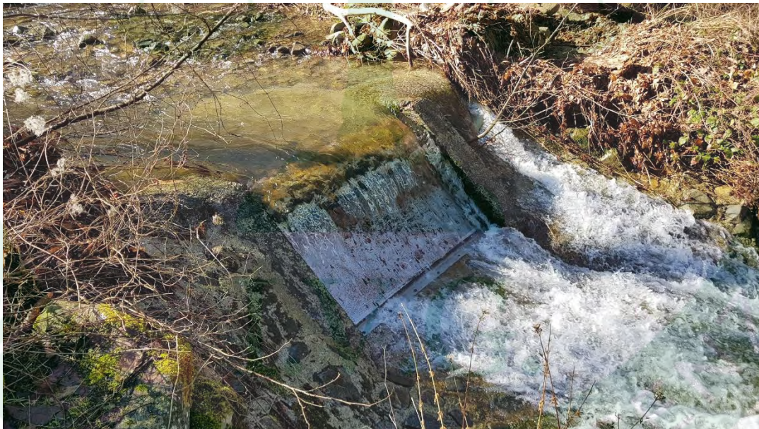
Figura 5 – Opera di presa con griglia a coanda
