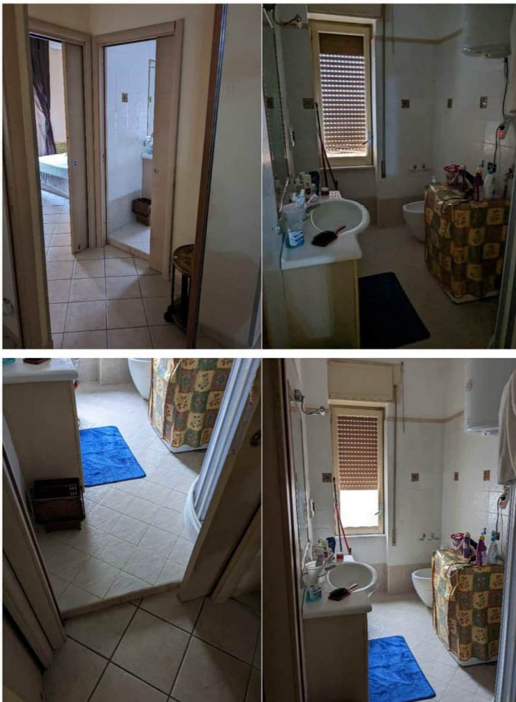
Wc con affaccio finestrato sul prospetto laterale, impiantistica di scarico a pavimento e lavabo con poggio armadio sottostante.
