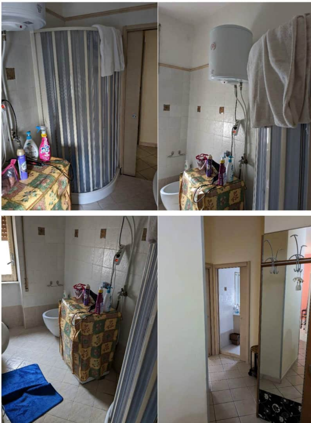
Ulteriori dettagli del wc con cabina doccia e scaldabagno elettrico. L'impiantistica di alimentazione di bagno e cucina è piuttosto tradizionale.
