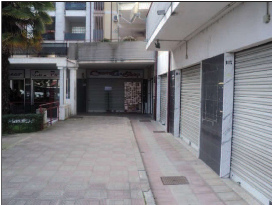
Foto N.1: Ingresso magazzino sub. 6 lato via Benedetto Croce.
