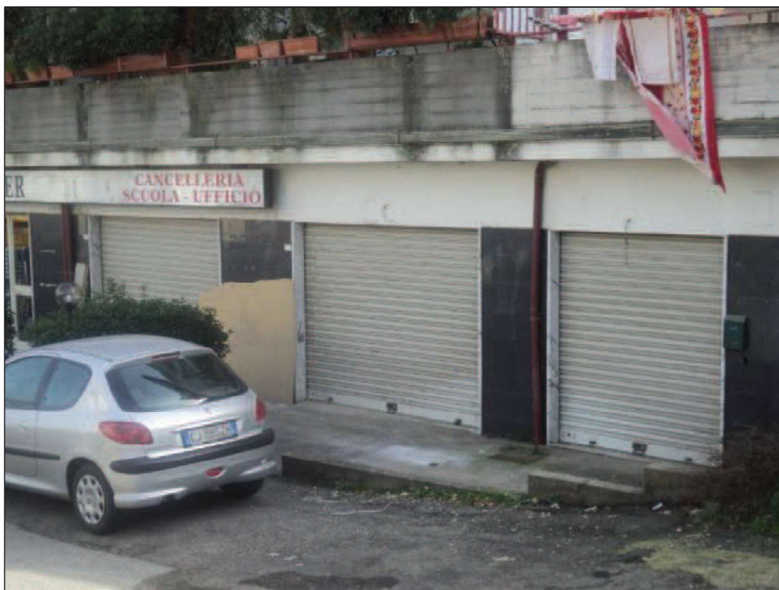
Foto N.2: Ingresso magazzino sub. 54 lato via Ungaretti.
