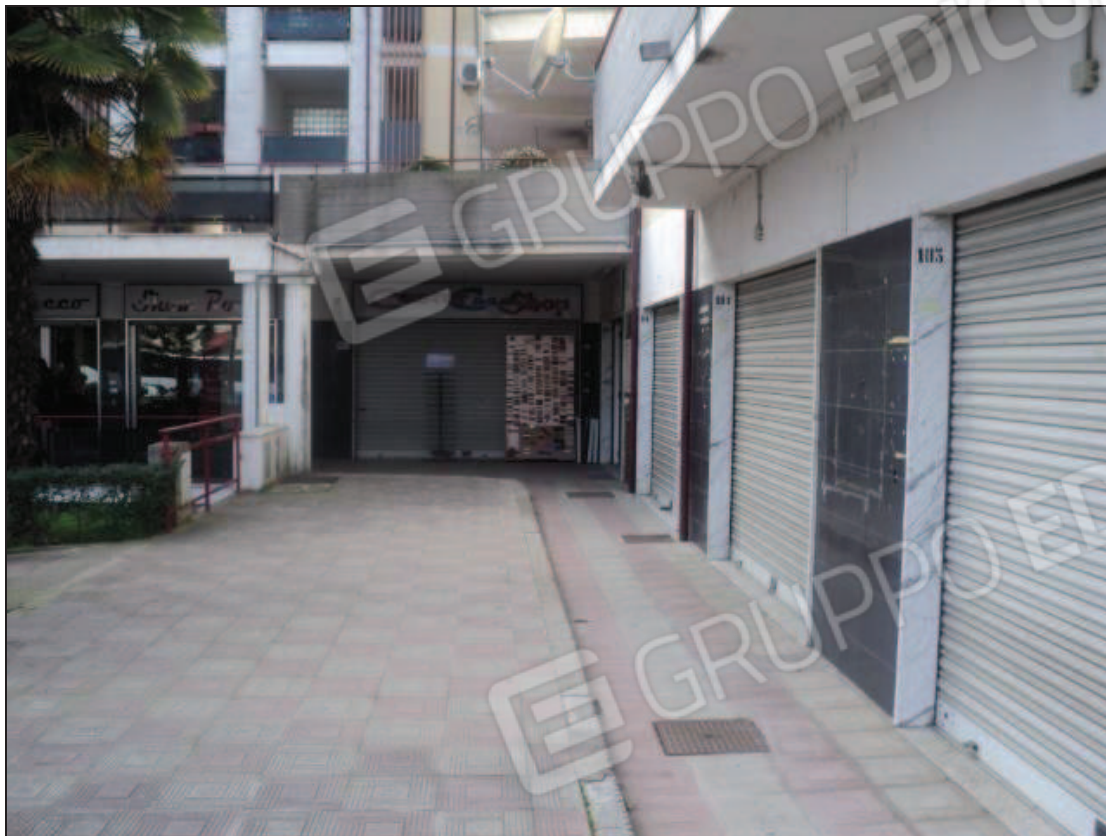
Foto N.1: Ingresso magazzino sub. 6 lato via Benedetto Croce.
