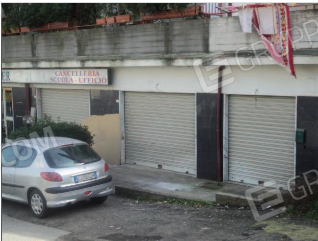
Foto N.2: Ingresso magazzino sub. 54 lato via Ungaretti.
