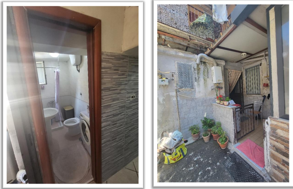
Fig. 11-12. WC – Cortile interno.
