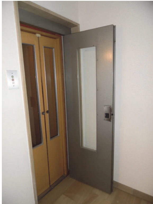
FOTO 3 – Vista vano ascensore
