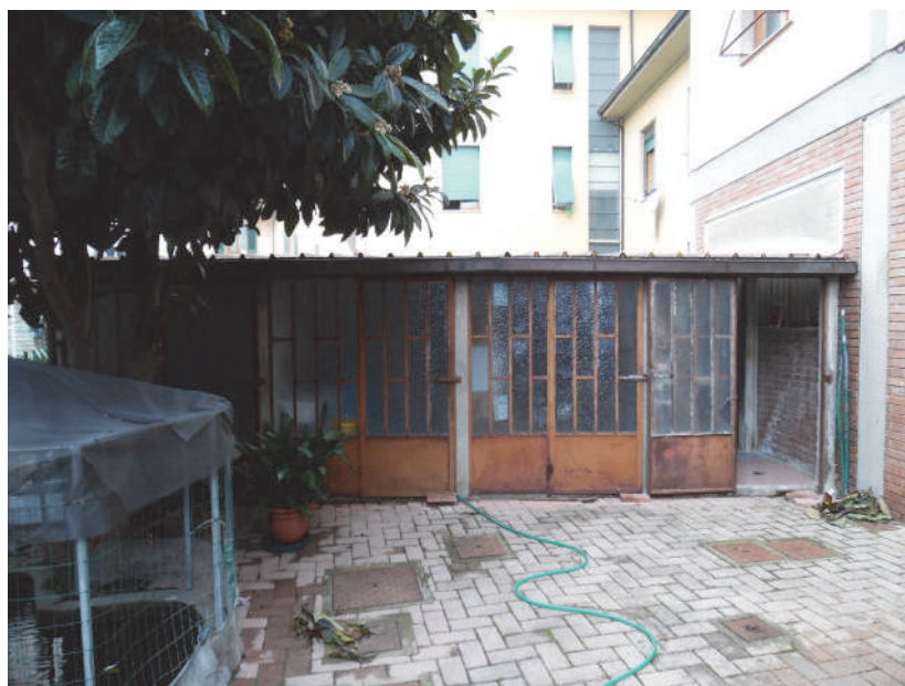
FOTO 20 – Vista ripostiglio piano terra
