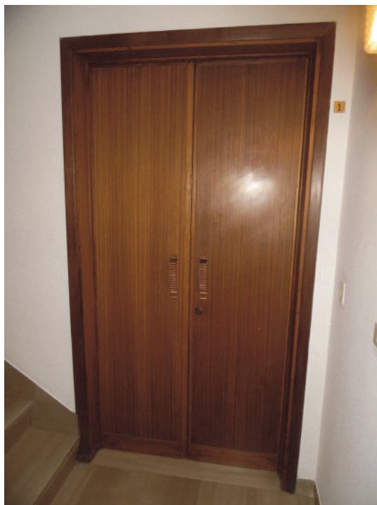
FOTO 5 – Vista porta d'ingresso
