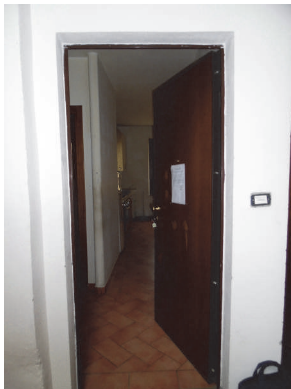
FOTO 6 – Vista porta d'ingresso
