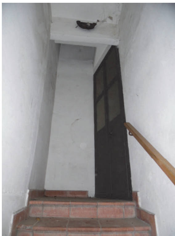
FOTO 5 – Vista vano scale con porta d'ingresso
