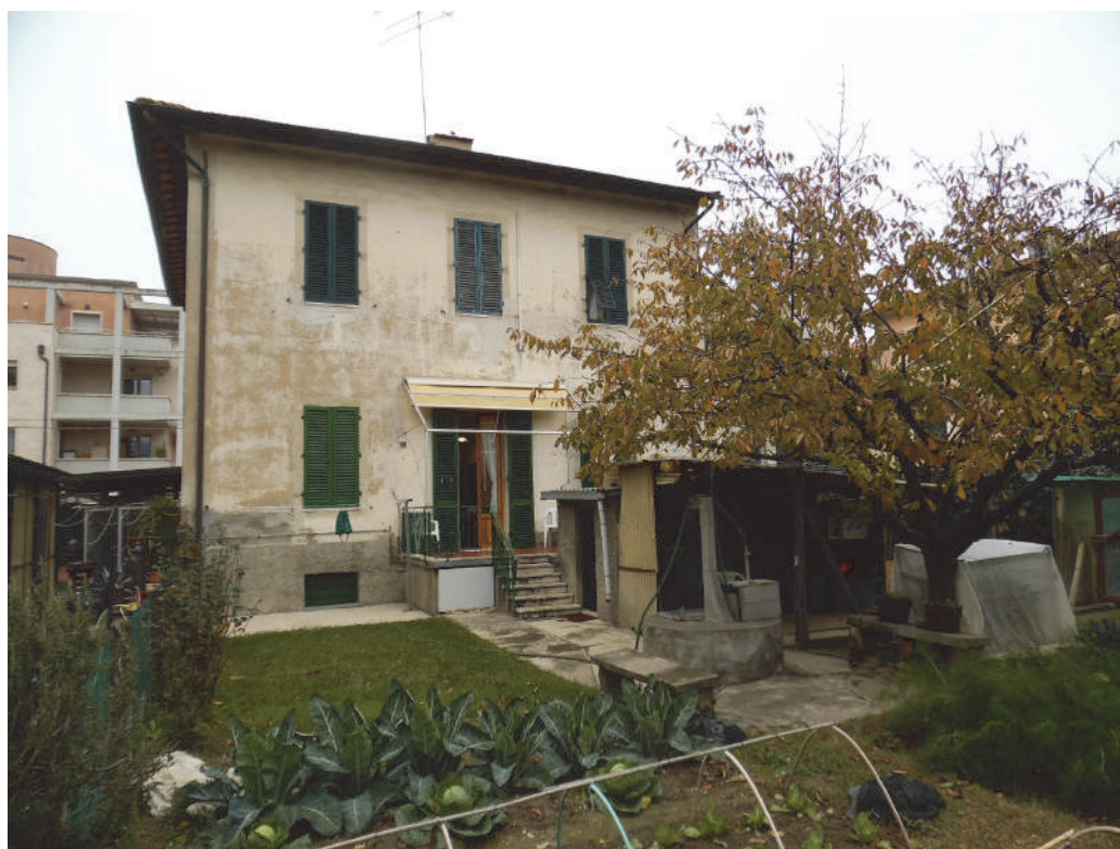
FOTO 4 – Vista esterna resede
