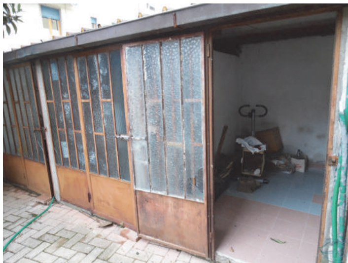
FOTO 21 – Vista ripostiglio piano terra
