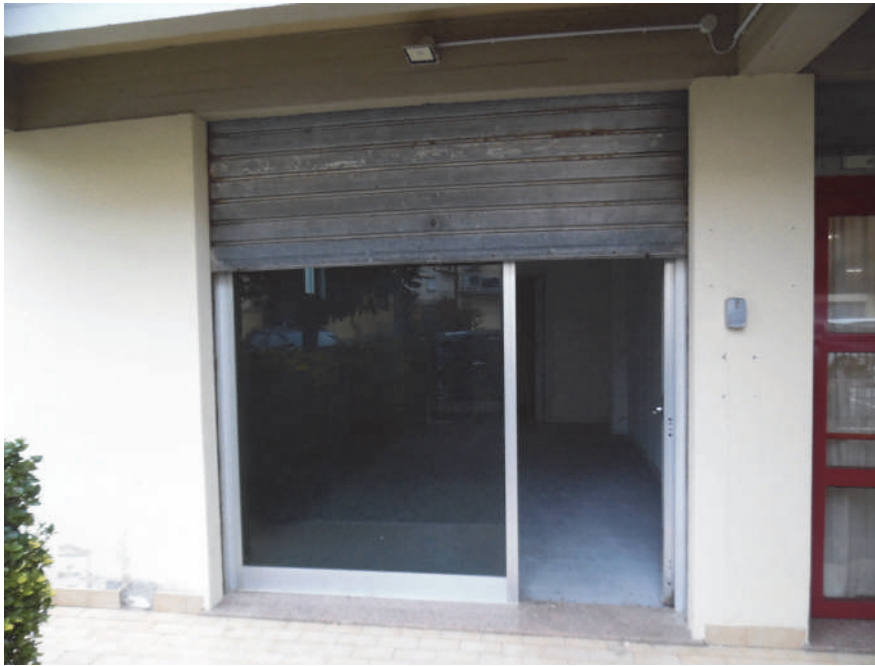
FOTO 3 – Vista porta d'ingresso
