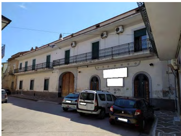
Il fabbricato di cui è parte l'unità immobiliare
