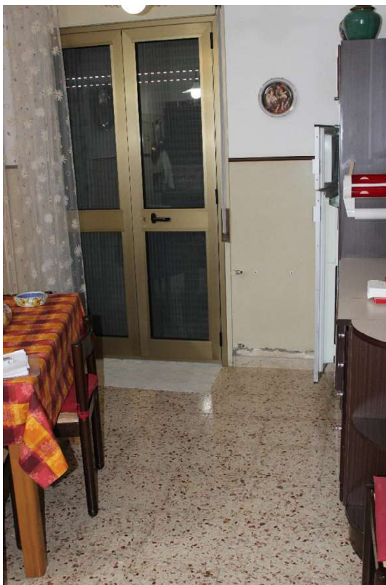
Foto 37: Piano seminterrato rispetto Via Idria. locale cucina-forno
