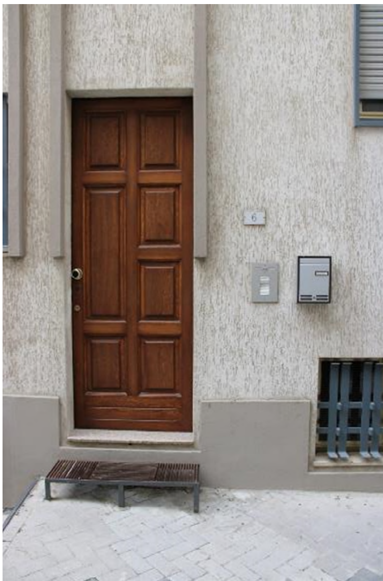
Foto 7: Cerami (EN) Via Idria – lato EST Ingresso mini condominio
