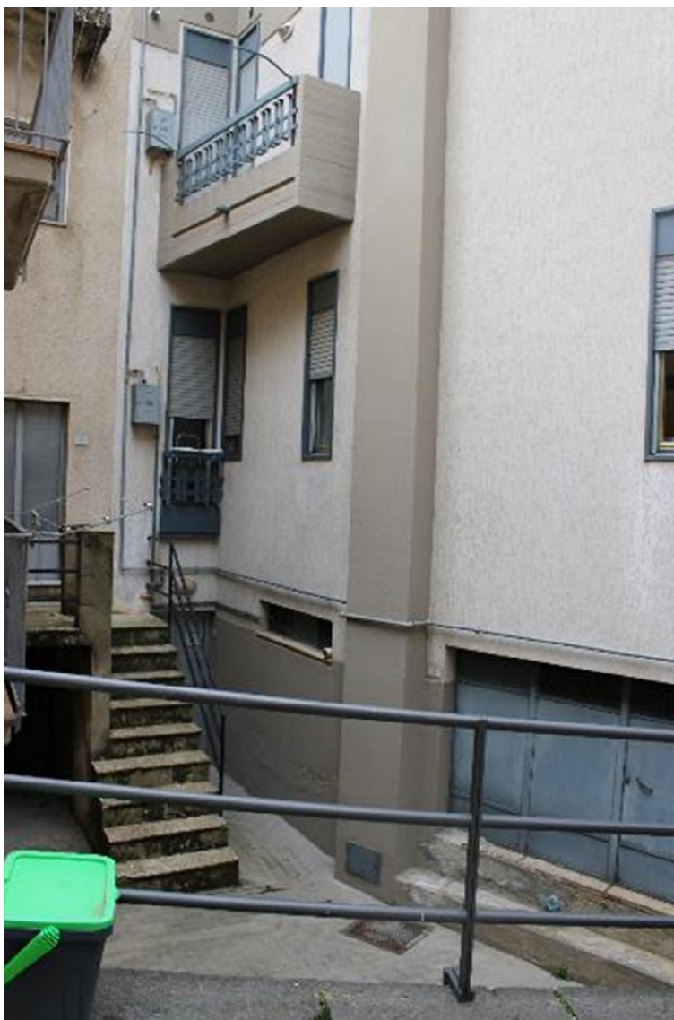
Foto 3: Cerami (EN) Via Idria Cerami (EN) - cortiletto sotto strada
