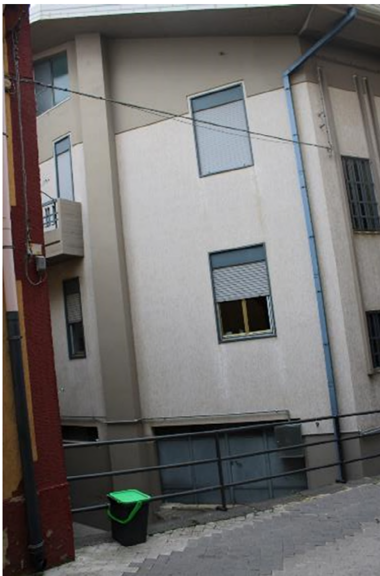
Foto 4: Cerami (EN) Via Idria - cortiletto sotto strada
