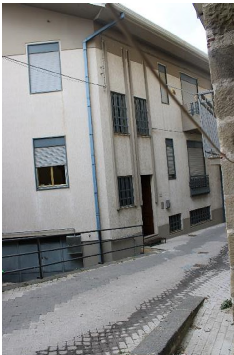
Foto 6: Cerami (EN) Via Idria – fabbricato lato EST
