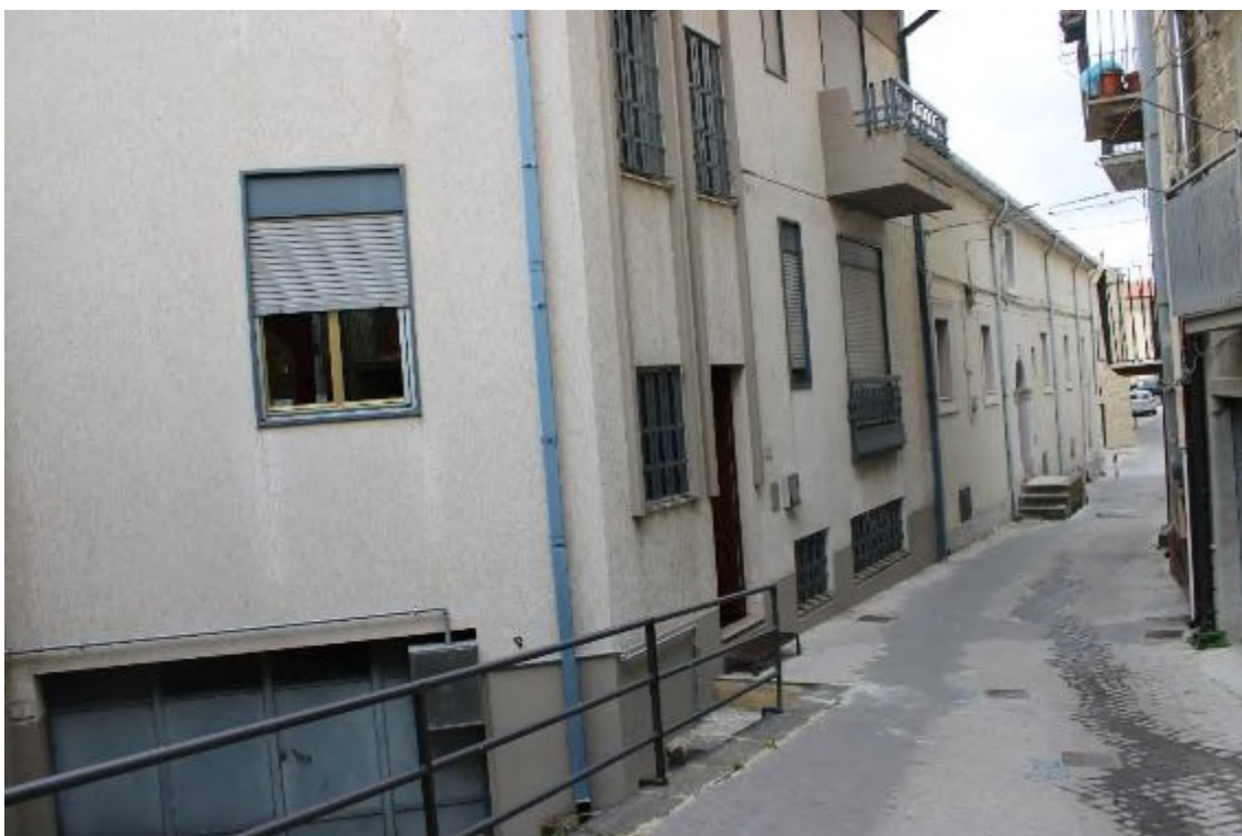
Foto 2: Cerami (EN) Via Idria - fabbricato lato EST
