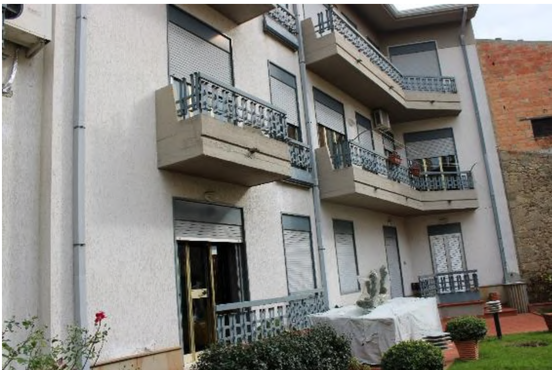
Foto 10: Cerami (EN) fabbricato Via Idria 6- prospetto fabbricato e Corte esclusiva lato Ovest visibile da Corso Cairoli
