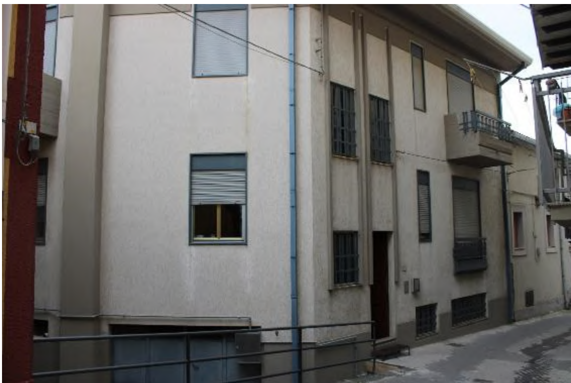
Foto 1: Cerami (EN) Via Idria fabbricato lato EST
