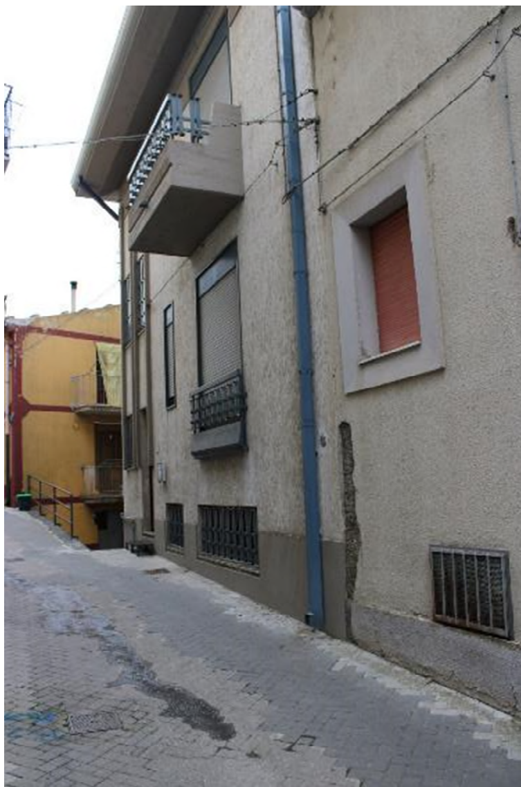
Foto 5: Cerami (EN) Via Idria – fabbricato lato EST
