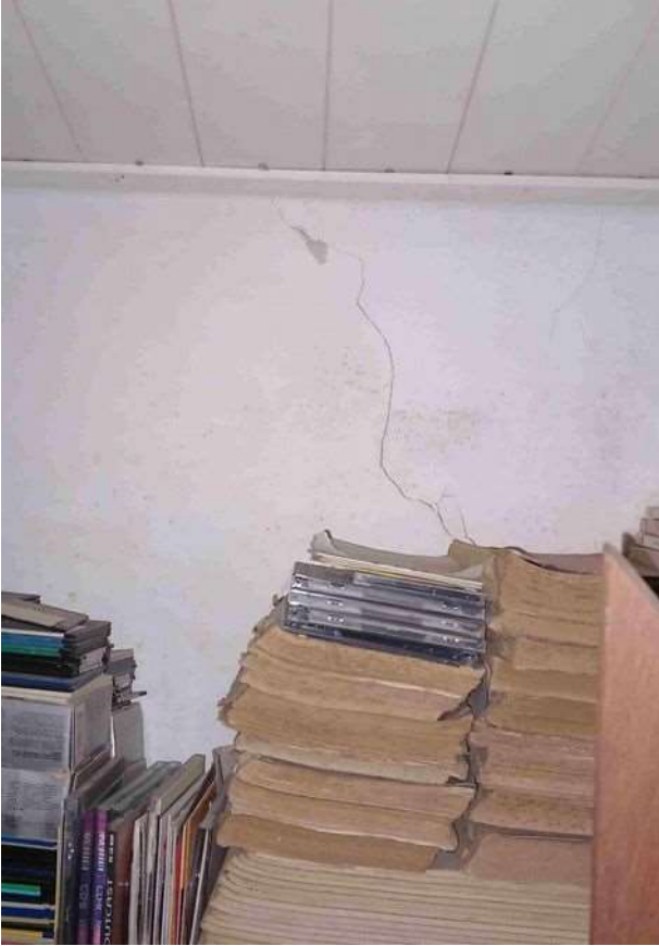
CREPE E AMMALORAMENTO PARTI STRUTTURALI E FINITURE
