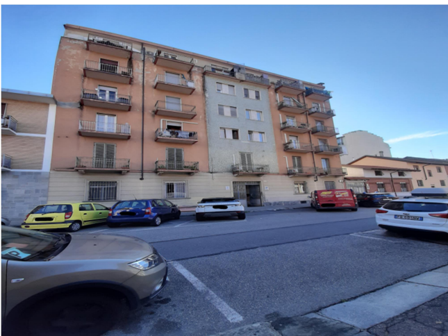
Prospetto su via Cavaglià
