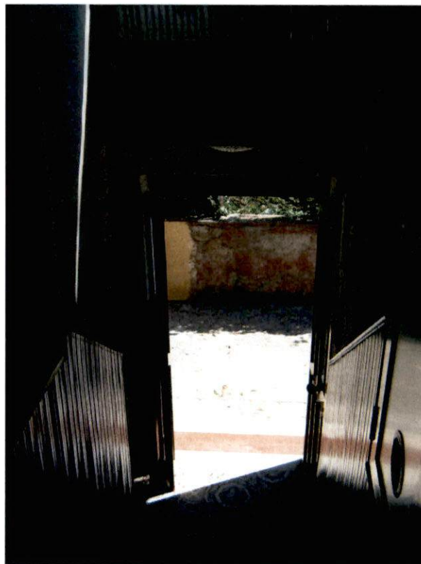
Fotografia n. 6 – Vista porzione rampa scale del maggior fabbricato –
