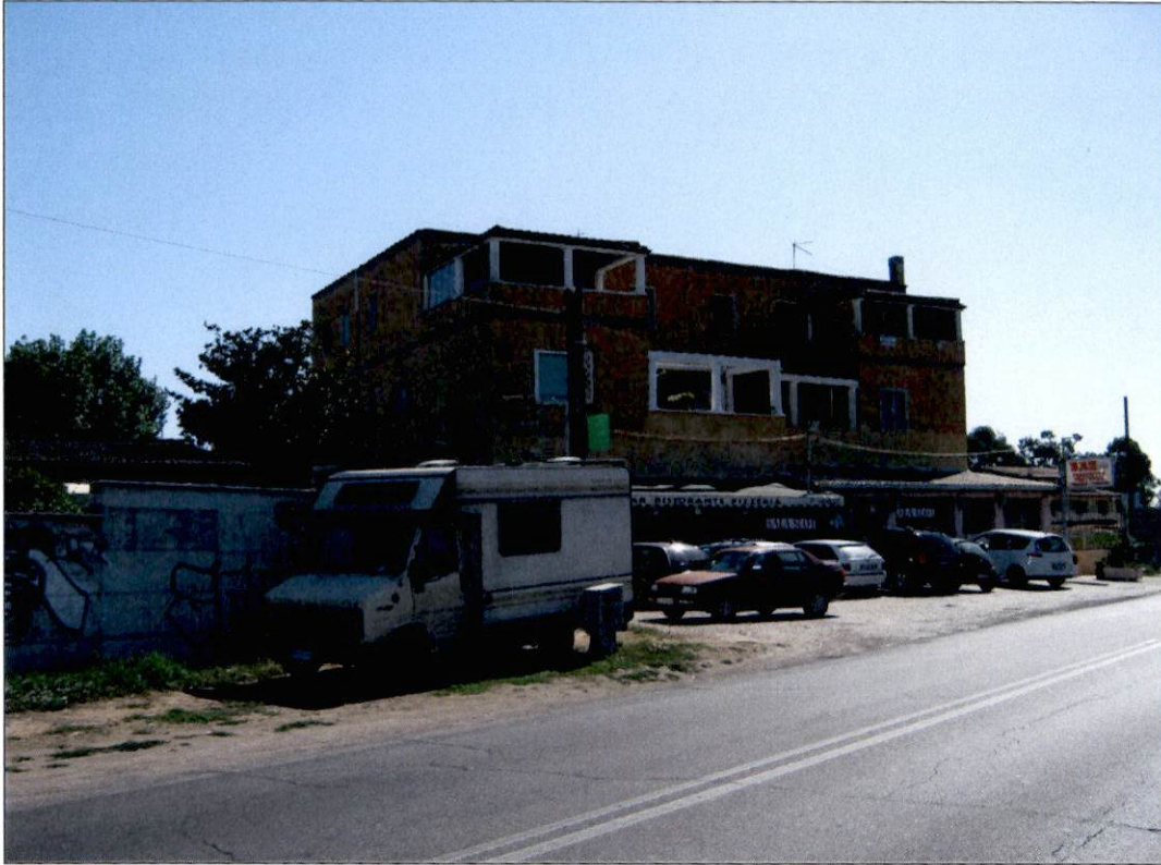
Fotografia n. 3 – Vista esterna del maggior fabbricato da Lungomare Tor san Lorenzo –
