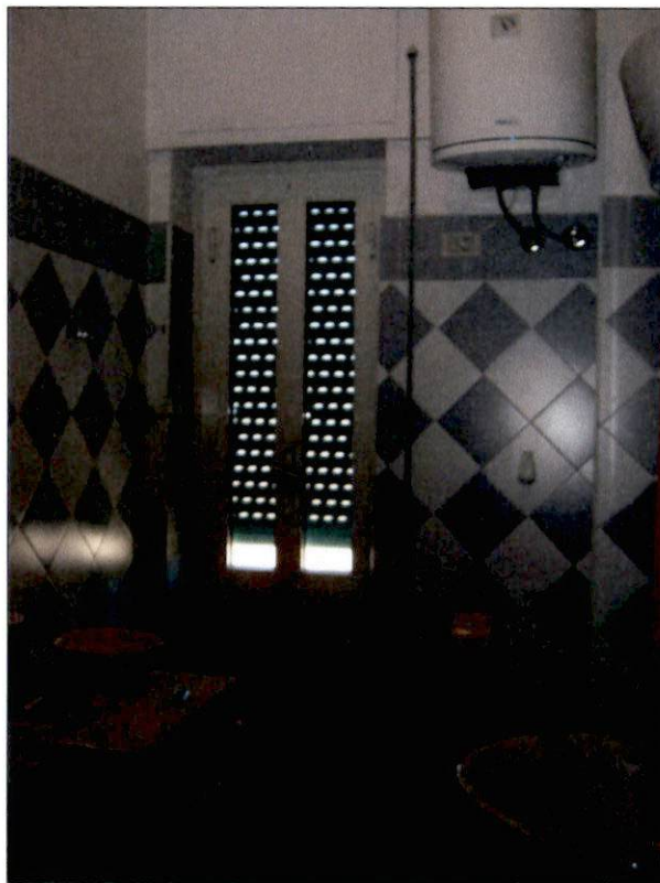
Fotografia n. 10 – Vista interna del w.c. bagno –
