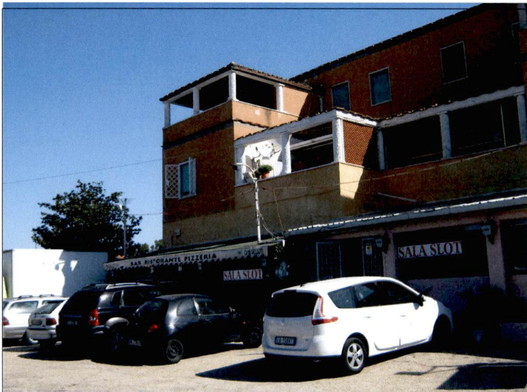
Fotografia n. 2 – Vista esterna del maggior fabbricato da Lungomare Tor san Lorenzo –
