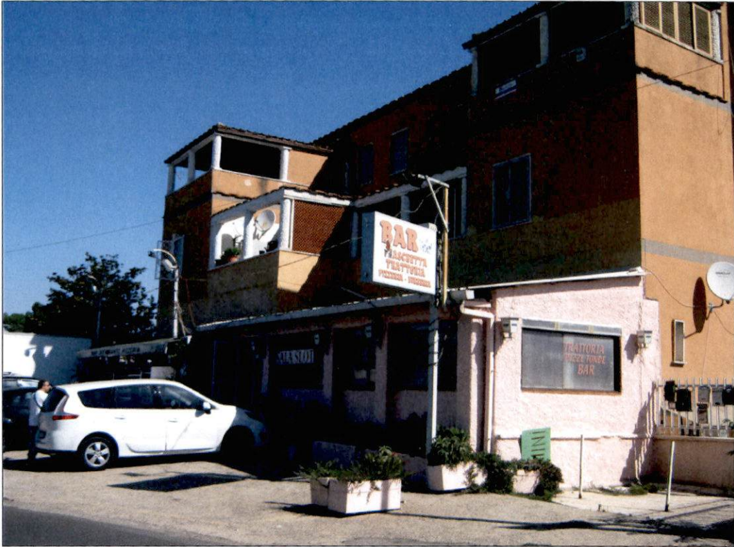
Fotografia n. 1 – Vista esterna del maggior fabbricato da Lungomare Tor san Lorenzo –
