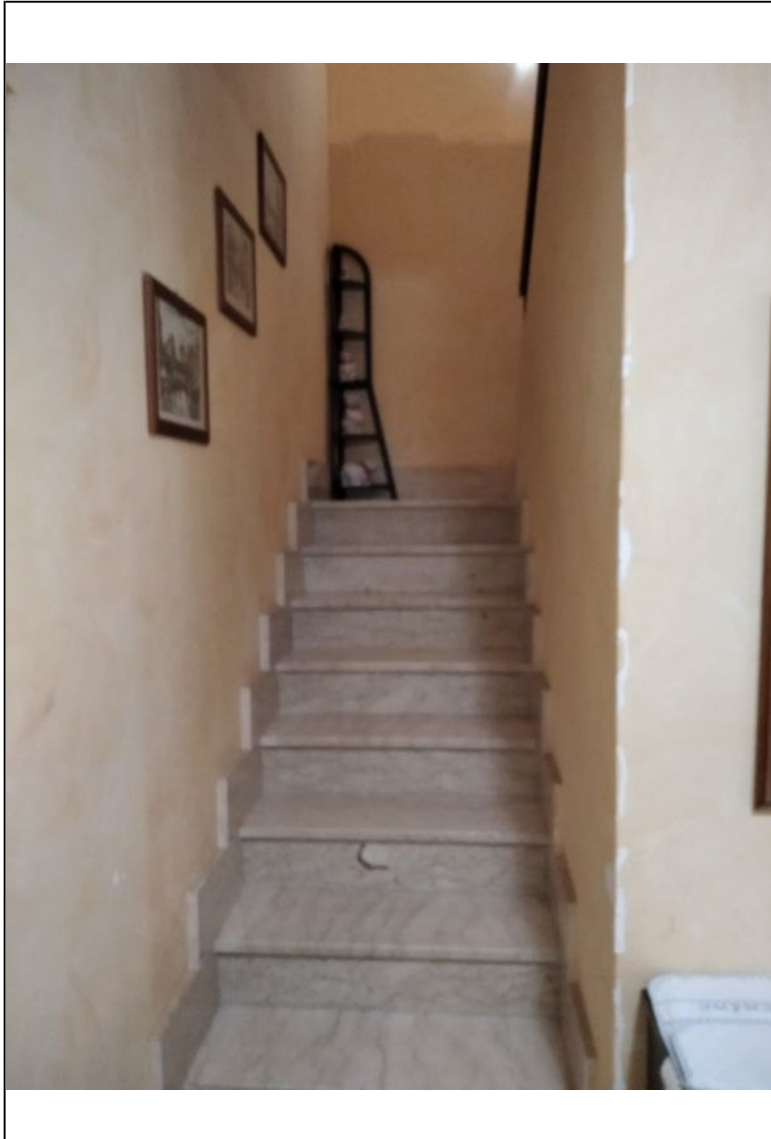
Foto n° 9. – Vano scala_Piano primo
