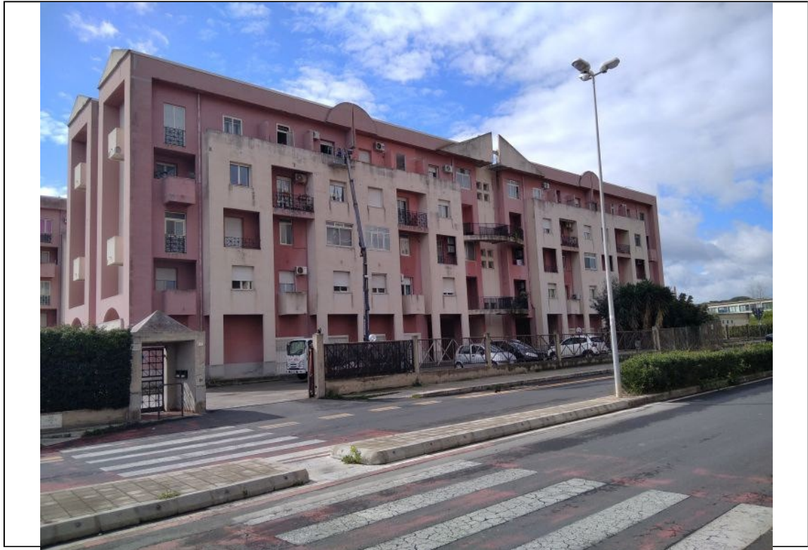
Foto n° 1. – Facciata Condominio (ex Cooperativa Edilizia “AMICIZIA”)
