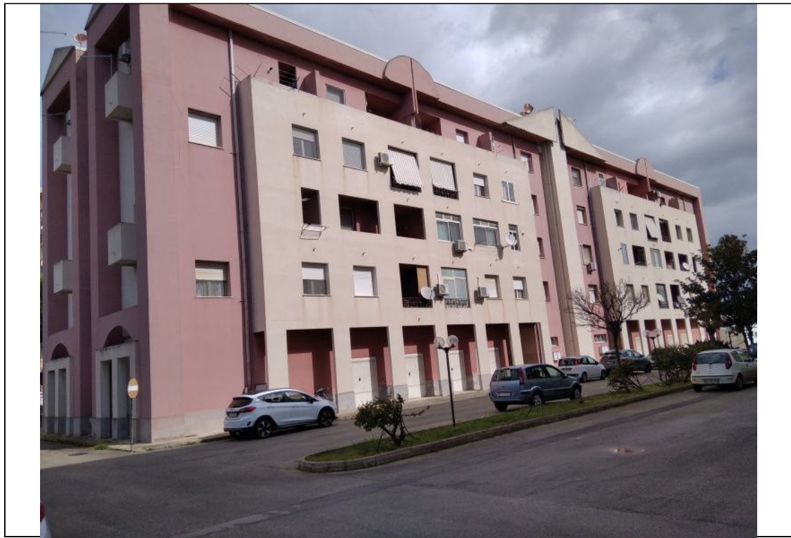
Foto n° 4. – Facciata - Scala A
