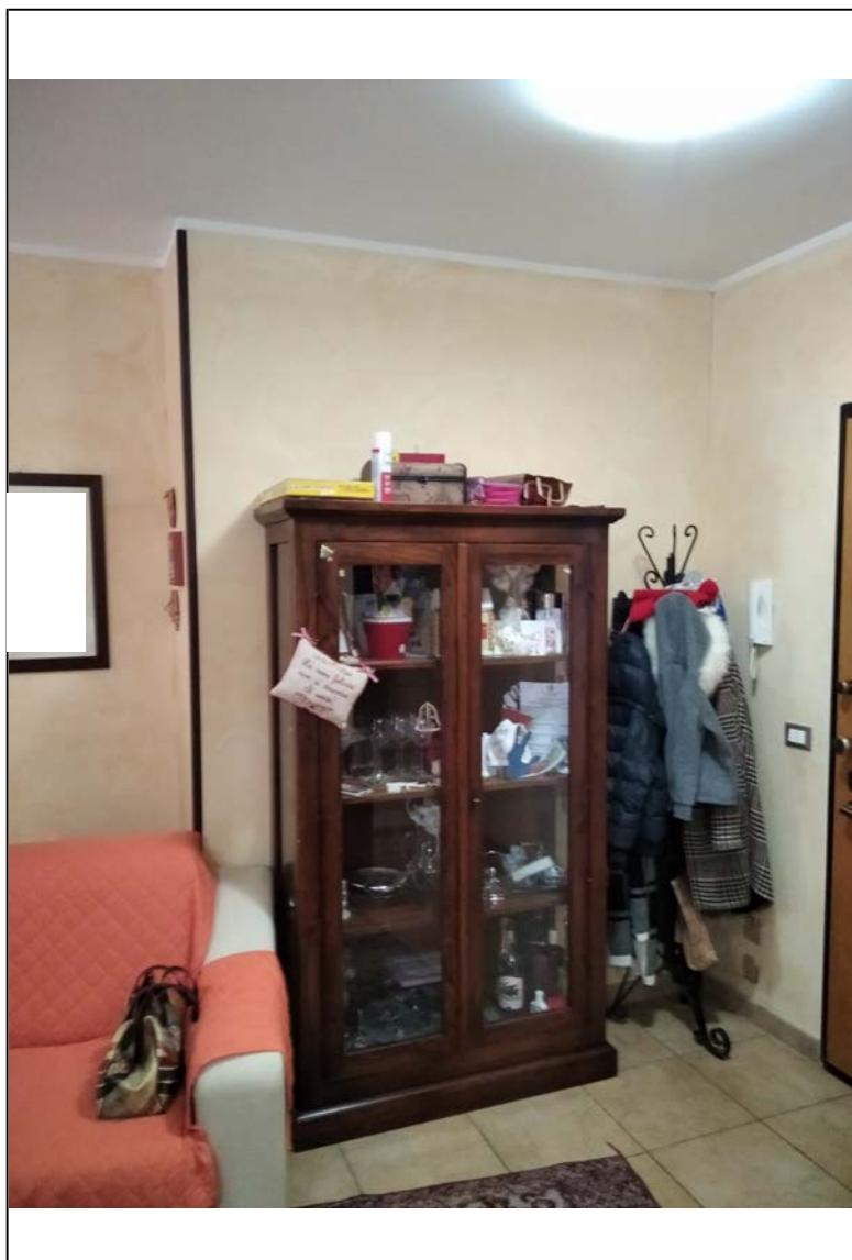
Foto n° 19. – Difformità – Ingresso 1° Appartamento _ Piano primo
