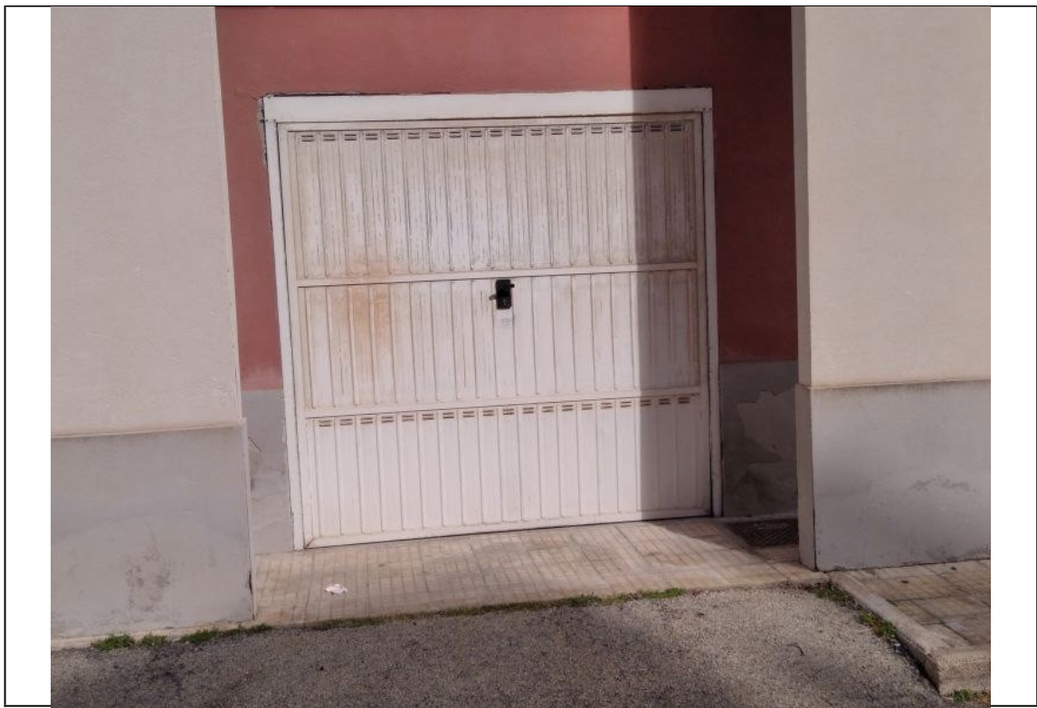
Foto n° 27. – Ingresso – Garage_Piano terra
