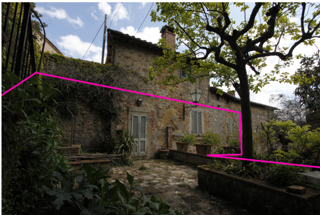
Vista dal cortile
