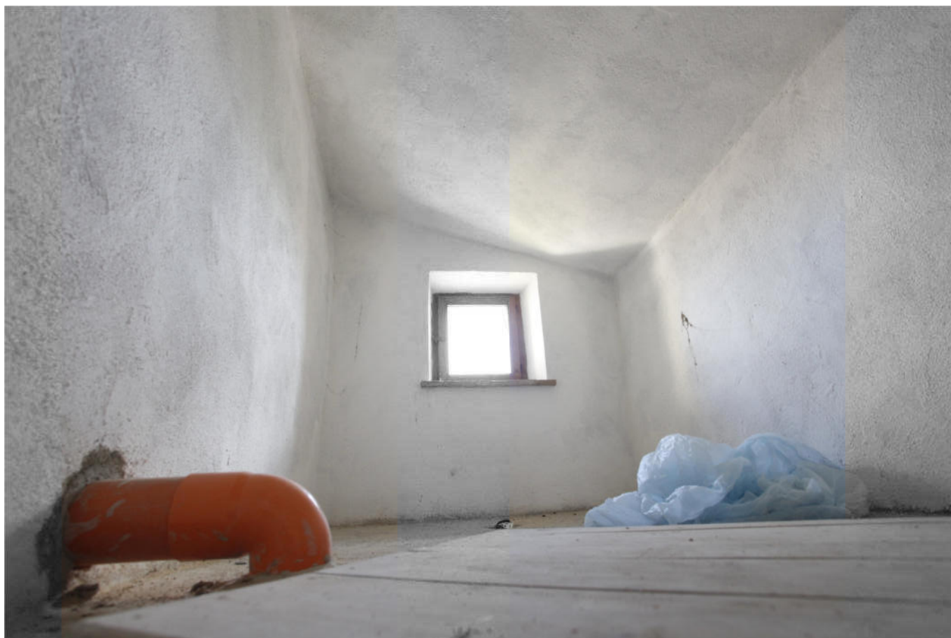
Scorcio del vano tecnico sopra il bagno
