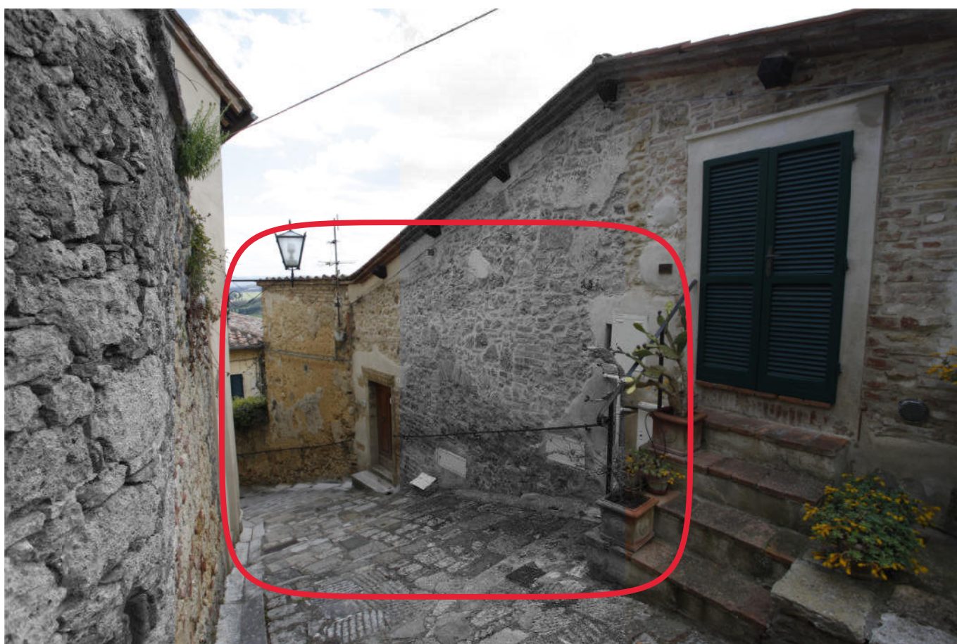
Vista da ovest di via della Fortezza
