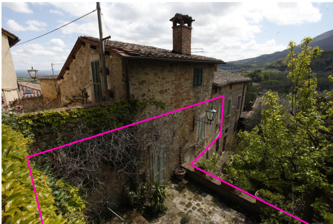
Vista da ovest di via della Fortezza
