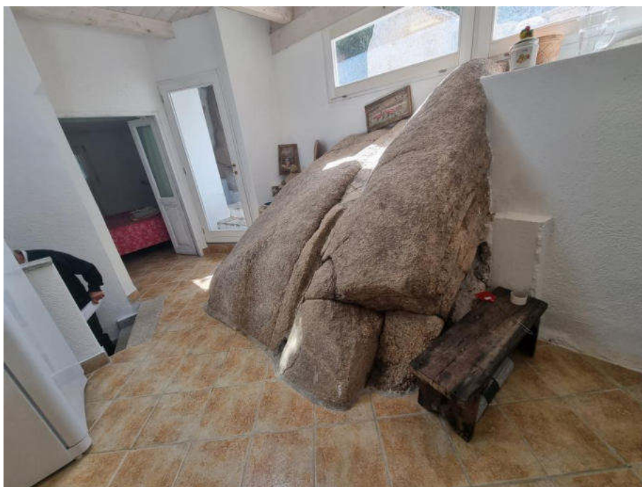
VISTA INTERNA CUCINA 2 DA DEMOLIRE
