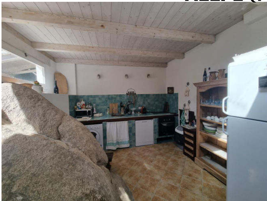
VISTA INTERNA CUCINA 2 DA DEMOLIRE
