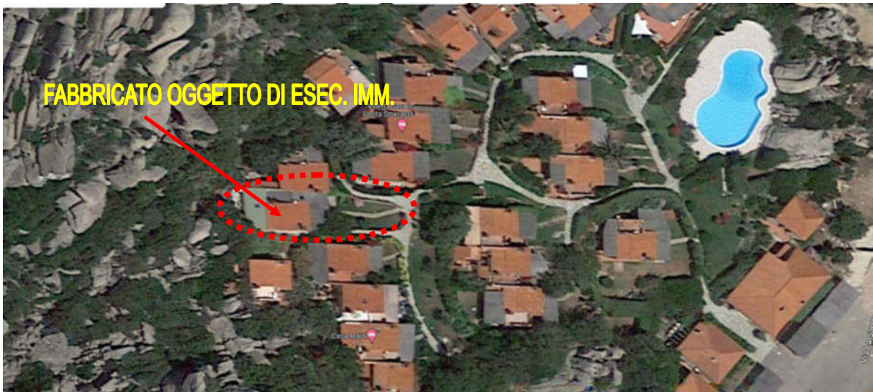
ORTOFOTO CON INDICAZIONE DEL FABBRICATO OGGETTO DI ESEC. IMM.
