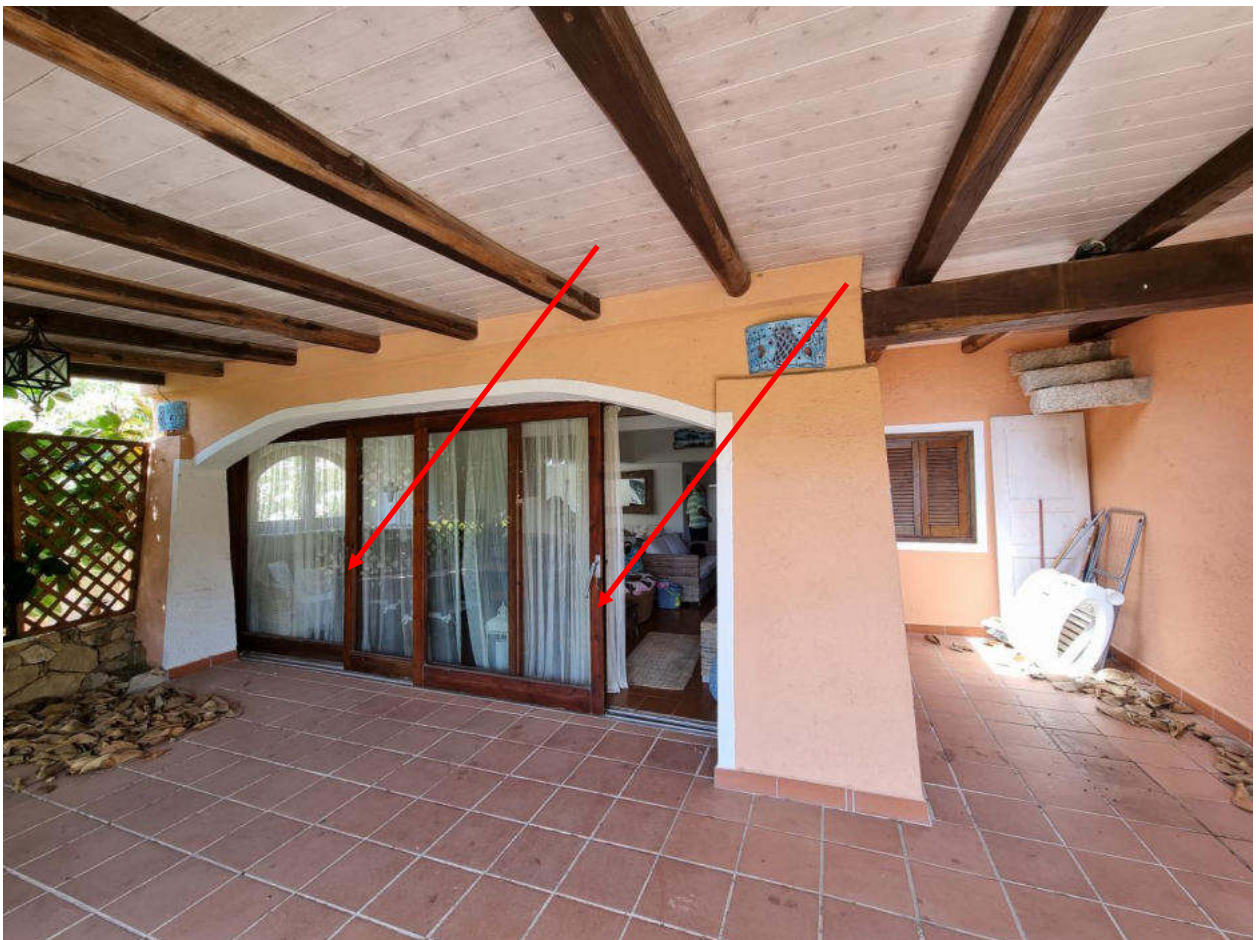
VISTA INGRESSO EX PORTICO CON SCORREVOLE DA DEMOLIRE PER L'ADEGUAMENTO URBANISTICO
