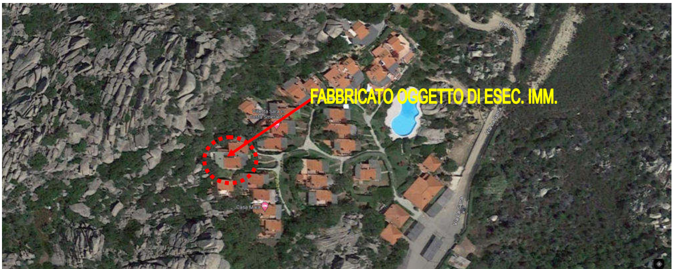
ORTOFOTO CON INDICAZIONE DEL FABBRICATO OGGETTO DI ESEC. IMM.
