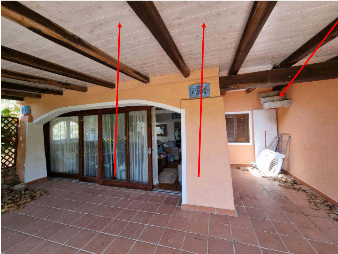
VISTA VERANDA COPERTA PARZIALMENTE DA MODIFICARE PER L'ADEGUAMENTO URBANISTICO E PARTE DELLA SCALA ESISTENTE CHE PORTA AL TERRAZZO
