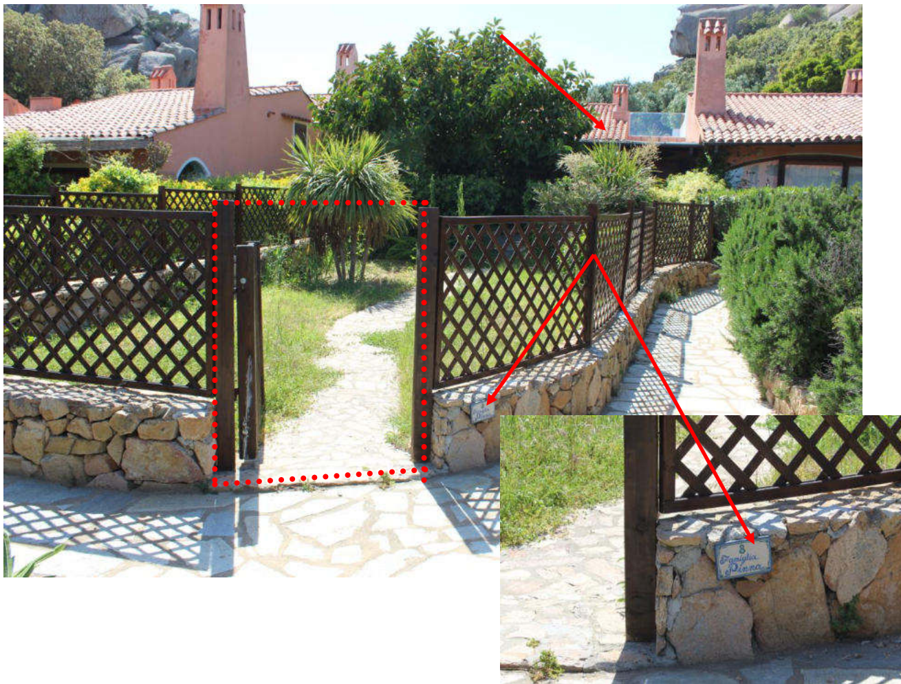
VISTA PANORAMICA ESTERNA DELL'INGRESSO AL LOTTO DAL MAPP.1571 DUB.30 DI PROPRIETA' CONDOMINIALE MA DELIMITATO ALL'INTERNO DEL BENE ESECUTATO
