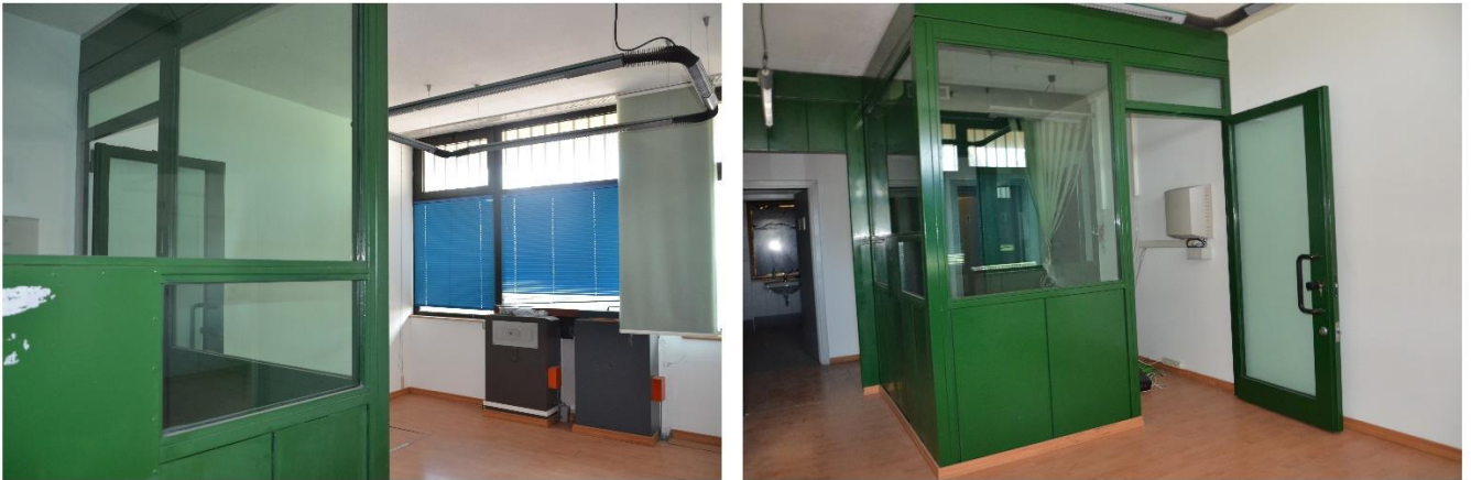
Vano con cablaggi e postazione informatica database
