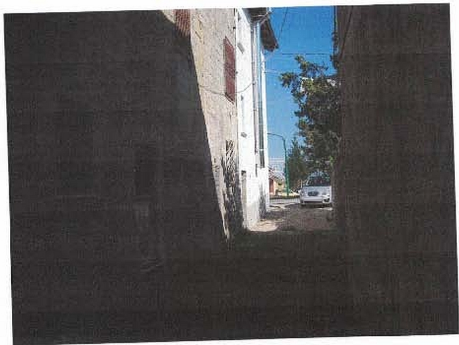
VICOLETTO DI ACCESSO AL FABBRICATO - FOTO 1 DI 4
