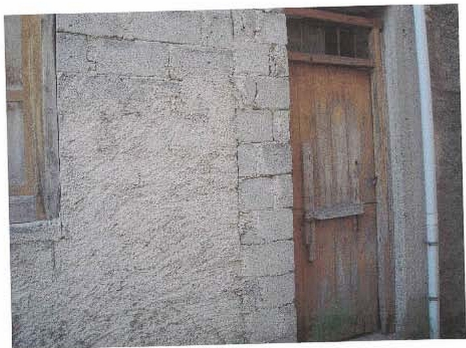
INGRESSO FABBRICATO - FOTO 2 DI 4
