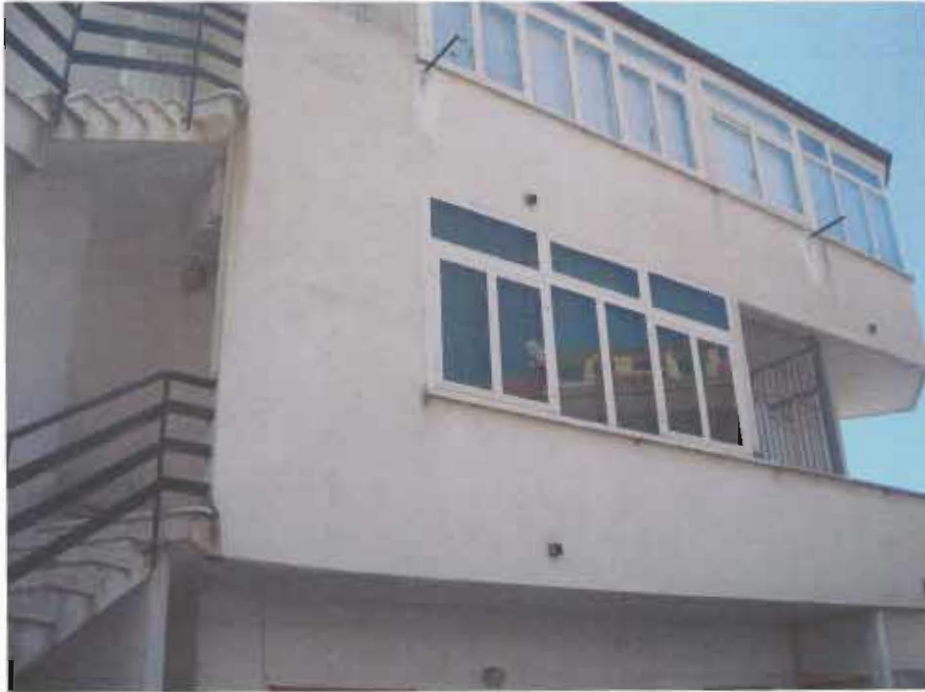
ABITAZIONE PIANO PRIMO
