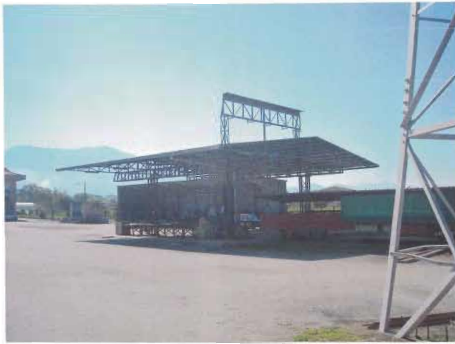
PIAZZALE CON STRUTTURE METALLICHE
