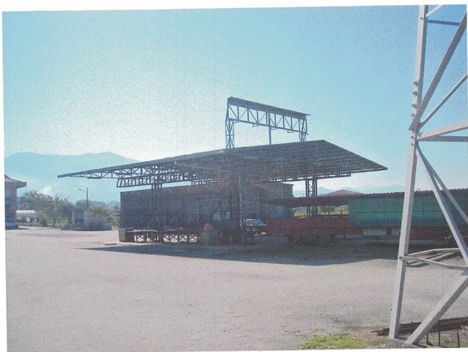
PIAZZALE CON STRUTTURE METALLICHE - FOTO 2 DI 5
