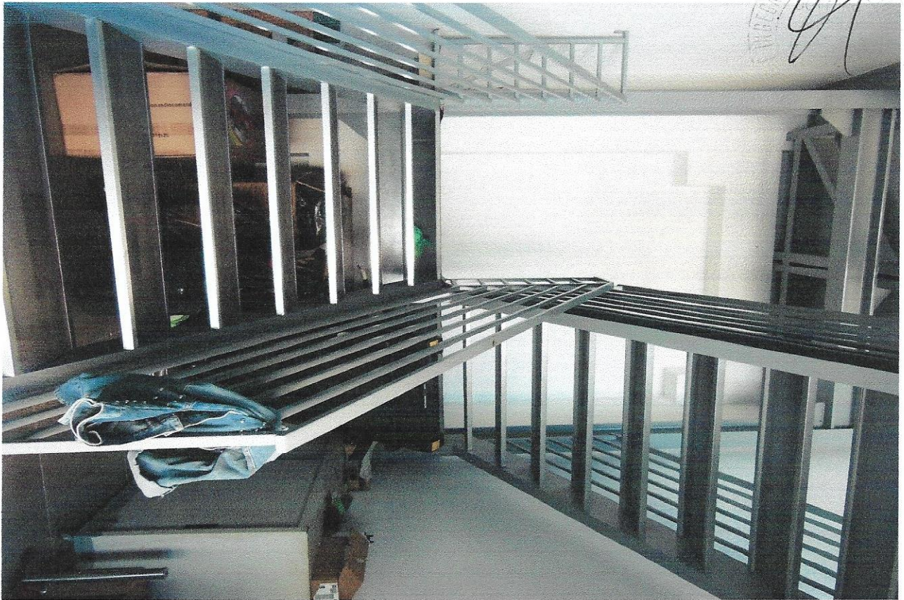
17 – Part. scala di collegamento appartamento
