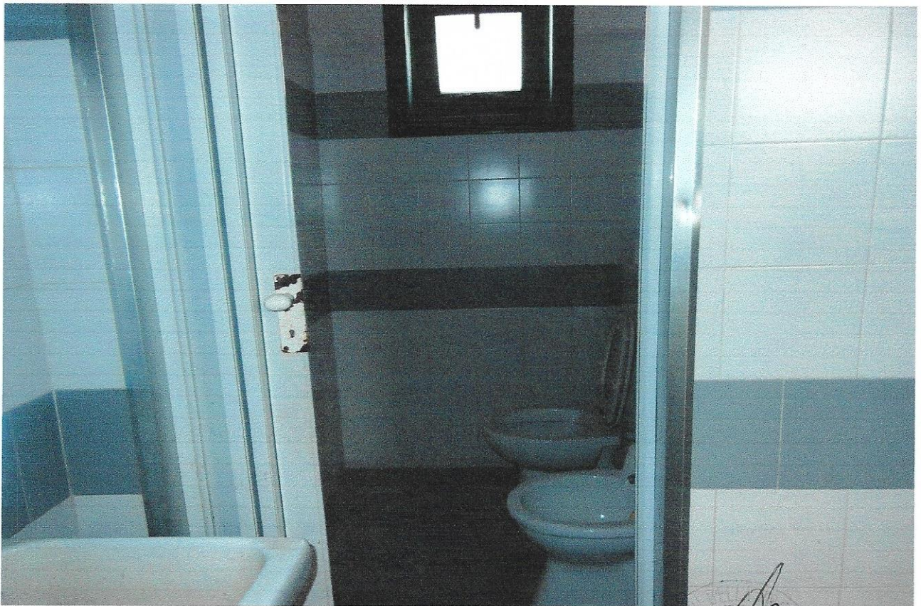
6 – Part. servizi igienici capannone
