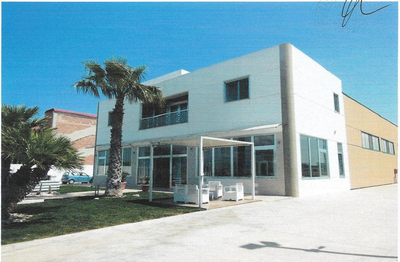
15 – Part. prospetto appartamento
