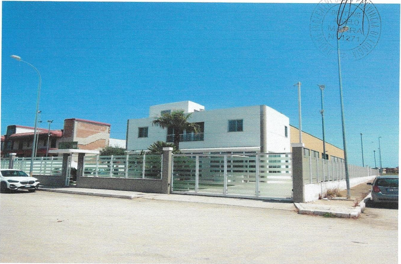
1 – Part. prospetto generale compendio immobiliare
