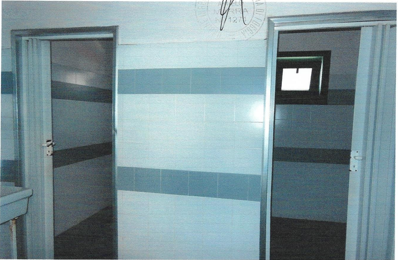
5 – Part. spogliatoi capannone
