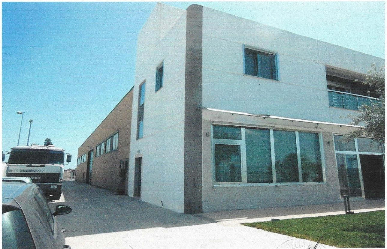
14 – Part. prospetto appartamento
