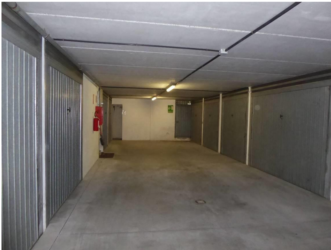
Foto 23 – ingresso garage piano interrato
