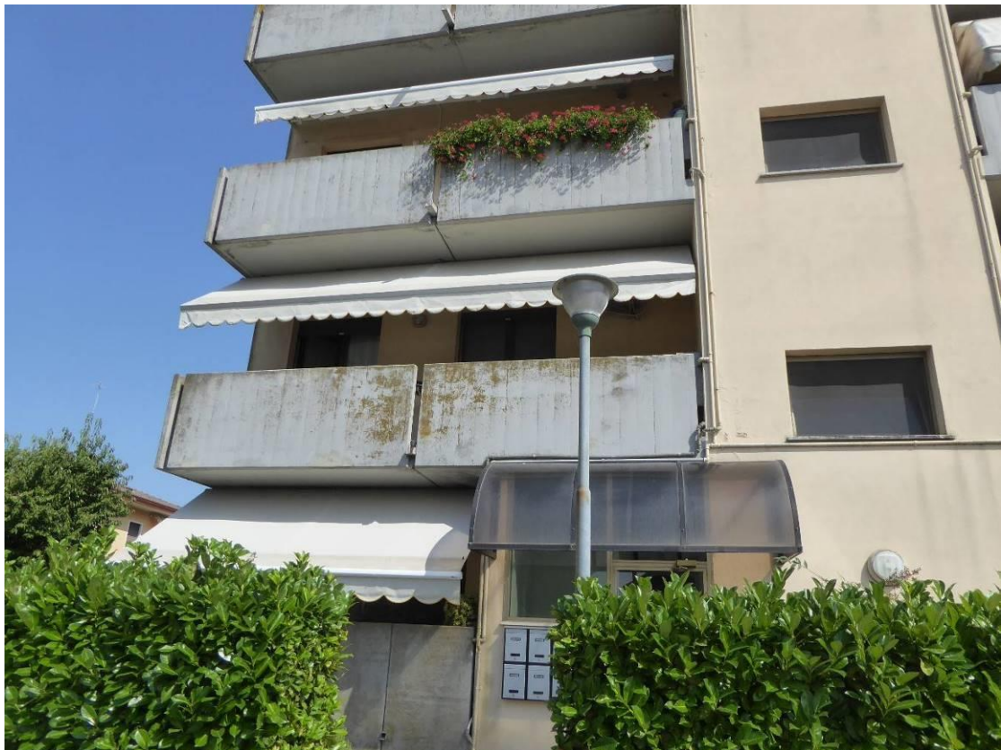
Foto 2 – Vista ingresso condominiale e abitazione piano 1°
