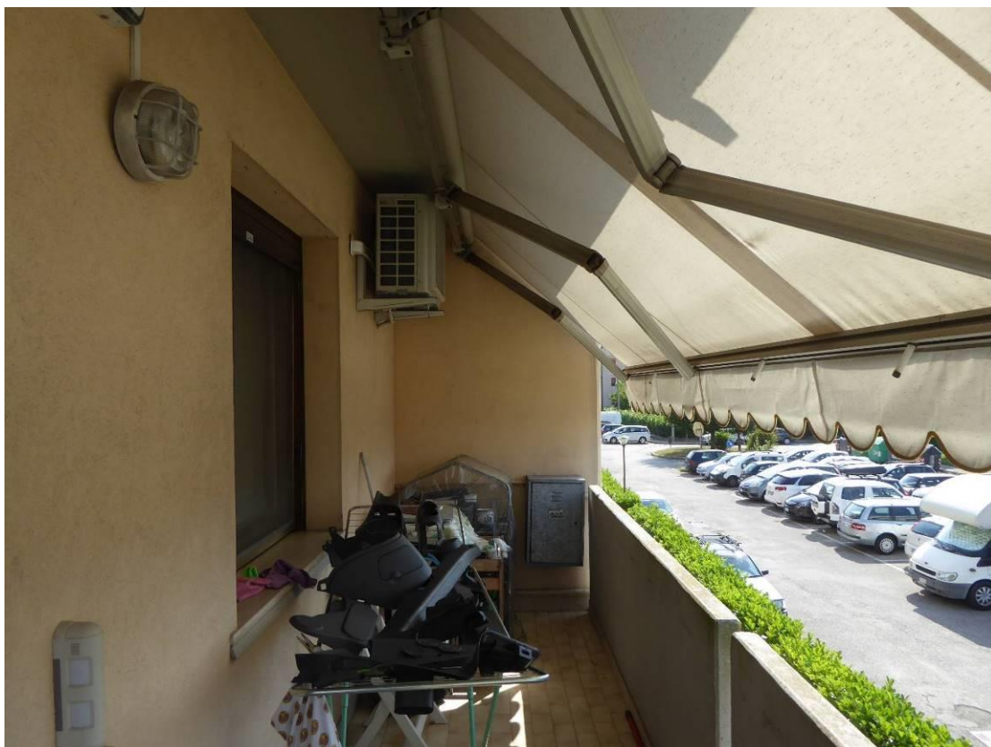
Foto 4 – balcone fronte Est
