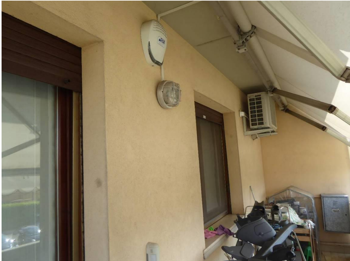
Foto 5 – balcone fronte Est
