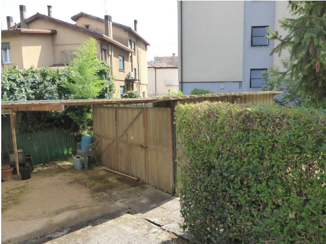
Foto 1 – Vista garage sub. 5
