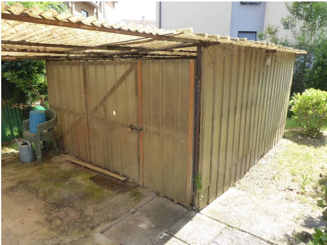
Foto 4 – vista garage sub. 5
