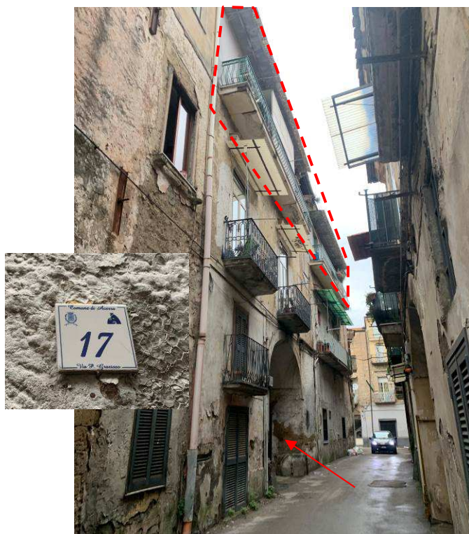
Prospetto principale dalla Via Pasquale Grazioso
