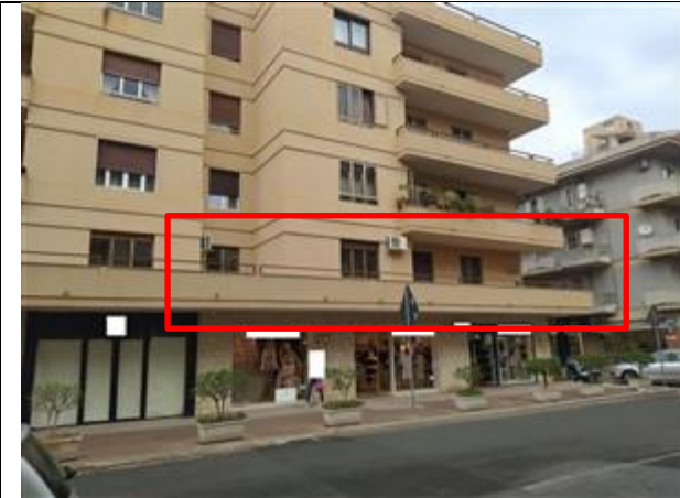
Foto n. 1: Prospetto via Sacro Cuore
