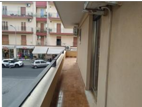
Foto n. 14: Balcone lato strada privata
