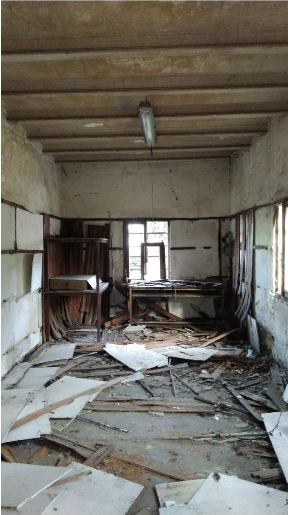
INTERNO DEL LOCALE "D", SOLAIO CON TRAVI "VARESE" E TAVELLONI
