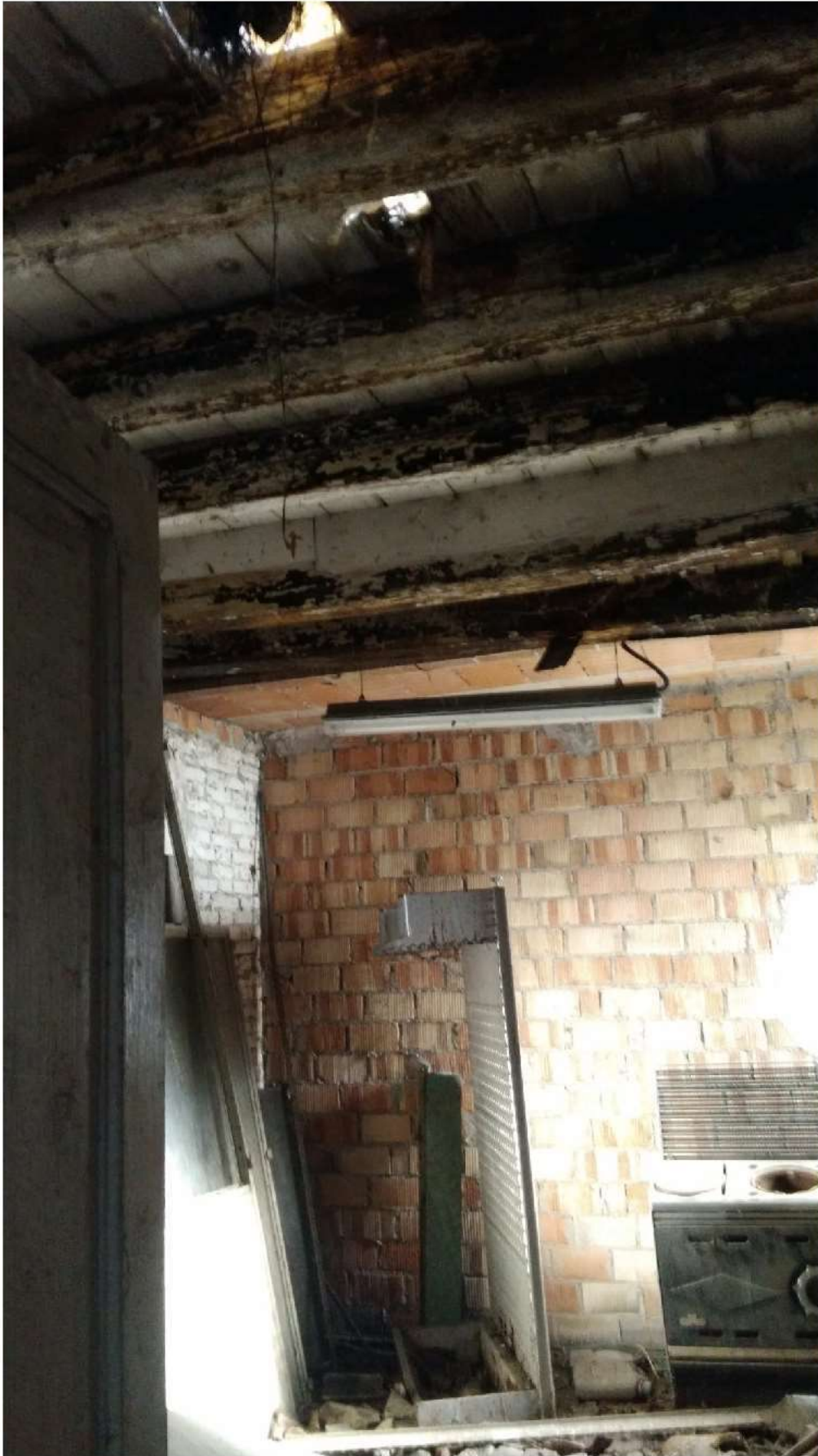
INTERNO DEL LOCALE "G", CON SOLAIO IN LEGNO E IN PARTE IN LATEROCEMENTO. LA PARETE IN BLOCCHI DI LATERIZIO DELIMITA GLI ADIACENTI LOCALI "H" E "W" (servizi igienici)
