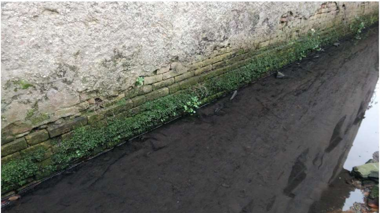
DETTAGLIO DELLA MURATURA DELLA PORZIONE "ALTA" IMMERSA NEL FOSSATO
