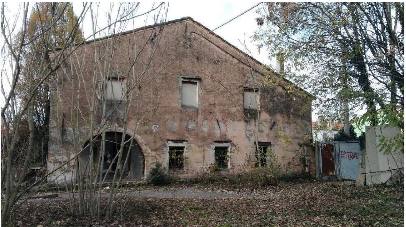
VISTA DEL LATO EST DELL'EDIFICIO OGGETTO DELLA PERIZIA (prima della chiusura degli ingressi)
