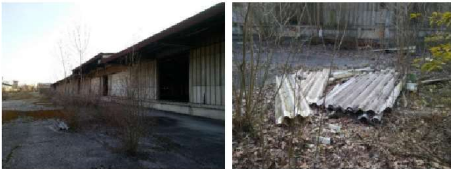
Facciate est del Corpo B e particolare pannelli copertura
