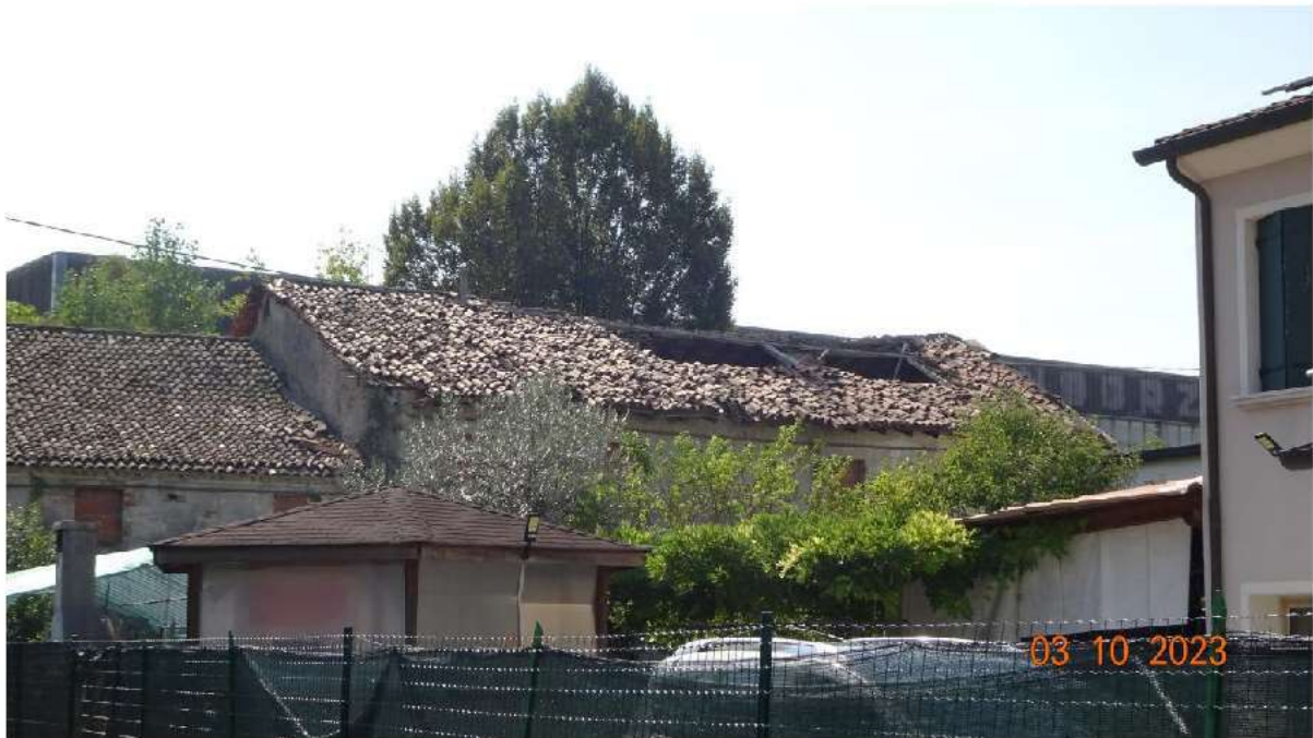
Implosione della copertura
