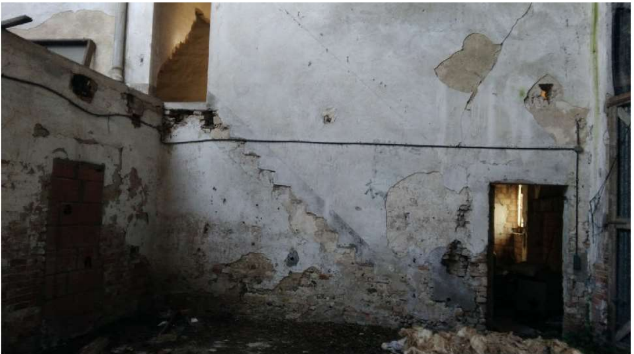
PARETE EST DEL LOCALE "F", CON TRACCE DELLA SCALA DI ACCESSO AL PIANO PRIMO. A DESTRA LA PORTA DI ACCESSO AL LOCALE "G"
