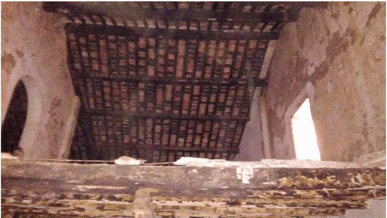
FOTO DAL LOCALE "C" CON VISTA DELLA FALDA SUD DELLA COPERTURA E IN PRIMO PIANO LA TESTA DEL SOLAIO INTERMEDIO
