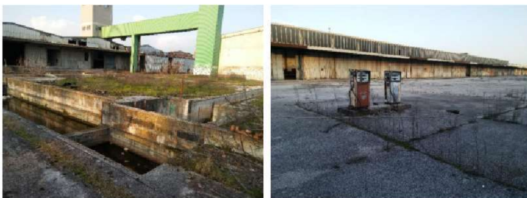
Vasche a cielo aperto e zona cisterne interrato combustibile
