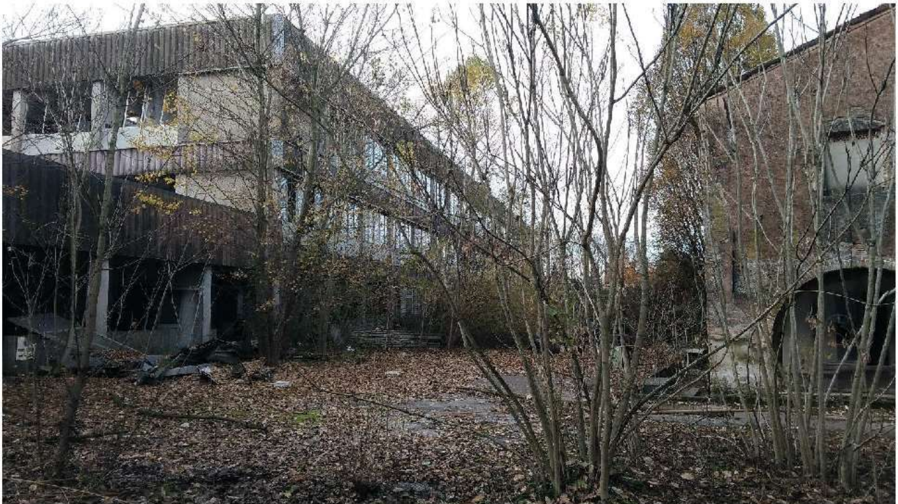
VISTA DA EST DELL'EDIFICIO OGGETTO DELLA PERIZIA E DELL'EDIFICIO PRINCIPALE EX CONSORZIO AGRARIO (prima della chiusura degli ingressi)
