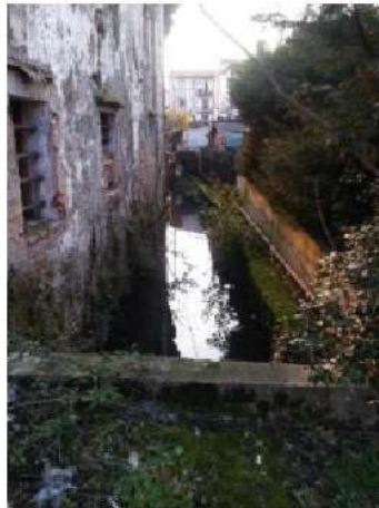
Particolare canale su fronte nord del mn. 83
