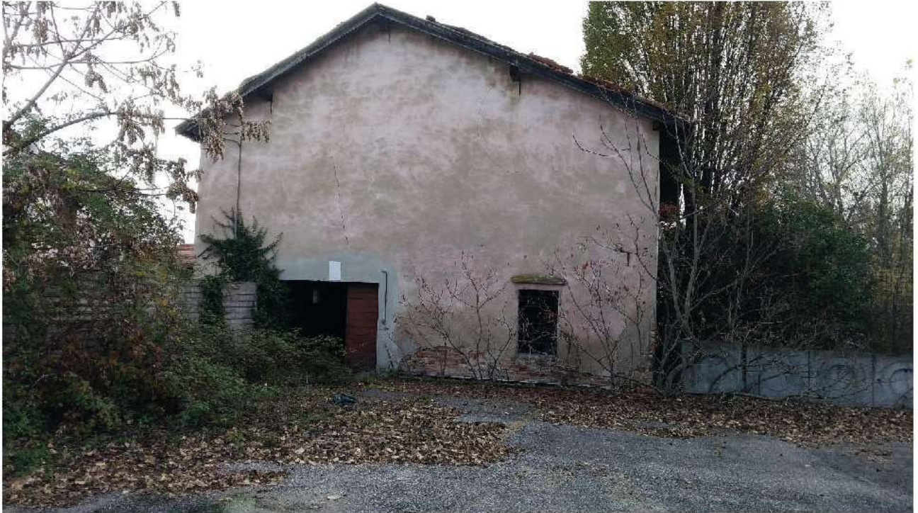
VISTA DEL LATO OVEST DELL'EDIFICIO OGGETTO DI PERIZIA DAL PIAZZALE INTERNO EX CONSORZIO. IL MURO IN PANNELLI PREFABBRICATI VISIBILE A SINISTRA DELIMITA IL FOSSATO.
