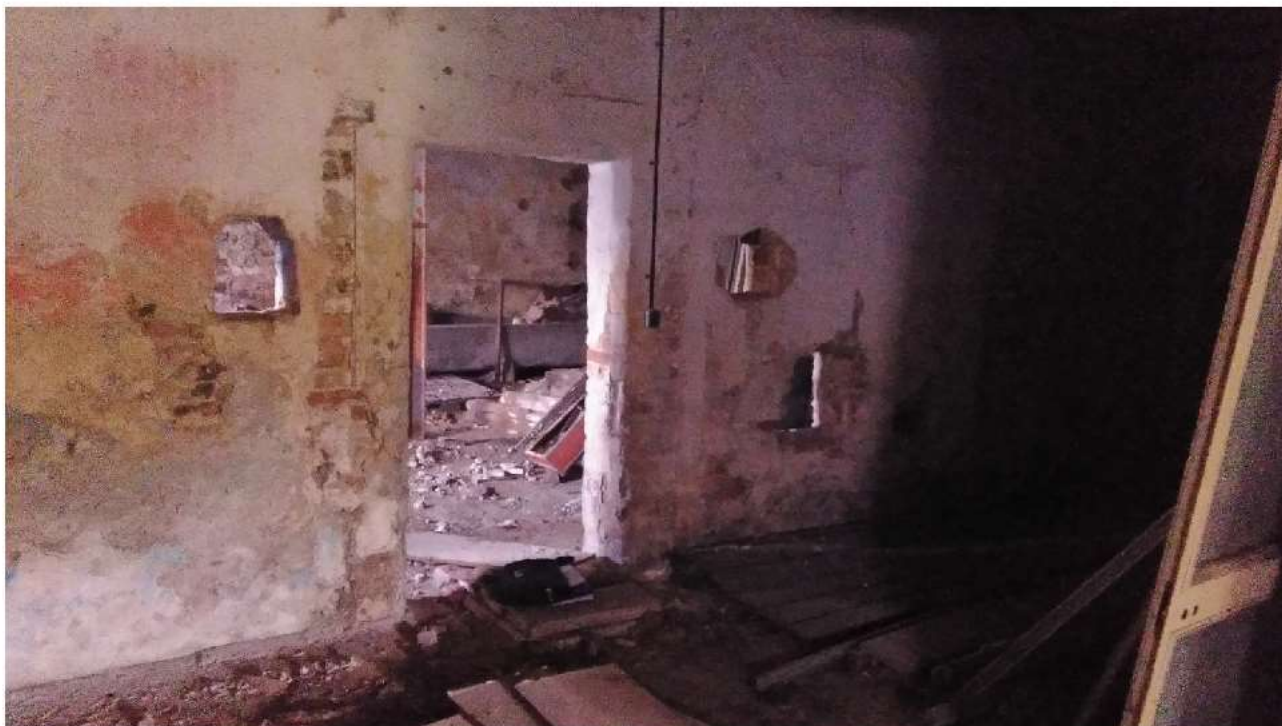
INGRESSO AL LOCALE "C", VISTO DAL LOCALE "B"
