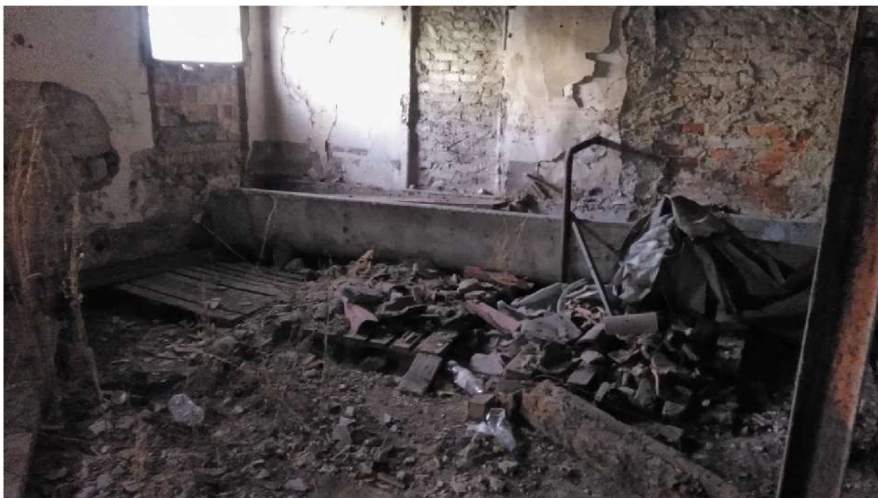
INTERNO DEL LOCALE "C" – PARETE EST / ANGOLO CON PARETE NORD
