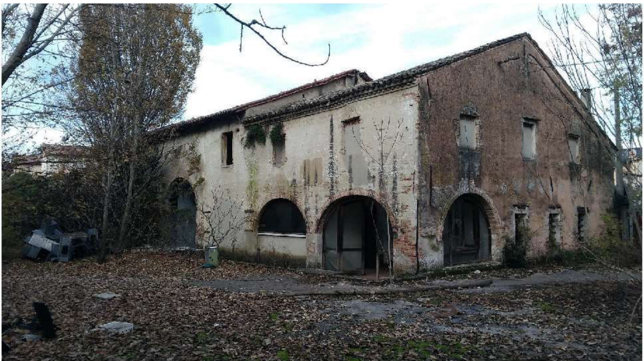
VISTA DEL LATO SUD / EST DELL'EDIFICIO OGGETTO DI PERIZIA (prima della chiusura degli ingressi) L'ARCO PIU' ALTO VISIBILE A SINISTRA E' L'INGRESSO AL LOCALE "F" A DOPPIA ALTEZZA, MENTRE GLI ARCHI PIU' BASSI POSTI IN ANGOLO COSTITUISCONO L'INGRESSO AI LOCALI "L" - "D" - "H"
