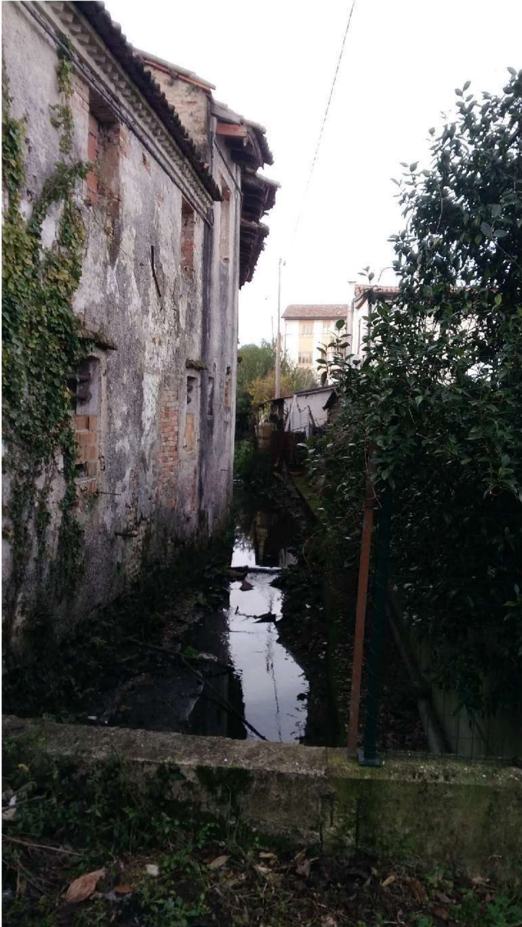
VISTA DEL LATO NORD DELL'EDIFICIO OGGETTO DI PERIZIA, PROSPETTANTE SUL FOSSATO
